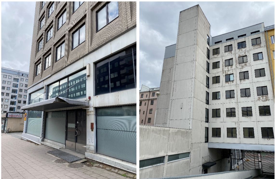
Kuva 5. Matintalon julkisivu kadun puolelta ja sisäpihan puoleinen ulkoseinä (FCG Oy, 2021)
