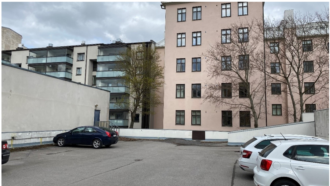
Kuva 26. Näkymä keskimmaiselta parkkitasolta. Oikeassa reunassa näkyy ajoramppi ylimmälle tasolle. Vasemmassa reunassa näkyy naapuritontin rakennus ja ovi, joka toimii rakennuksen hätäpoistumisreitinä kaava-alueen läpi. (FCG, 2021)
