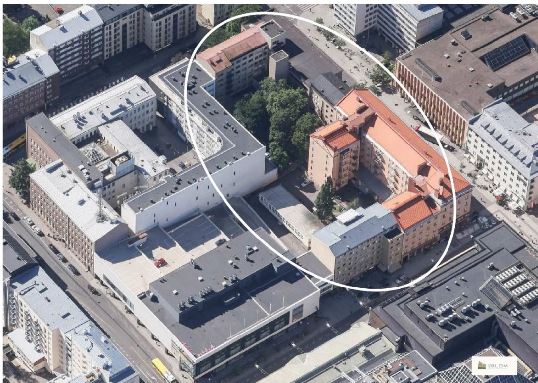
Kuva 2. Ilmakuva kaavanmuutosalueesta (© Blom.)
