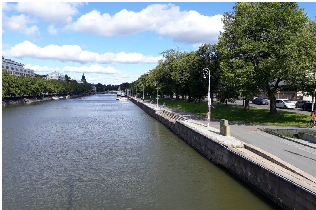
Kuva 8. Näkymä Myllysillalta koilliseen, suunnittelualue sijaitsee edustalla. Rantamuriin liittyy joelle laskeva leveä portaikko.
