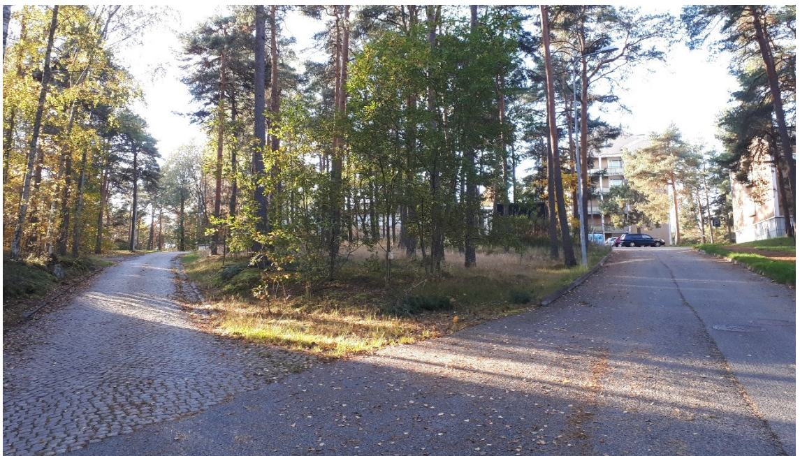
Kuva 14. Vanhainkodille johtava ajoyhteys haarautuu mäen puolella välissä. Toinen ajoyhteyksistä on päällystetty viuhkaladotulla nupukiveyksellä.
