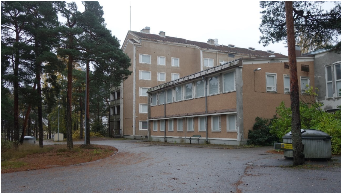
Kuva 9. Vasemmalla entisen vanhainkodin idänpuolen asuinsiipi ja keskellä entinen päärakennus.
