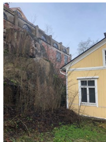
Kuva 27. muuriin rajautuvan asunnon ikkunat
