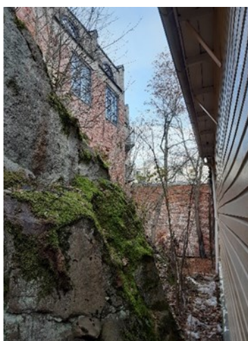
Kuva 8. Ikkunat naapurin muurissa
