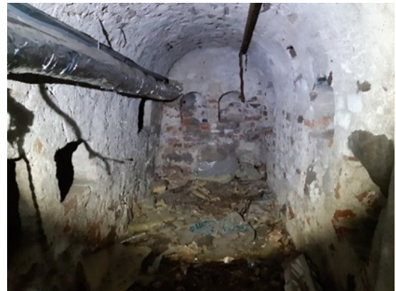
Kuva 16. Kellari asunnon 4 alla
