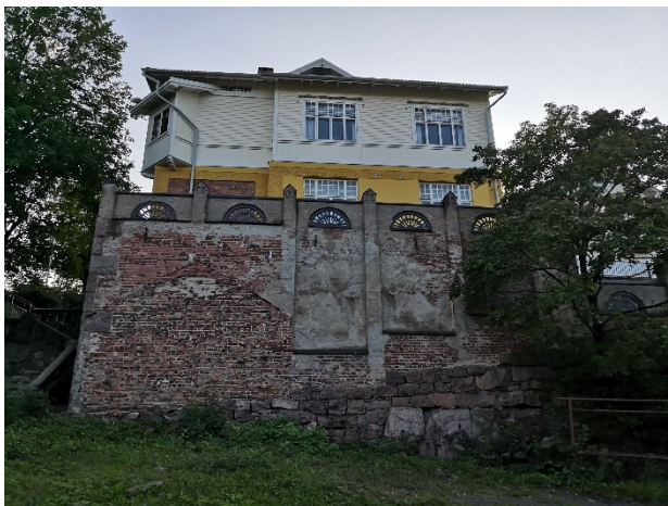
Kuva 26. As Oy Samppalinnan muuri
