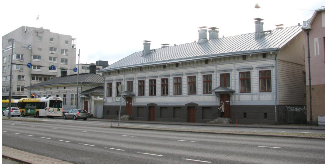
Kuva 9: Suojeltuja rakennuksia osoitteessa Itäinen Pitkätie 17 Uudenmaankadun varrella. (Kuvannut Satu Tiainen 24.10.2017.)
