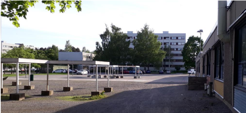
Kuva 3. Valokuva koulun välituntipihalta kesällä 2018. (Koulu suljettiin v.2015.)
