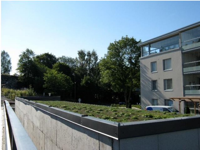
Kuva 5. Viherkatto autotallin päällä Turussa.
