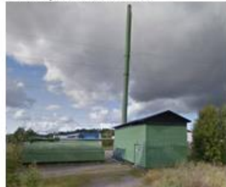
6. Lämpökeskus ja öljysäiliöt
