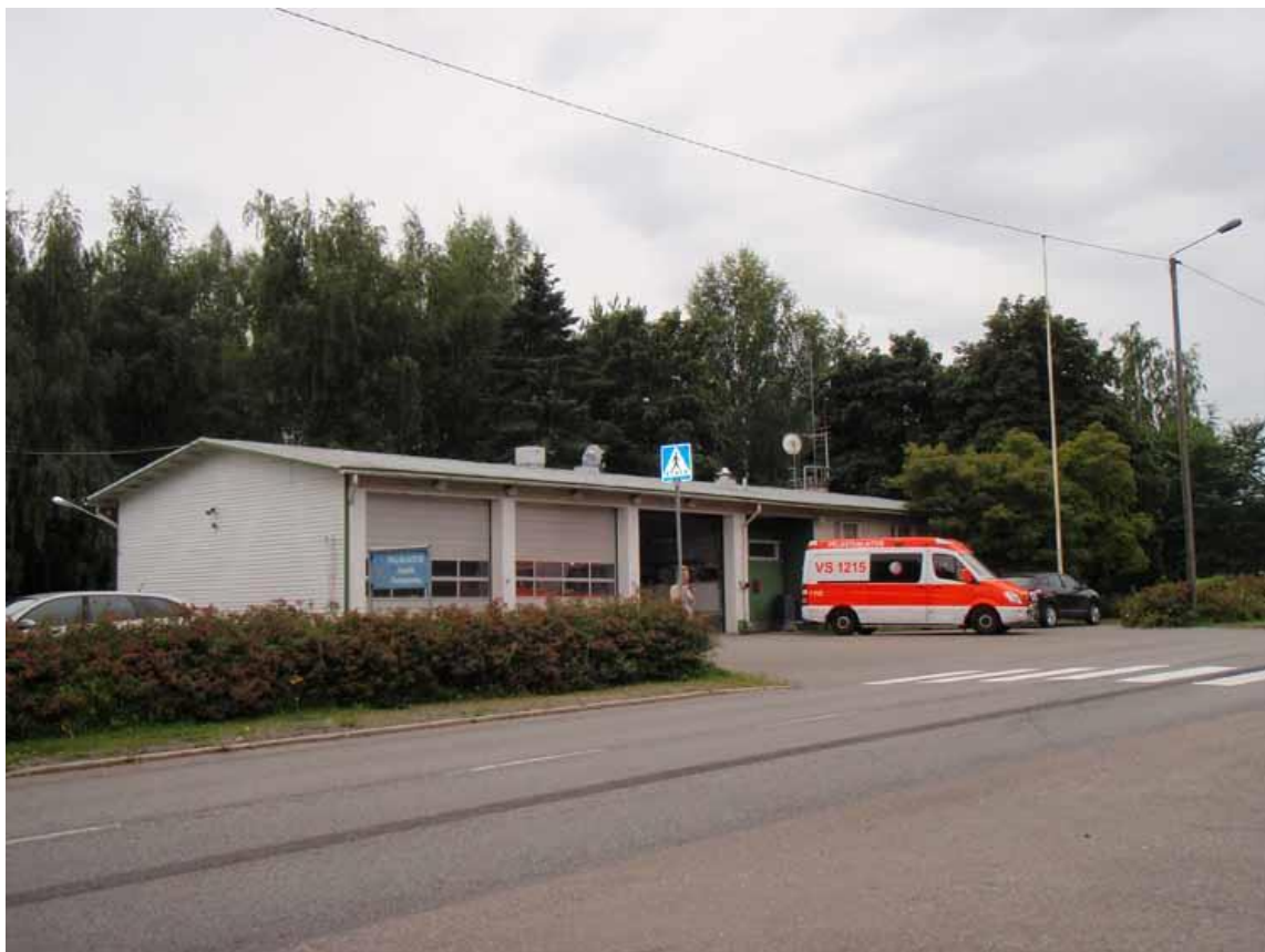
JAAININ PALOASEMA, 13.8.2015 / MW
