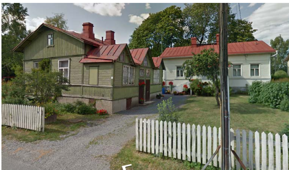
Muutosalueen rakennukset Kokkokadulta kuvattuina
