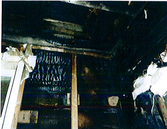
19. As. 8 keittiö, laipio palanut puhki, tuli levinnyt seinän ilmaraossa alaspäin
