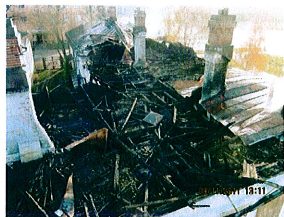
6. Vesikatto ennen suojausta
