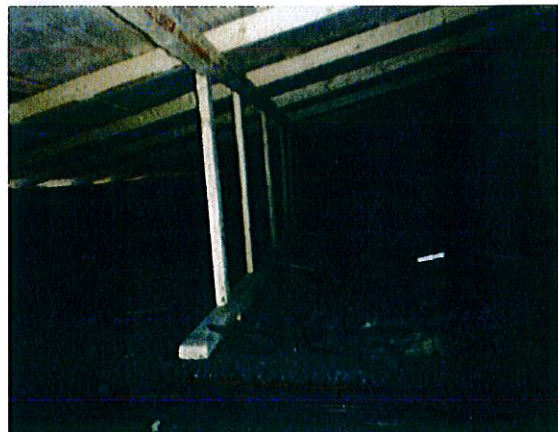
30. Palanutta yläpohjaa pääsiivessä kadulle päin
