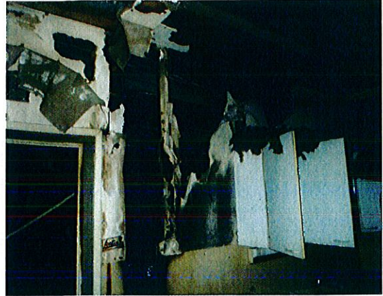
26. As. 10 huoneen väliseinä
