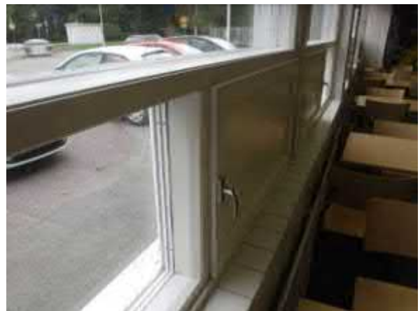
Ikkunat ovat kokonaisuutena tyydyttävässä kunnossa
