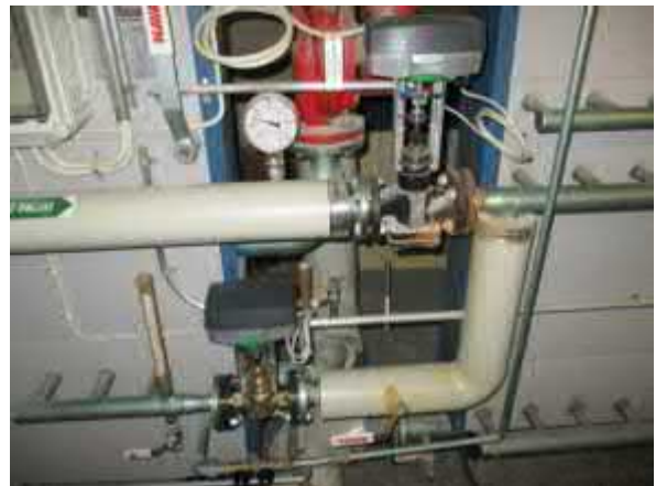
Lämmönjakokeskusta on huoltokorjattu tarpeen mukaan
