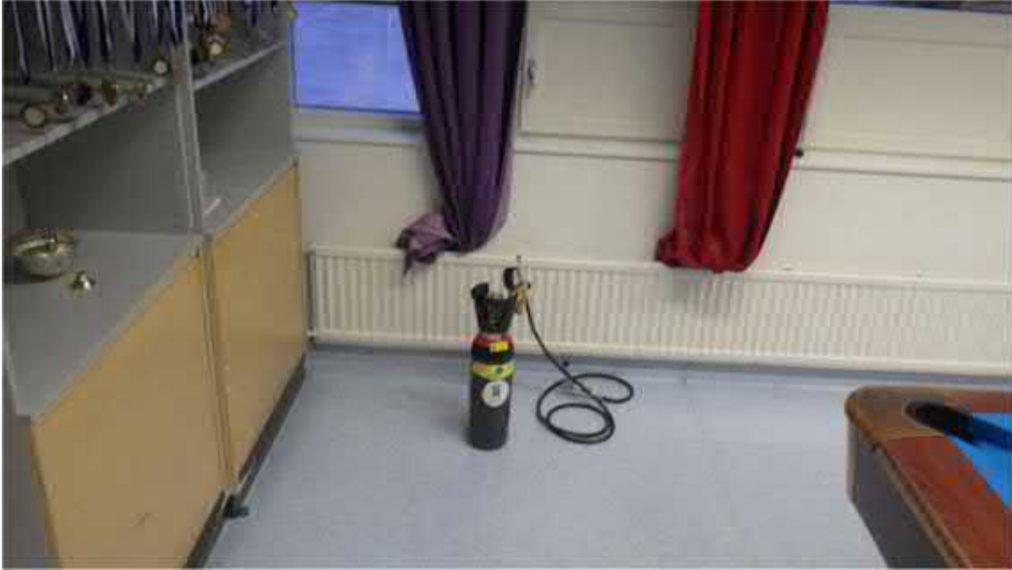
Kuva 12. Merkkiainekaasukokeessa merkkiainekaasu annosteltiin seinän alaosiin.
