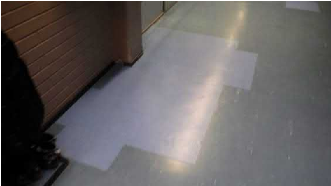
Kuva 11. Alueella on korjattu vanha kosteusvaurio.
