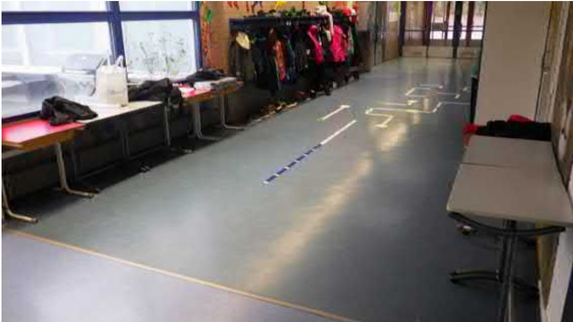
Kuva 10. Vanhaa muovimattoa ja uusittua muovimattoa.
