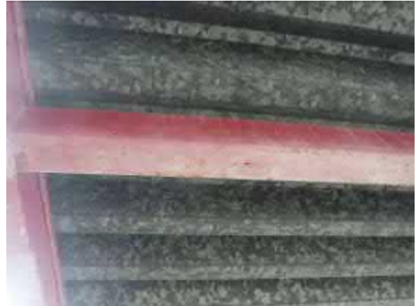
Katoksen teräsosissa korroosioaurioita
