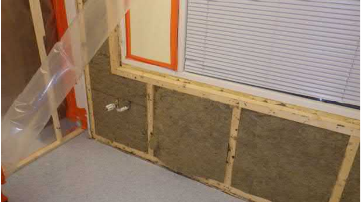
Kuva 22. Seinärakenteen avaus sisäpihan puolella sijaitsevaan perhetuvan ryhmätilaan.
