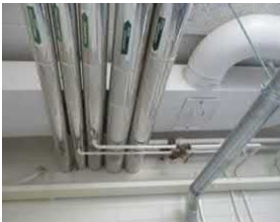
Alkuperäisiä lämpö- ja vesijohtoja
