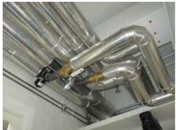
Uusittuja linjaventtiileitä
