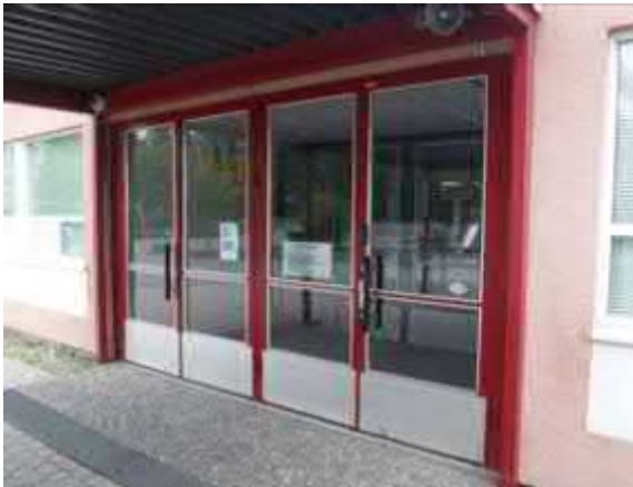
Ulko-ovia, jotka on sääsuojassa katoksen alla
