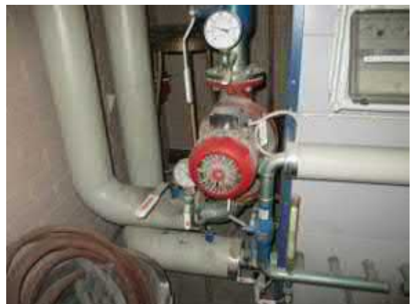
Lämmityksen kiertovesipumppu
