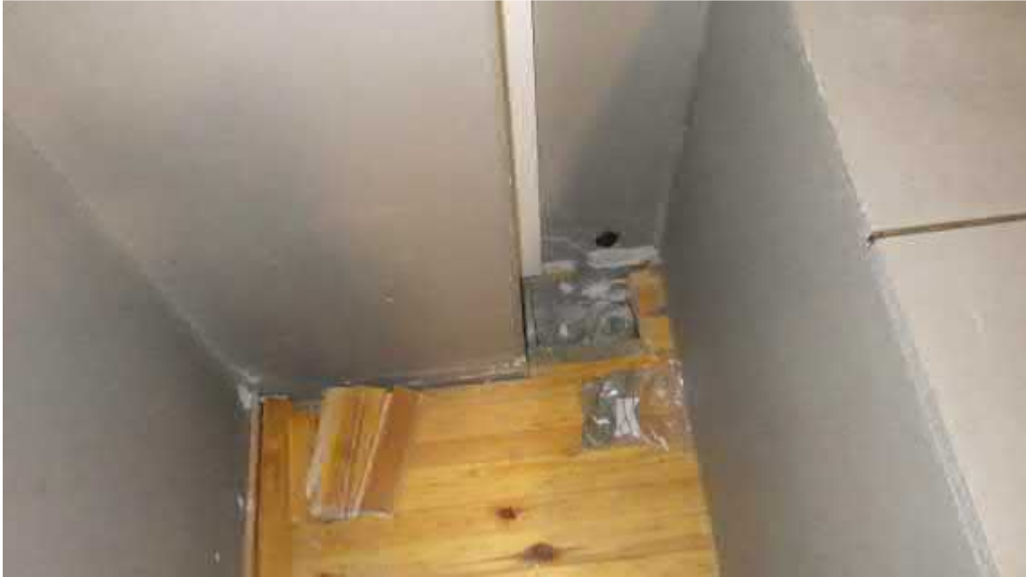
Kuva 18. Liikuntasalin varaston ulkonurkkaan tehty rakenneavaus.
