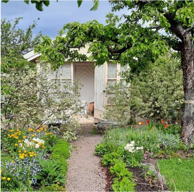
Alkuperäinen kalanruotokuvioinen ulko-ovi on säilytetty väliovena (kuva: Tuuli Vesanto).
