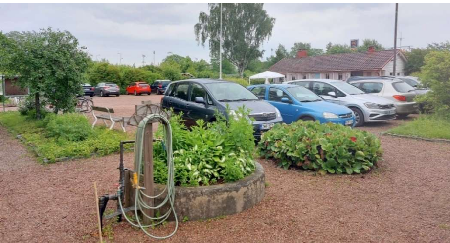
Kaivomaista betonirakennetta on käytetty vesijohtoveden lämmittämiseen ennen kastelua (kuva: Samuli Saarinen).
