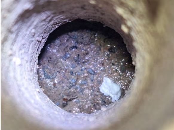
Kuva 17. Rakenneavaus AP1. Kuvassa näkyvä EPS:n palanen on maanvastaisesta seinästä.
