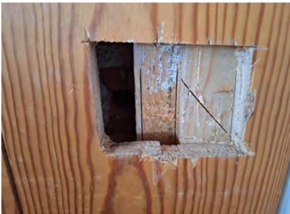
Kuva 150. Puupaneelin takana on koolauspuut
