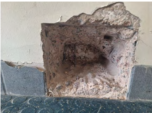
Kuva 31. Rakenteessa on EPS-lämmöneriste.
