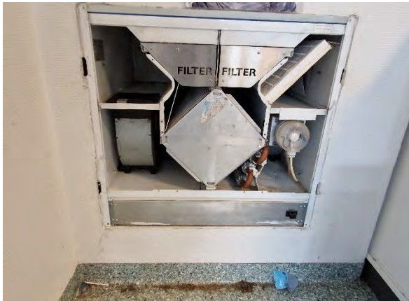
Kuva 198. TK10 palvelee toimistotiloja 153 ja 154. Konekammio oli melko puhdas.
