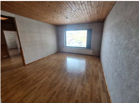
Kuva 121. Asuinhuoneiston lattiassa on muovimattoa, seinät on tapetoitu. Katossa on puupanelointi.
