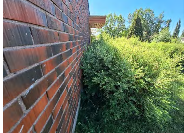
Kuva 189. Kasvillisuus kasvaa kiinni rakennuksen ulkoseinässä.
