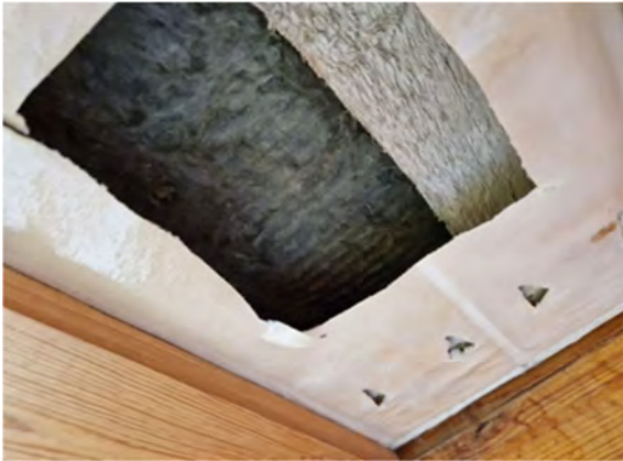
Kuva 186. Muovipintaisen ilmansulkupaperin alla on mineraalivillaeriste.
