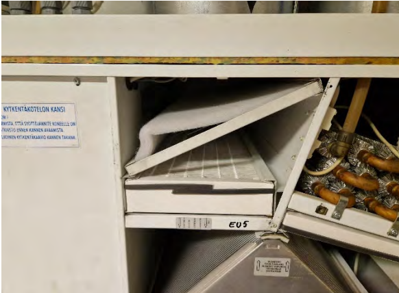
Kuva 210. TK09 palvelee tilan 152 yhteydessä olevaa eteistilaa. Karkeasuodatin on liian iso ja mahdollistaa ohivuodon.
