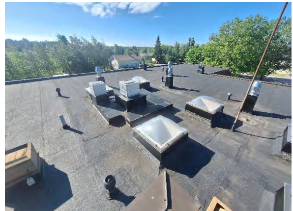
Kuva 171. Yleiskuvaa vesikatolta. Erilaisia läpivientejä on runsaasti.
