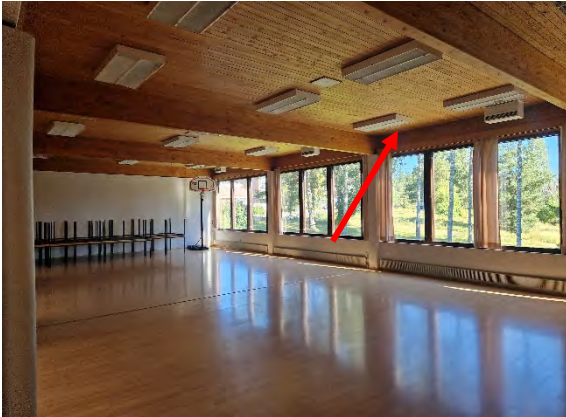
Kuva 184. Avaus tehtiin lähelle ulkoseinää.
