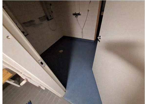
Kuva 9. Naistenpuolen mökkätilan pintamateriaalit on uusittu, kosteuspoikkeama-alueita ei havaittu.
