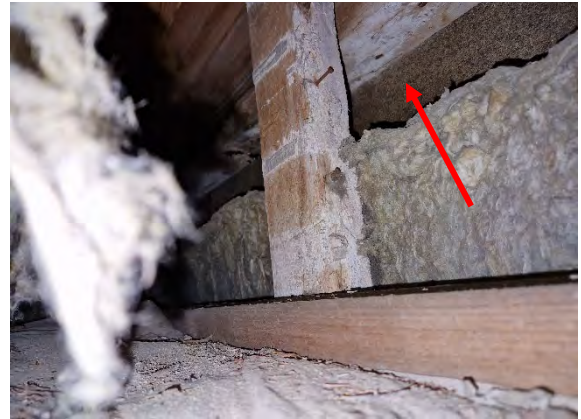
Kuva 187. Ulkoseinän yläosassa on tuulensuojalevy.
