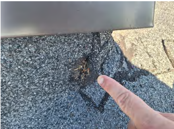
Kuva 170. Bitumikermin vaurioita.
