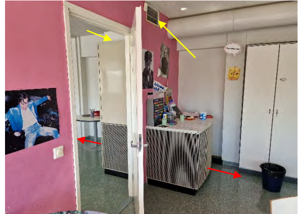
Kuva 205. Ryhmähuoneen 152 TK04 iv-kone palvelee myös ryhmähuonetta 151.
