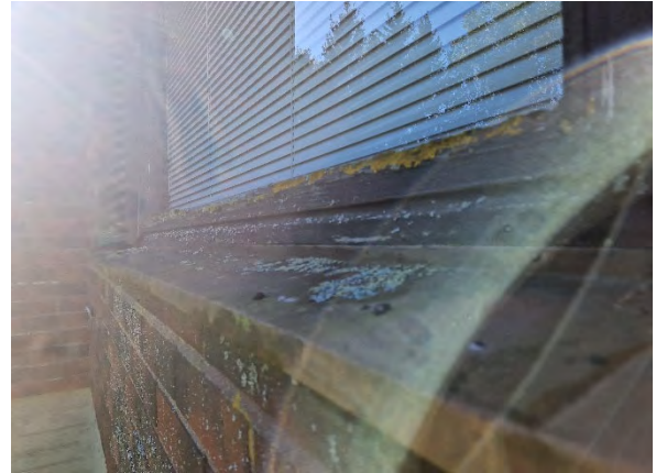
Kuva 54. Vesipeltien kaadot ovat melko loivia.
