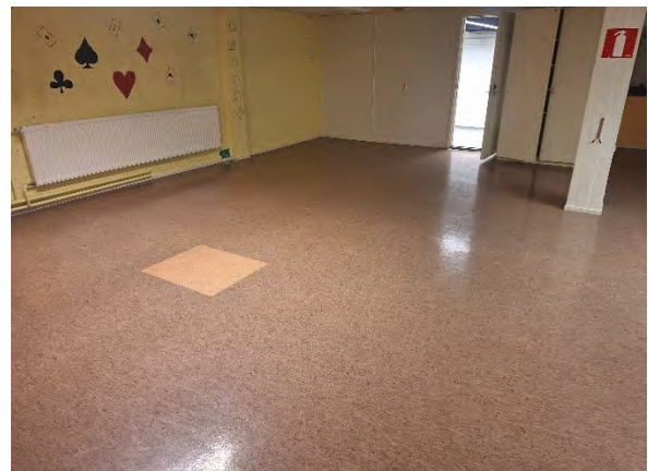
Kuva 7. Vanhassa nuorisotilassa on linoleumi. Taustalla näkyvän uimahallin vastaisen keltaisen väliseinän kohdalla oli selvästi aistittavissa oleva mikrobiperäinen haju.
