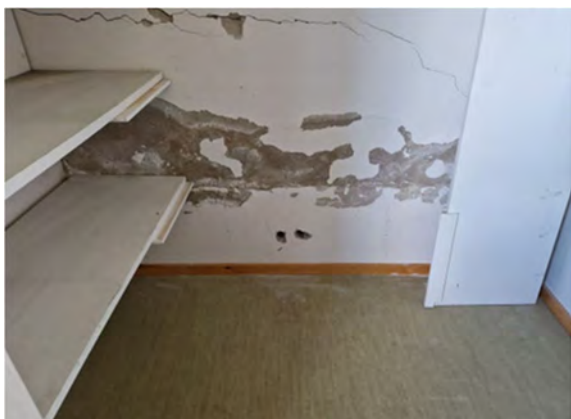
Kuva 160. Avaus tehtiin väliseinän alaosaan nuolen osoittamaan kohtaan.
