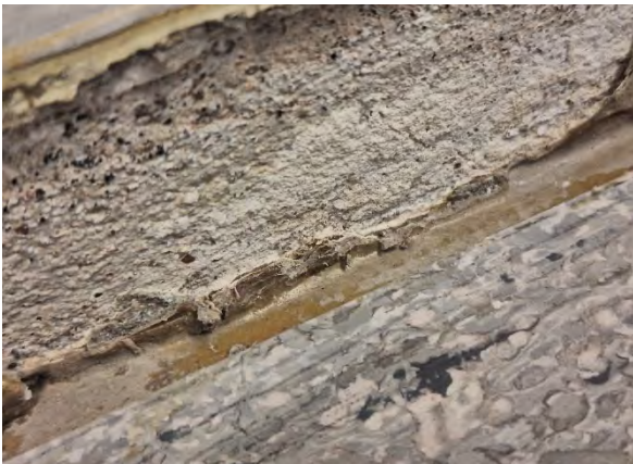
Kuva 99. Tilan 120 lattian liittymä on visuaalisesti arvioituna tiivis.
