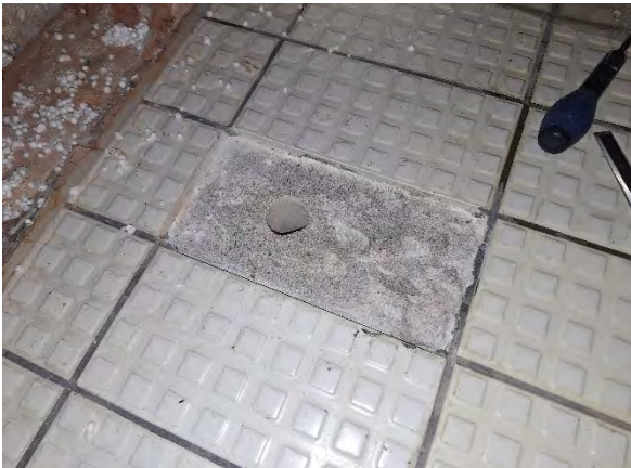
Kuva 19. Avaus tehtiin uima-altaan läheisyyteen maanvastaisen seinän viereen.
