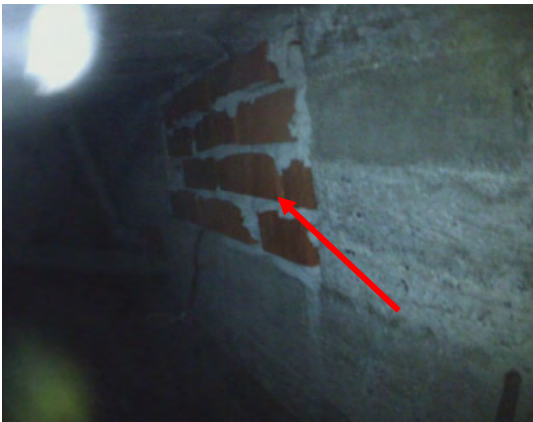
Kuva 156. Yleiskuvaa kanaalin sisältä. Tasoeron kohdalla on tiilimuurauksella suljettu työaikainen aukko.
