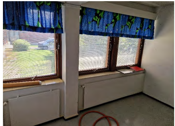
Kuva 56. Alkuperäisiä puisia kippi-ikkunoita, joiden toimivuudessa ja tiiveydessä esiintyy paikoin puutteita.
