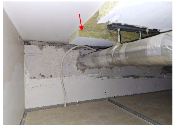
Kuva 179. Alakattojen päällä on yksittäisiä kuitulähteitä.
