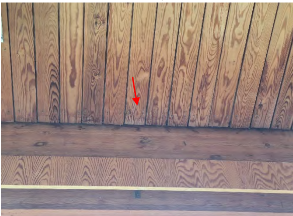
Kuva 178. Sisäkaton vuotojälkiä.
