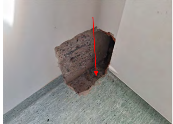
Kuva 130. Avaus tehtiin rakennuksen sisänurkkaan nuolen osoittamaan kohtaan.
