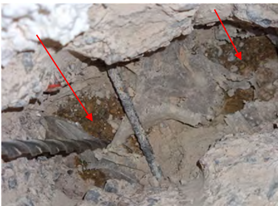
Kuva 27. Rakenteen pohjalla on pinnaltaan kosteaa sora.
