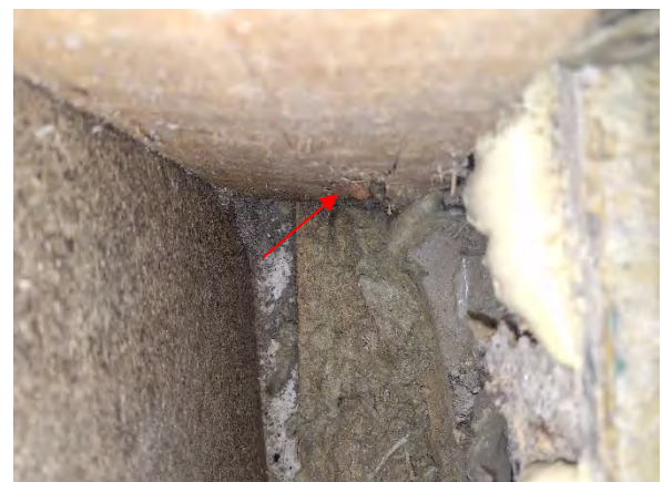
Kuva 74. Kuva ylhäältä alaspäin kohti alaohjauspuuta. Alaohjauspuuna on käytetty lautaa. Runkotolpan nauloissa on korroosiota (nuoli).
