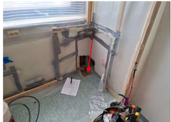
Kuva 133. Avaus tehtiin rakennuksen sisänurkkaan nuolen osoittamaan kohtaan.
