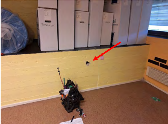
Kuva 146. Avaus tehtiin putkikanaalin kohdalle.
