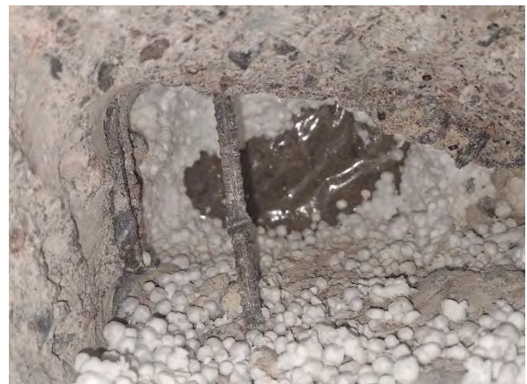
Kuva 32. Teräksissä ei ole näkyvää korroosiota.
