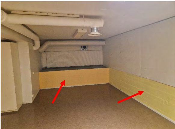
Kuva 115. Tilassa 004 oleva betonirakenteinen kanaali.
