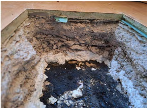
Kuva 127. Rakennevauksen rakennekerrokset.
