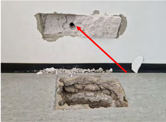
Kuva 162. Avaus tehtiin väliseinän alaosaan.
