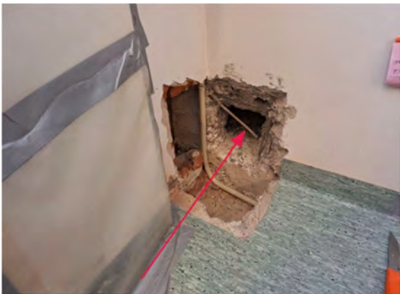
Kuva 69. Avaus tehtiin sisäkautta lähelle rakennuksen ulkonurkkaa.
