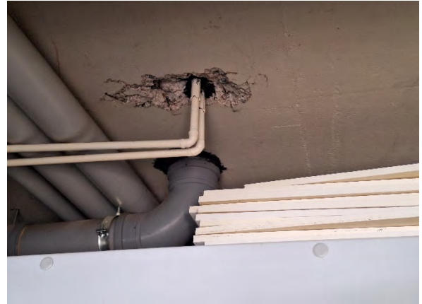
Kuva 114. Teknisen tilan läpivientejä on tiivistetty massaamalla.
