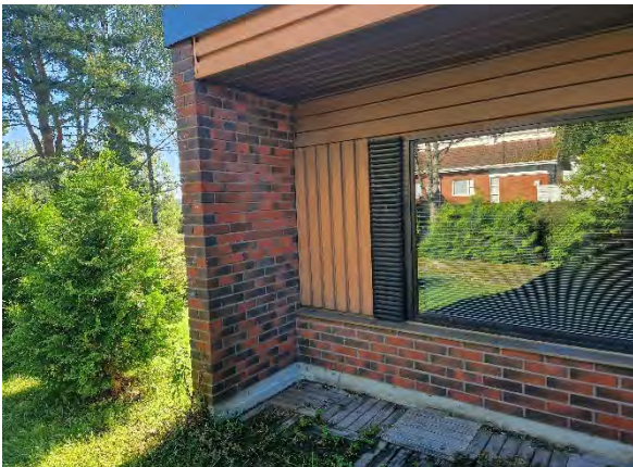
Kuva 57. Asuinhuoneiston kohdalla olevia julkisivun puurakenteita.
