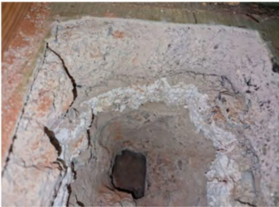
Kuva 25. Rakenteessa on EPS-lämmöneriste.
