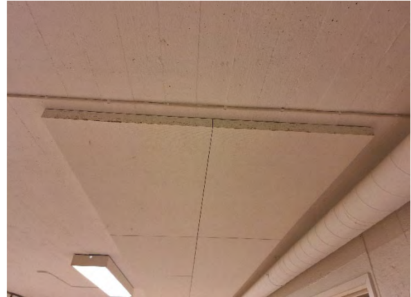
Kuva 181. Mineraalivillaiset ja reunamaalatut akustiikkalevyt on liimattu yläpohjaan.
