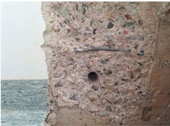
Kuva 62. Avaus tehtiin sisäkautta lähelle rakennuksen ulkonurkkaa.
