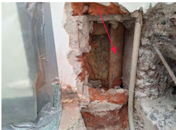
Kuva 66. Rakenteen sisällä oli puukoolaus rakennuksen nurkalla.
