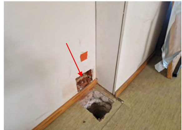
Kuva 154. Avaus tehtiin väliseinän alaosaan nuolen osoittamaan kohtaan.
