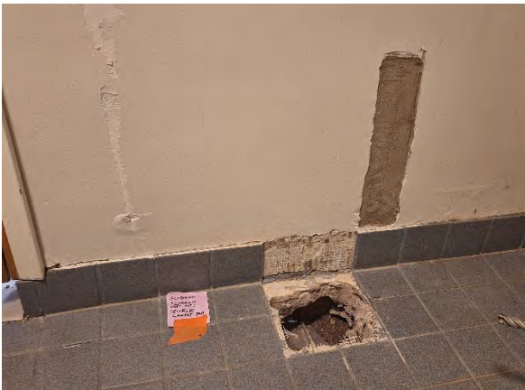
Kuva 21. Avaus tehtiin käytävälle miesten pukuhuoneeseen rajautuvan väliseinän kohdalle.
