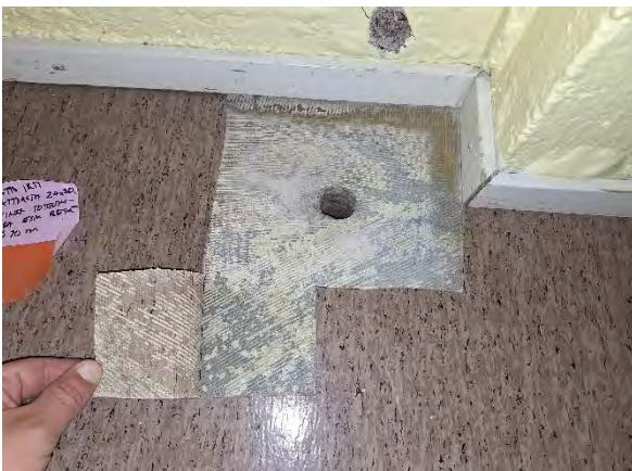
Kuva 29. Matossa on kangaspohja ja voimakas mikrobipe- räinen haju.
