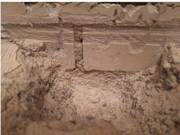
Kuva 23. Alapohjan ja väliseinän liittymä.
