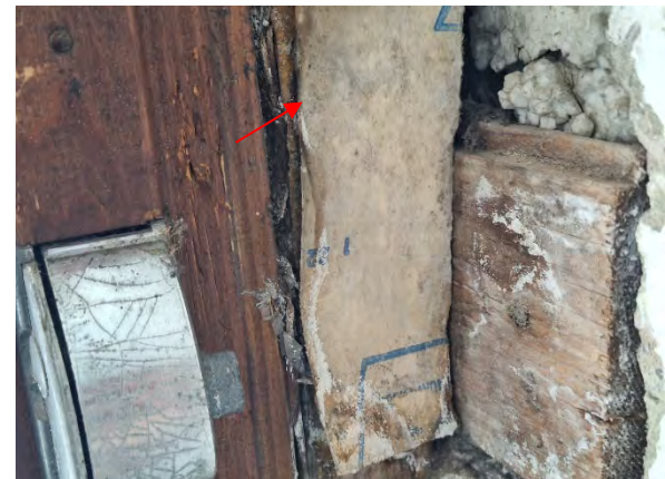
Kuva 94. Ikkunaliittymän materiaaleissa on näkyvää mikrobikasvustoa.
