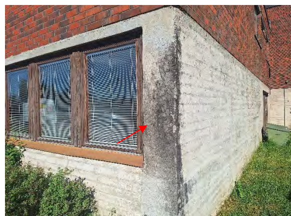
Kuva 60. Avaus tehtiin nuolen osoittamaan kohtaan ulkokautta.
