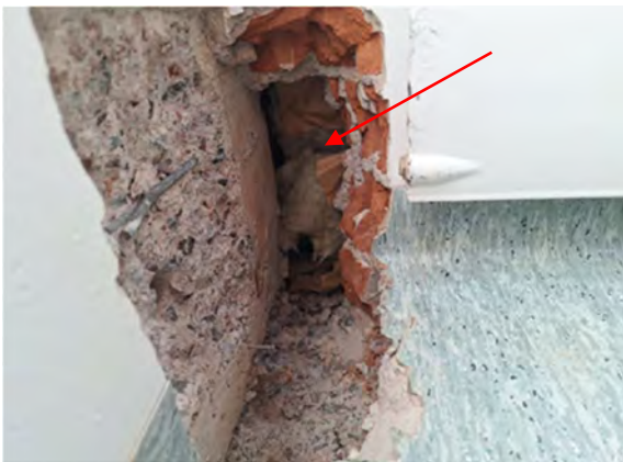
Kuva 64. Avaus tehtiin sisäkautta lähelle rakennuksen ulkonurkkaa.
