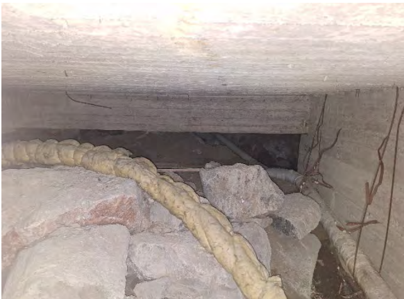
Kuva 16. Öljysäiliötilan viereinen alapohjan ryömintätila.
