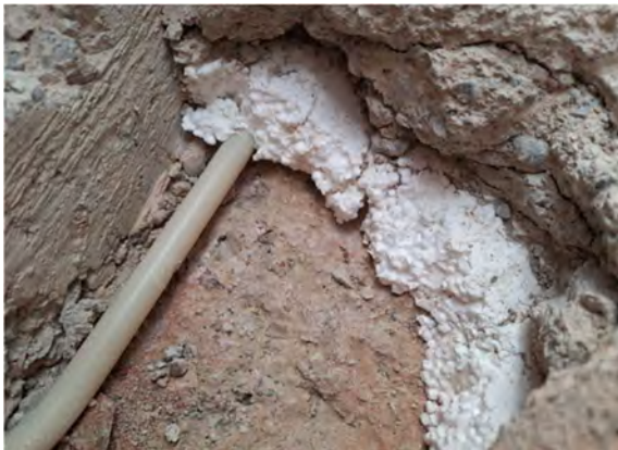
Kuva 132. Lattiarakenteessa on EPS-lämmöneriste.
