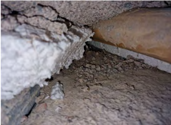
Kuva 135. Lattiarakenteessa on EPS-lämmöneriste.
