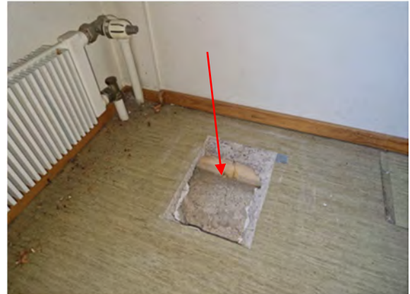
Kuva 136. Avaus tehtiin lähelle ulkoseinän ja väliseinän nurkkaa.
