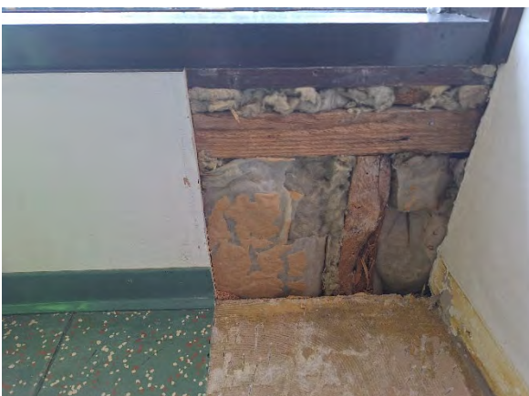
Kuva 73. Seinä on eristetty mineraalivillalla ilman höyrynsulkua.
