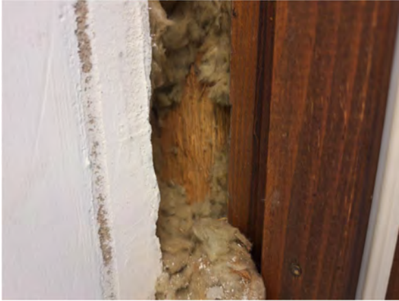
Kuva 95. Rakenneavaus IKK2. Ikkunan ja ulkoseinän välissä on ~50 mm mineraalivillaa ja apukarmit.
