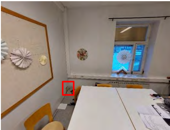
Kuva 198. Rakenneavaus US12 tehtiin rakennuksen 3 toimistoon 215, kuvaan merkitylle alueelle.
