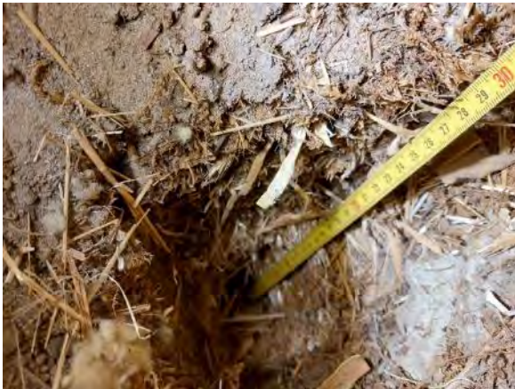
Kuva 335. Yleiskuva rakenneavaus YP4. Yläpohjan alkuperäisenä lämmöneristeenä on käytetty hiekkaa, samalta/metsänpohjaa sekä olkia.
