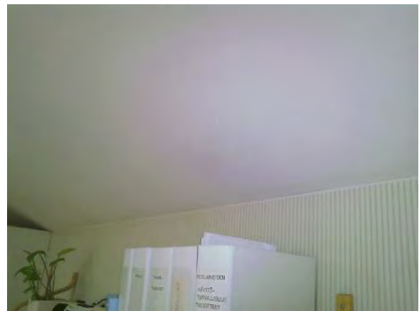
Kuva 326. Rakennuksen 2. kerros, henkilökunnan tau- kokuone. Ulkoseinän ja yläpohjan liitos
