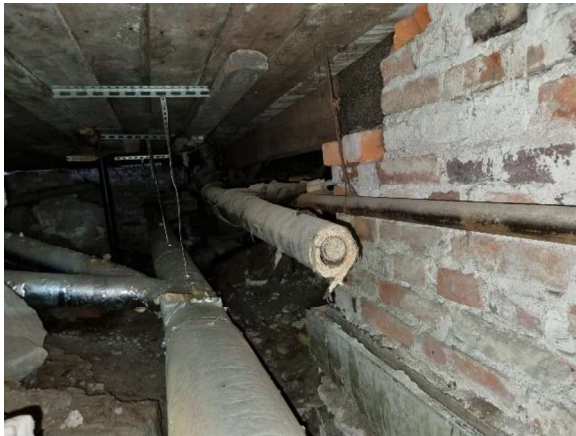
Kuva 25. Rakennuksen 2 alapohjassa havaitussa putkieristeessä ei ole asbestia tutkituilta osin.
