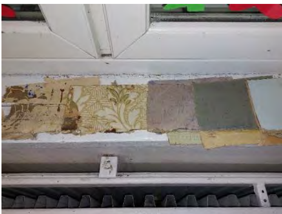
Kuva 247. Rakenneavaus VS2: Väliseinässä on useita tapettikerroksia.
