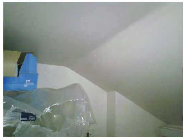
Kuva 320. Rakennuksen toisen kerroksen yläpohjan liitoksesta.
