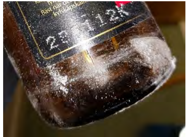
Kuva 262. Rakenneavaus VS3: Väliseinän sisältä löytyi pullo, jonka päiväys on kirjattu 01/12
