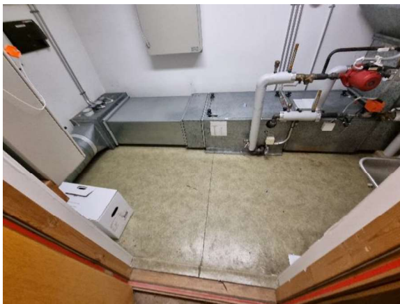
Kuva 12. IV-konehuoneen harmaa muovimatto, liima tai tasoite eivät sisällä asbestia.
