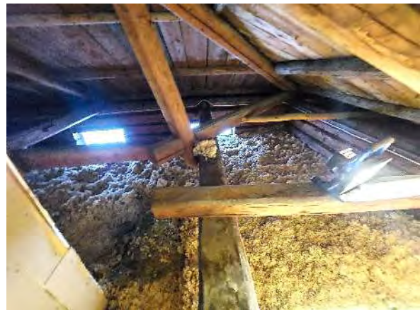
Kuva 293. Yleiskuva yläpohjasta luoteissiiven vesikattorakenteista.
