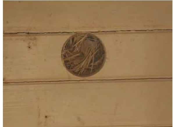
Kuva 340. Rakenneavaus YP4. Sisäpuolinen rakenneavaus lopetettiin lämmöneristeenä olevan olkieristeen alapinnalle.
