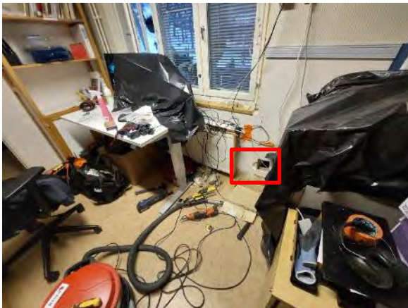
Kuva 138. Rakenneavaus US7 tehtiin laajennusosan ulkoseinään kuvaan merkittyyn kohtaan.
