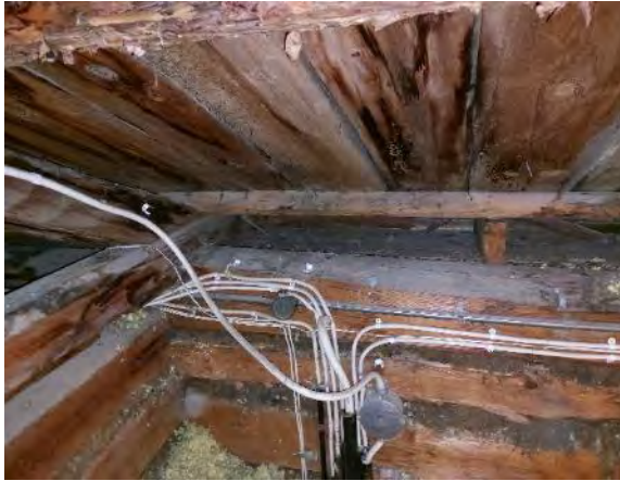
Kuva 95. Ulkoseinän hirsirakenne kuvattuna yläpohjasta. Hirsien tilkemateriaalina on sammalta. Kuva luoteissiivestä, jossa hirsikehikko ulottuu räystäsrakenteeseen saakka.
