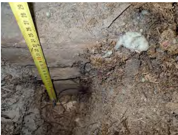
Kuva 305. Yleiskuva rakenneavaus YP2. Puhallusvillan alapuolella on eristeenä sammalta ja hiekkaa.
