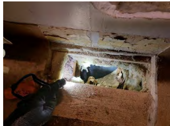
Kuva 31. Rakenneavaus AP 5: Ulkoseinän vierellä lämmöneristeenä on käytetty mineraalivillaeristettä sekä sanomalehtiä.
