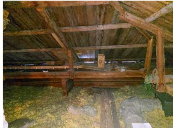
Kuva 328. Yleiskuva yläpohjasta. Yläpohja on lisälämmöneristetty puhallusvillalla.
