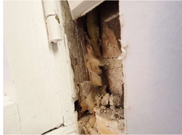
Kuva 19. Rakennuksen 3 1. kerroksen neuvotteluhuoneen alkuperäisen ikkunakarmin rappaus ja maali eivät sisällä asbestia.
