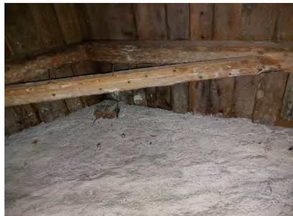
Kuva 356. Toimistotilan yläpohja on eristetty muun rakennuksen 3 yläpohjasta. Tämän tutkimuksen yhteydessä tarkastettiin ainoastaan toimiston yläpuolella oleva yläpohjatila.
