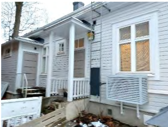
Kuva 55. Rakennuksen 2 sokkelirakenteessa havaittiin tuulettumisen mahdollistavia aukkoja.
