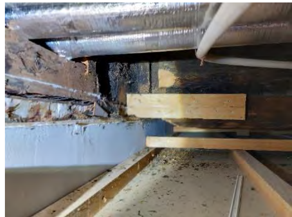
Kuva 211. Sisäkaton yläpuolella on havaittavissa alkuperäistä hirsirunkoa keittiön edustalla olevan käytävän kohdalla.
