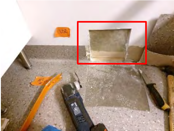
Kuva 113. Rakenneavaus US2 tehtiin päiväkotiryhmän Ruusunpuut tilaan ruokailuhuoneeseen kuvaan merkitylle alueelle.
