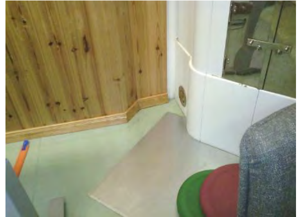
Kuva 74. Valokuva tulisijan, väliseinän ja alapohjan liitoksesta.
