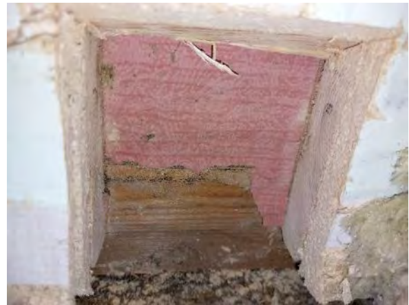
Kuva 116. Rakenneavaus US2: Hirsirungon pinnalla havaittiin pinkopahvi ja tapettikerros.
