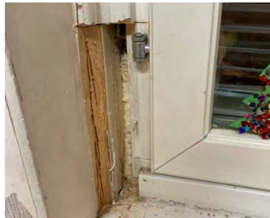
Kuva 147. Rakenneavaus IKK 2: Uusi ikkuna on asennettu vanhan karmirakenteen pintaan.
