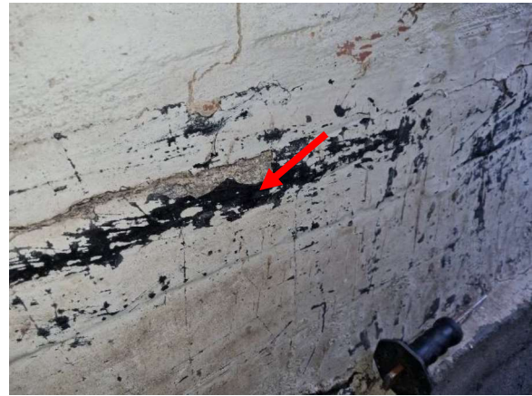
Kuva 27. Sokkelin sisäpuoleinen vedeneriste ei sisällä asbestia.
