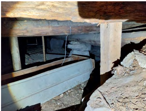
Kuva 5. Yleiskuva rakennuksen 1 ryömintätilasta. Luoteen puoleinen siipi.
