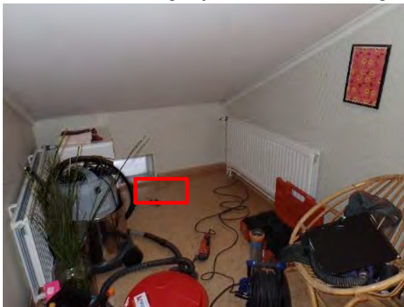
Kuva 216. Rakenneavaus VP1 tehtiin rakennuksen 1 2.kerros aulatilan syvennykseen, kuvaan merkitylle alueelle.
