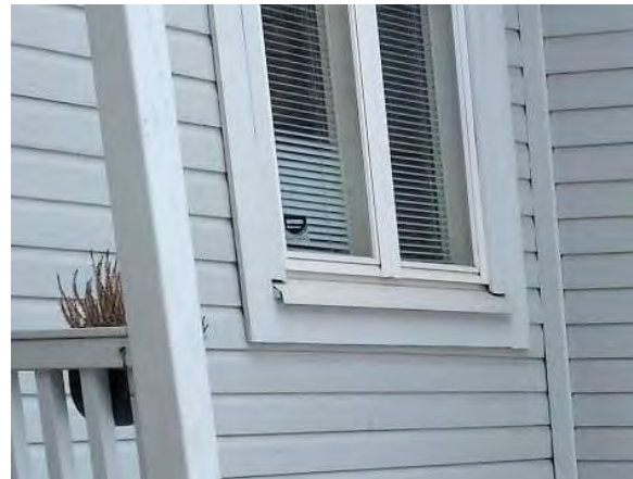
Kuva 161. Rakennuksessa 2 ikkunapellityksillä on rakennuksen 1 tapaan suojattu puurakenteinen ikkunalaata.
