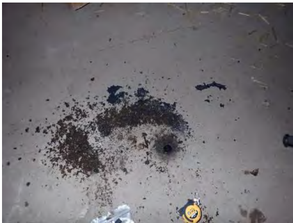
Kuva 86. Rakenneavaus AP10: Rakennuksen 3 alapohjan tarkastus tehtiin kellaritilaan.
