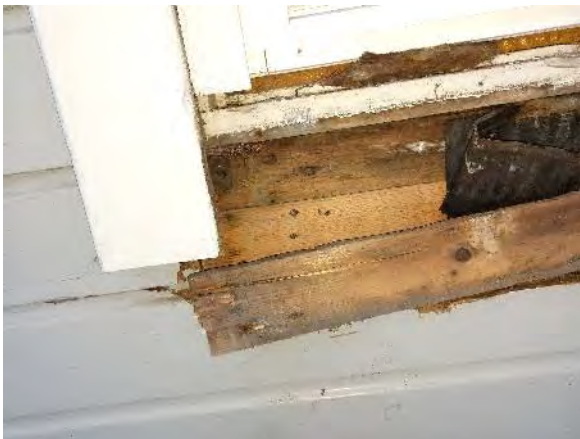
Kuva 110. US1: Rakenne tarkastettiin ikkunan alapuolelta rakennuksen ulkopuolelta.
