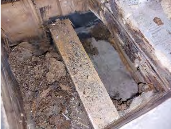
Kuva 237. Rakenneavaus VP3: Rakennuksen 3 välipohja on betonirakenteinen.
