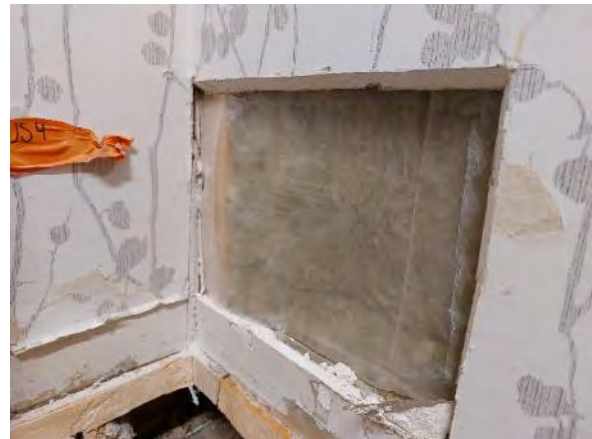
Kuva 246. Rakenneavaus VS2: Väliseinään on lisätty kipsilevy ja mineraalivilla.
