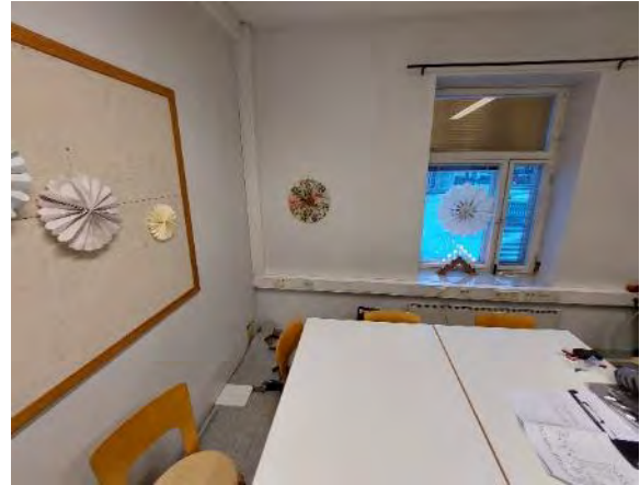
Kuva 195. Rakennuksen ulkoseinien sisäpinnat on verhoiltu kipsilevyllä.
