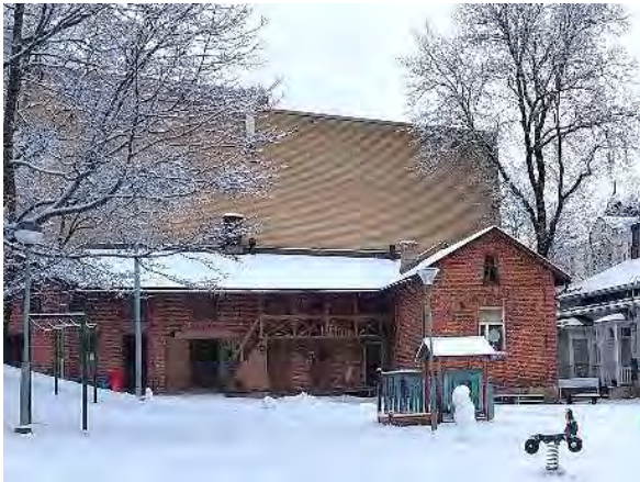
Kuva 353. Rakennus 3. Vesikate oli tutkimushetkellä lumipeitteinen, jonka vuoksi sen kuntoa ei tämän tutkimuksen yhteydessä tarkastettu.
