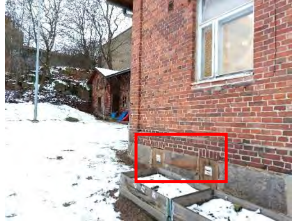
Kuva 84. Rakennuksen 3 sokkelissa on kellarin tuulettumisen mahdollistavat aukot vanhojen ikkunoiden kohdissa.
