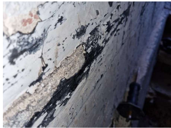
Kuva 15. Rakennuksen 3 porrashuoneen rappaus ja maali eivät sisällä asbestia.
