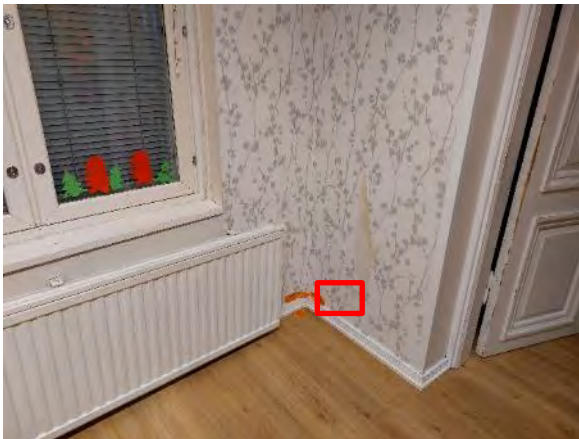
Kuva 245. Rakenneavaus VS2 tehtiin päiväkotiryhmän Sinikellot ryhmähuoneeseen, kuvaan merkitylle alueelle.
