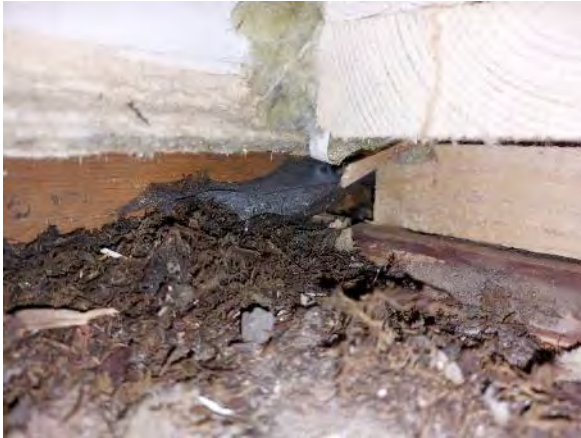
Kuva 20. Alapohjarakenteen eristeet on asennettu hir-sirunkoa vasten.
