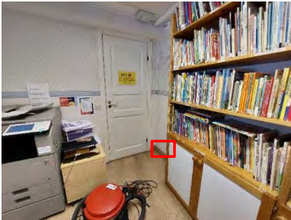
Kuva 242. Rakenneavaus VS1 tehtiin kuistin laajennusosan toimistoon, kuvaan merkitylle alueelle.
