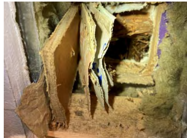
Kuva 168. US10: Rakenteessa on sisäpuolinen lisälämmöneriste. Puukuitulevyn takana havaittiin useita tapettikerroksia.
