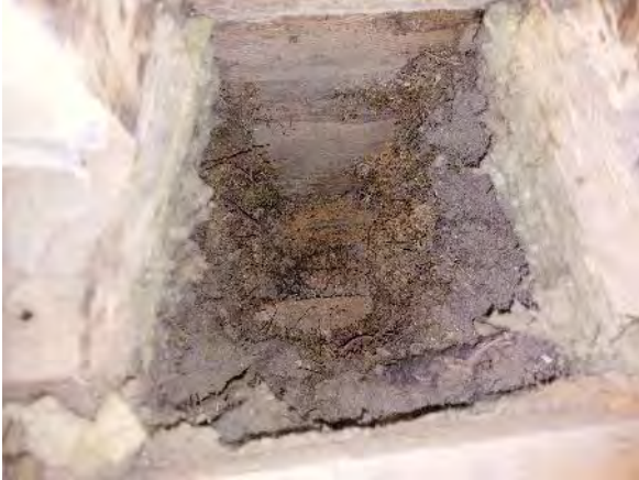
Kuva 15. Eristekerroksen alapuolella on kaksinkertainen aluslaudoitus.
