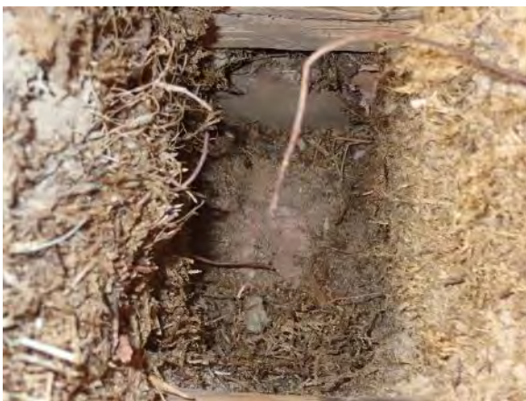
Kuva 302. Yleiskuva rakenneavaus YP1.
