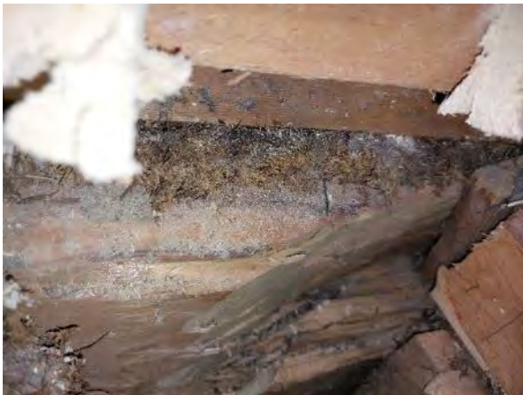
Kuva 117. Hirsien tilkkeenä on käytetty havaintojen perusteella sammalta.
