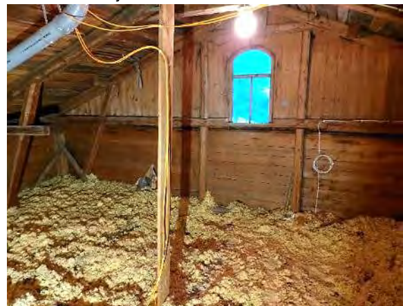
Kuva 94. Rakennuksen päätykolmiot ovat lounaissivun alueella rankarakenteiset.
