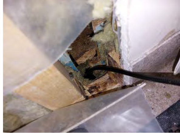
Kuva 127. Tyhjää tilaa tutkittiin endoskoopin avulla.
