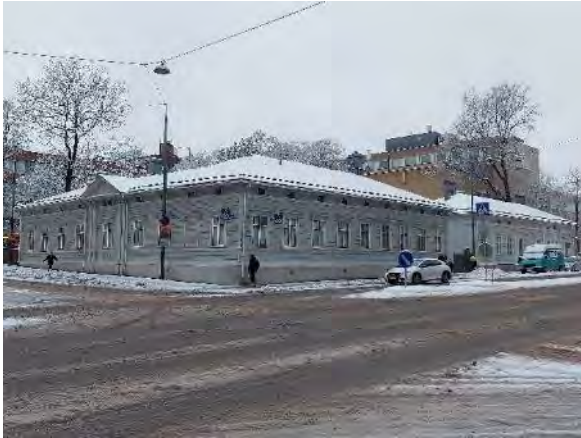
Kuva 276. Rakennus 1. Vesikate oli tutkimushetkellä lumipeitteinen, jonka vuoksi sen kuntoa ei tämän tutkimuksen yhteydessä tarkastettu.
