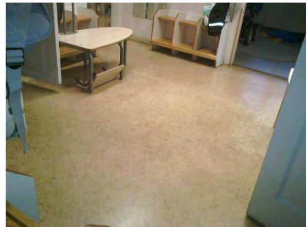
Kuva 44. Valokuva eteistilasta rakennuksen lounaissiivessä. Muovimaton alapuolella on todennäköisesti lattialankut.
