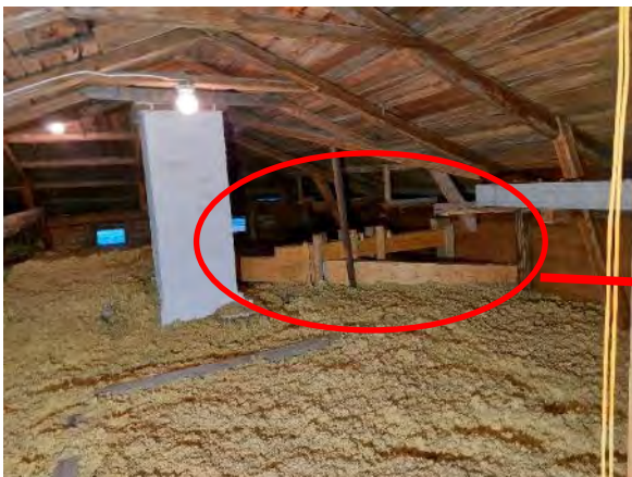
Kuva 280. Yleiskuva lounaissiiven yläpohjasta. Yläpohja on lisälämmöneristetty puhallusvillalla.
