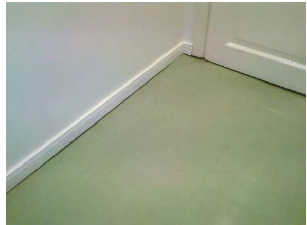
Kuva 78. Valokuva väliseinän ja alapohjan liitoksesta varastossa.
