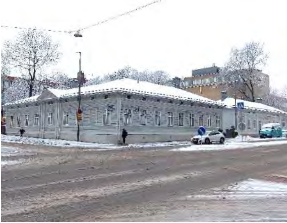
Kuva 89. Rakennuksen 1 ja 2 ulkoseinät ovat puuverhoiltuja hirsirakenteisia seiniä. Kuva rakennuksesta 1.
