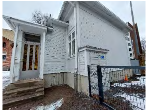
Kuva 54. Rakennuksen alapohjaan on kulkuluukku ET17 alueella.
