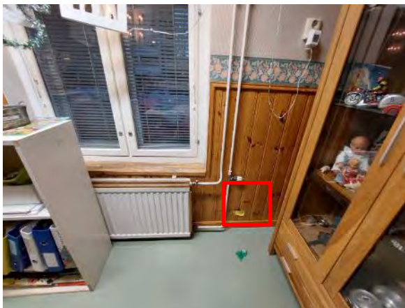
Kuva 163. Rakenneavaus US8 tehtiin rakennuksen 3 pienoiskeittiön kuvaan merkitylle alueelle.
