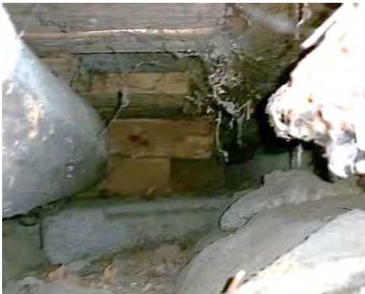
Kuva 17. Yleiskuva ryömintätilasta Kaskenkadun suuntaan. Kuvan oikealla puolella on ulkoseinä.
