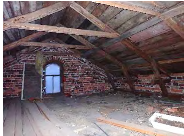
Kuva 354. Yleiskuva yläpohjasta. Vesikattorakenteet ovat puurakenteisia.
