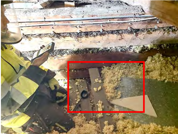
Kuva 300. Rakenneavaus VS1: tehtiin ulkoseinän vierustalle, kuvaan merkitylle alueelle.
