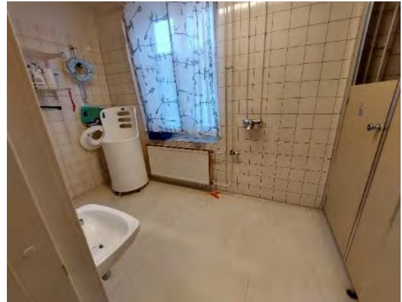
Kuva 60. Rakennuksen märkätiloissa on käytetty lattiapäällysteenä muovimattoa. Kuva rakennuksen 2 WC-/pesutilasta 11.
