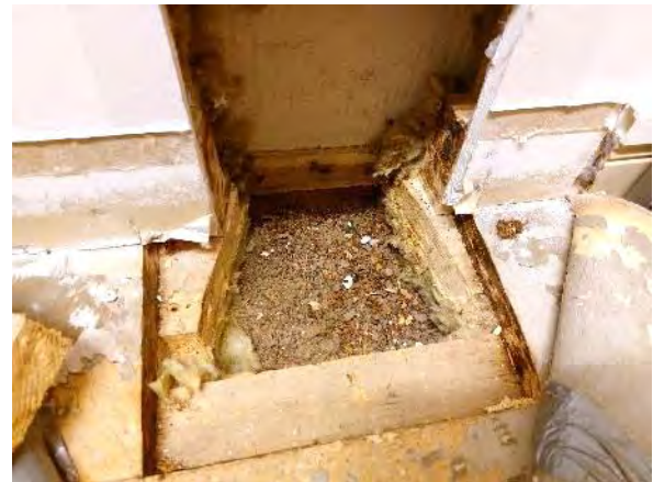
Kuva 14. Rakenneavaus AP1: Rakenteen lisälämmöneristeenä on käytetty mineraalivillaeristettä. Alkuperäinen lämmöneriste on hiekkaa, sammalta ja metsänpohjajuurakkoa, jotka sisältävät luontaisesti mm. maaperämikrobeja.
