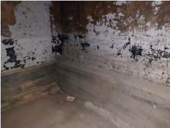
Kuva 85. Yleiskuva rakennuksen 3 kellarin alapohjasta.
