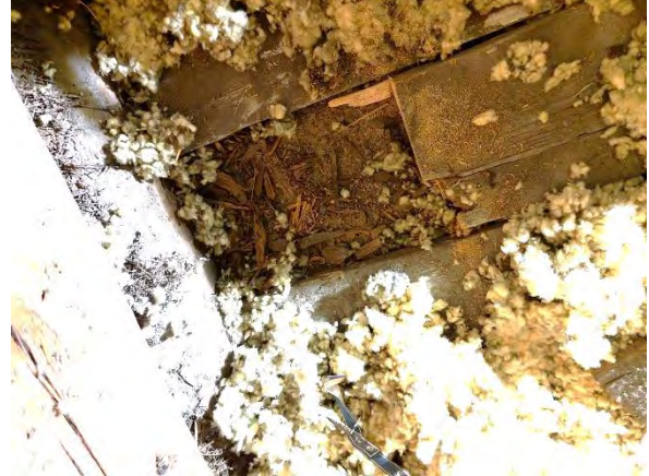
Kuva 334. Rakenneavaus YP4, laudoituksen päällä lämmöneristeenä on puhallusvilla.
