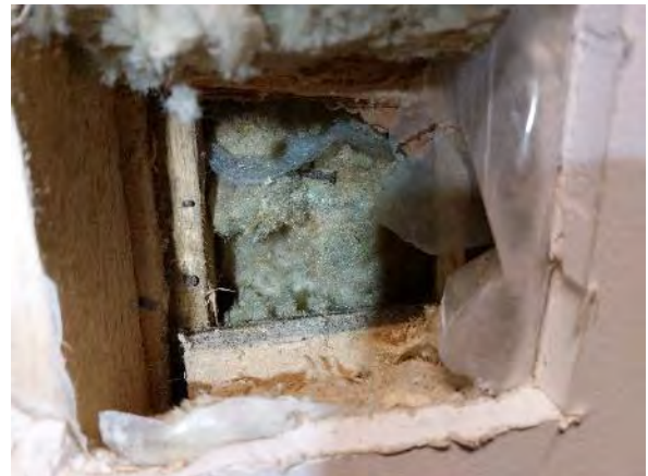
Kuva 139. Rakenneavaus US7: Ulkoseinärakenne poikkeaa muiden ulkoseinien toteutustavasta. Ulkoseinä on puurankarakenteinen.
