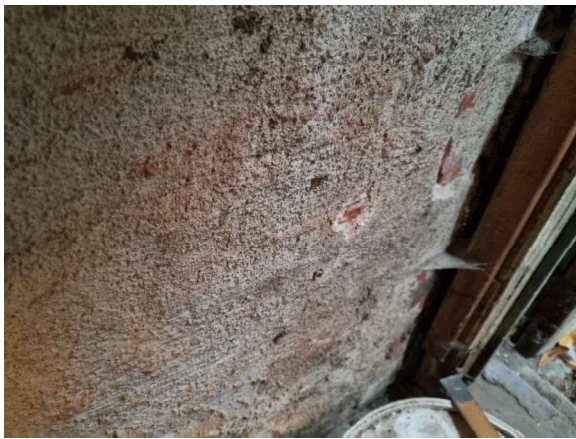
Kuva 14. Lämmönjakohuoneen tiiliseinän rappaus ja maali eivät sisällä asbestia.
