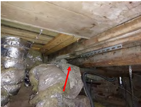
Kuva 258. Yleiskuva rakennuksen 2 alapohjasta. Ku- vassa oikealla väliseinän tuentaa eteisen ja jakelukeit- tiön väliseinän alapuolelta.
