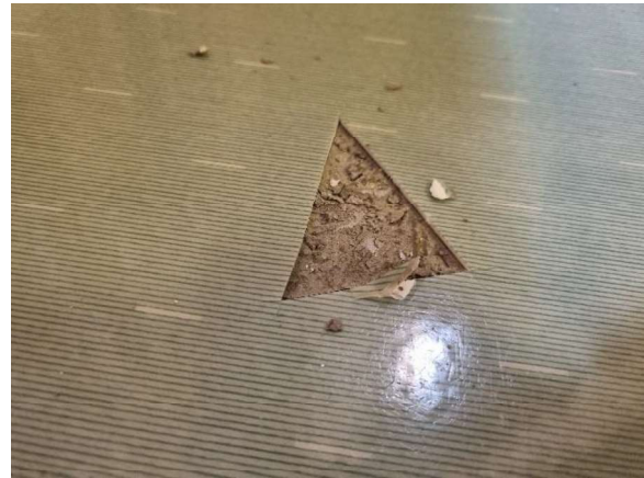
Kuva 11. Pienoiseittiön vihreä muovimatto, liima tai tasoite eivät sisällä asbestia.
