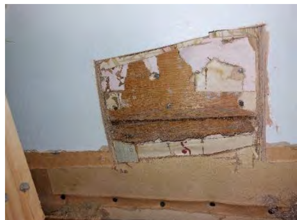
Kuva 248. Rakenneavaus VS2: Hirsiväliseinän tilkkeenä on käytetty sammalta.
