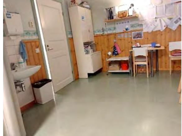
Kuva 58. Rakennuksen lattiapäällysteenä on käytetty pääosin muovimattopäällystettä.
