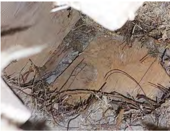
Kuva 220. Rakenneavaus VP2: Välipohjan laudoitus on rakenneavauksen kohdalta hyväkuntoinen. Ulkoseinän hirsirungossa ei havaittu lahovaurioita.
