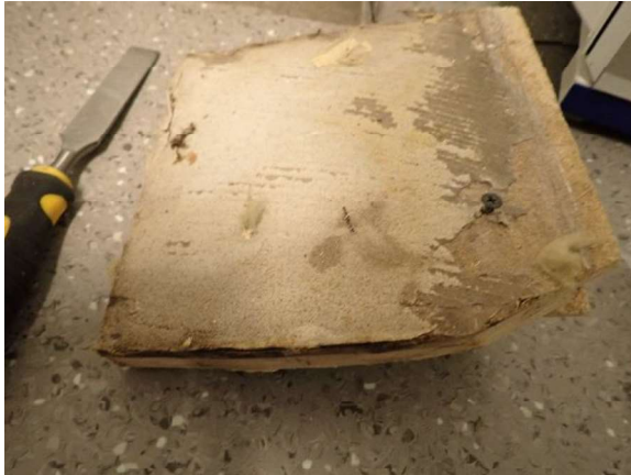
Kuva 6. Alemman lastulevyn lattiatasoite ei sisällä asbestia.
