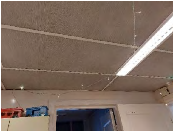
Kuva 208. Paikon välipohjan alakatto on laskettu ja sisäkaton pinta on levytetty mineraalivillaisilla alakattolevyillä.
