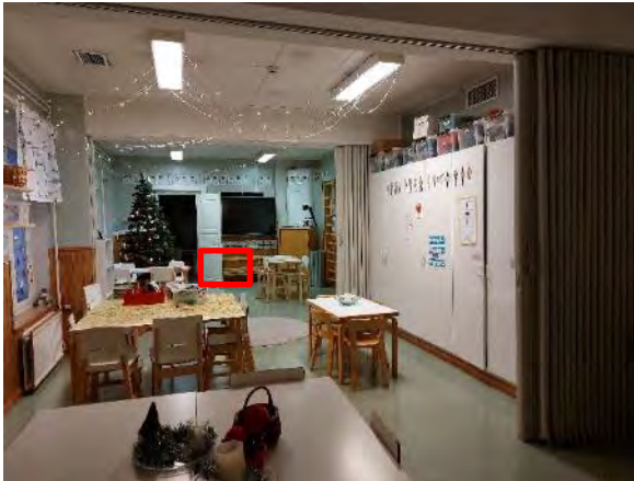
Kuva 259. Rakenneavaus VS3 tehtiin monitoimitilaan 5, kuvaan merkitylle alueelle.
