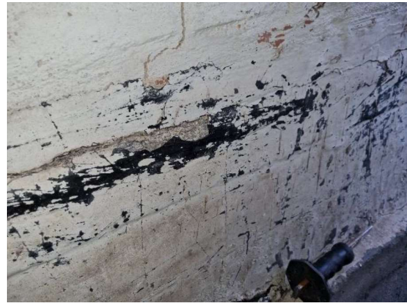
Kuva 33. Rakennuksen 3 kellarin seinien vedeneriste.
