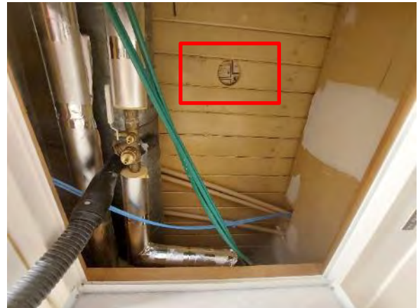
Kuva 336. Rakenneavaus YP4: Rakenteen sisätilojen puoleinen toteutustapa tarkastettiin verstaan alasasketun katon sisäkattorakenteeseen tehdyn avauksen kautta.
