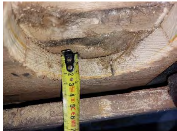
Kuva 111. Hirren ulkopinnalla havaittiin vaakalaudoitus.
