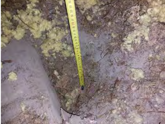
Kuva 307. Rakenneavauksen toteutustapa vastaa yläpohja-avausta YP2
