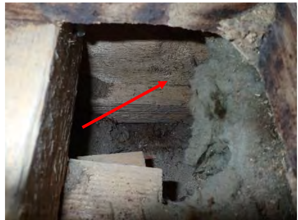
Kuva 215. Rakenneavaus VP1: Väli­seinä alkaa puu­laidoituk­sen päältä.
