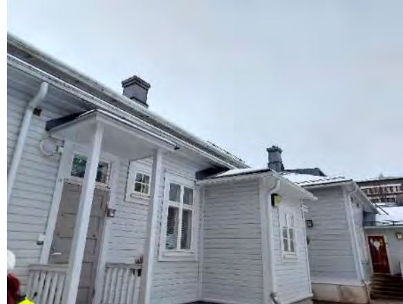
Kuva 159. Puuverhoiltujen julkisivujen maalipinnat ovat tarkastetuina osin hyväkuntoisia.
