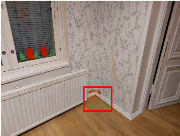
Kuva 26. Rakenneavaus AP 4 tehtiin päiväkotiryhmän Sinikellot ryhmähuoneeseen, kuvaan merkitylle alueelle.
