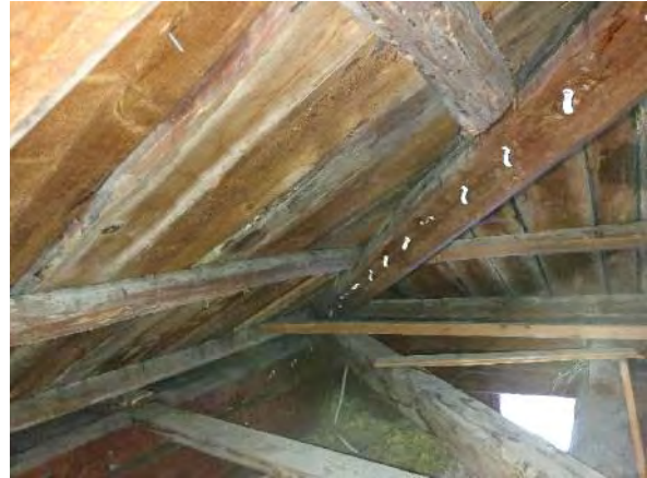
Kuva 289. Yleiskuva yläpohjasta luoteissiivestä.
