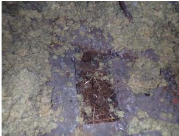
Kuva 341. Yleiskuva rakenneavaus YP5: Lisälämmöneristeenä on puhallusvillaa.
