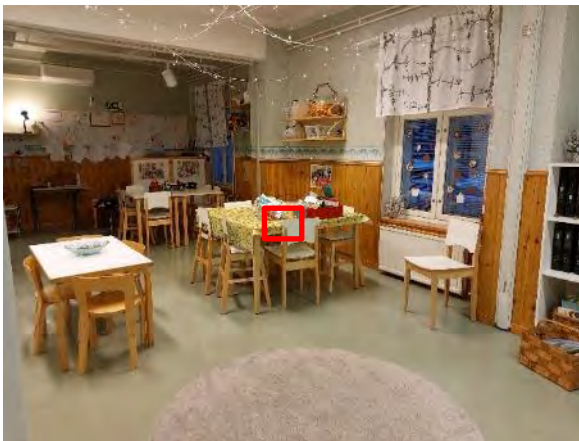
Kuva 170. Rakenneavaus US9 tehtiin rakennuksen 2 monitoimitilaan 5, kuvaan merkitylle alueelle.
