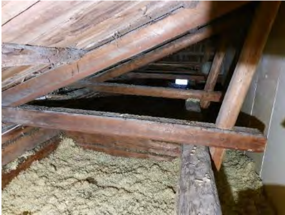
Kuva 288. Yleiskuva yläpohjasta luoteissiivestä.
