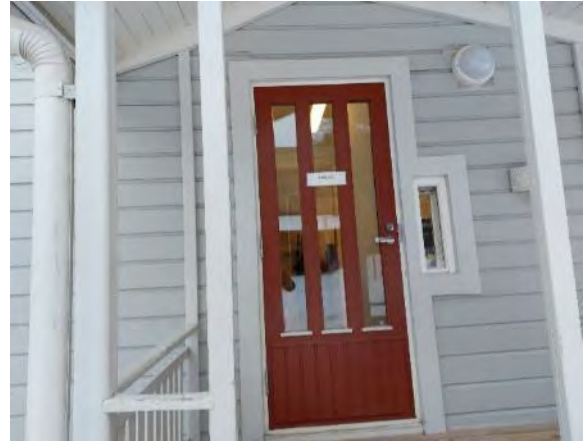
Kuva 102. Rakennuksen 1 ulko-ovet ovat uusittuja lasiaukollisia ovia. Kuva rakennuksen 1 toimiston ovesta.
