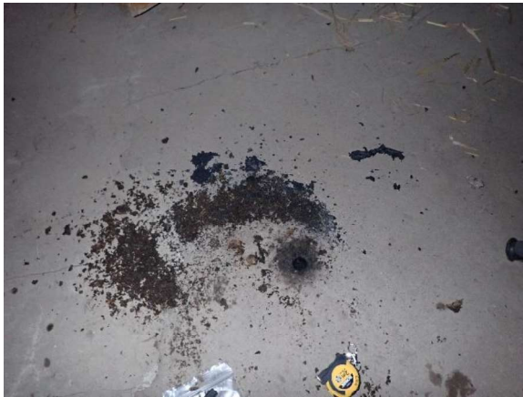
Kuva 34. Rakennuksen 3 kellarin alajahjan pinnassa on ohut tasoite, jonka alla on noin 50-75 mm valuasfalttia.
