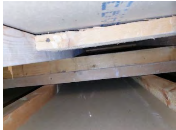
Kuva 243. Rakenneavaus VS1: Väliseinärakenne on kipsilevypintainen ja puurakenteinen.
