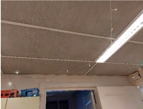
Kuva 357. Rakennuksissa on alakattolevytyksinä mineraalivillarakenteisia levyjä, joiden pintakerros on lasikuitukudosta.
