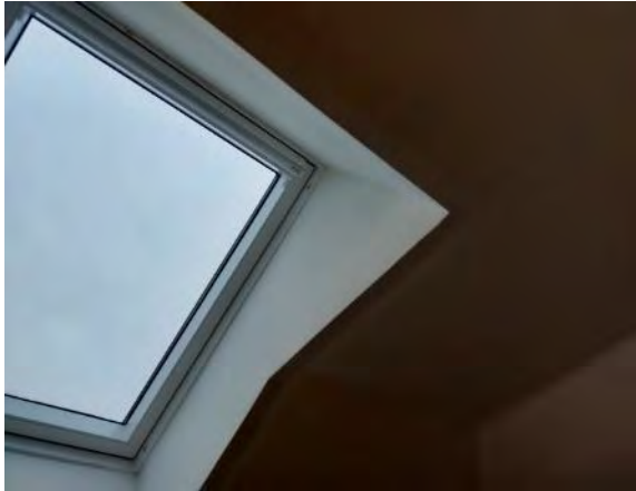
Kuva 101. Rakennukseen on lisätty kattoikkunoita rakennuksen 2. kerroksessa sijaitseviin sosiaalitiloihin.
