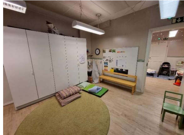
Kuva 7. Monitoimitilan lattiatakentteesta löytyvä lattiatasoite ei sisällä asbestia.
