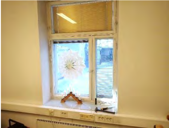
Kuva 201. Rakenneavaus IKK4: Ikkunat ovat rakennuksia 1 ja 2 iäkkäämpiä.
