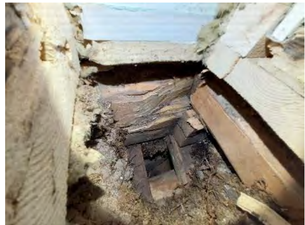
Kuva 23. Yleiskuva rakenneavauksesta AP2.
