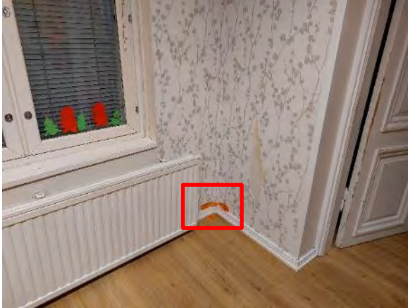
Kuva 130. Rakenneavaus US4 tehtiin päiväkotiryhmän Sinikellot ryhmähuoneeseen alapohjan ja väliseinän liikseen.
