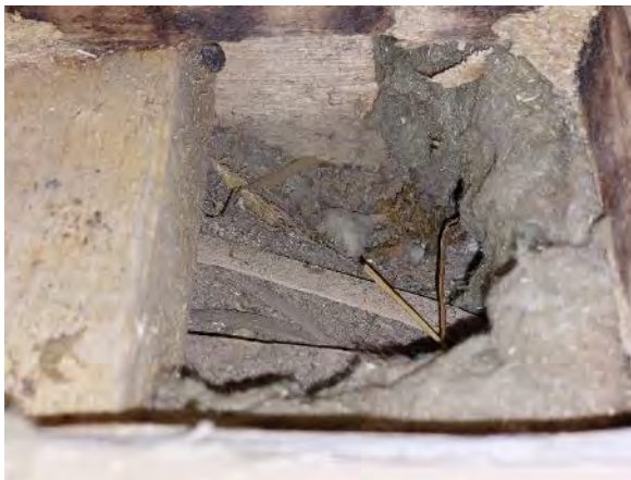
Kuva 214. Rakenneavaus VP1: Väli­pohjan eristemat­erialina on mineraalivilla, hiekka ja metsänpohjajuurakko.
