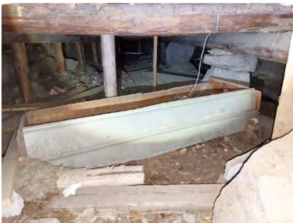
Kuva 241. Yleiskuva alapohjarakenteen ryömintätilasta. Alapohjarakennetta on tuettu kivillä ja puurakenteisilla tolilla.
