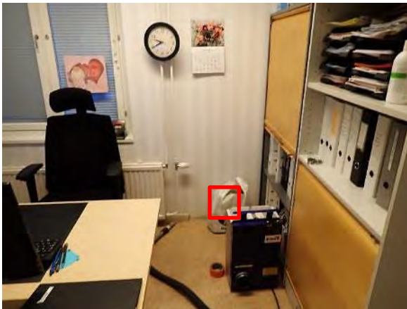
Kuva 104. Rakenneavaus US1 tehtiin rakennuksen 1 eteisen työhuoneeseen. Kuvan merkittyyn kohtaan.
