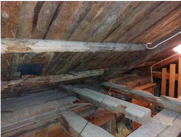
Kuva 329. Yleiskuva yläpohjasta. Yläpohjan tuulettumisen mahdollistavia ilmarakoja ei havaittu räystäillä.
