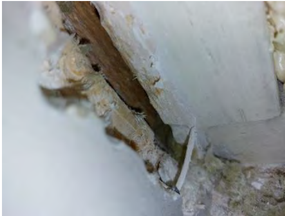
Kuva 178. Rakenneavaus IKK3: Ikkunat ovat uusittuja. Uusittu ikkuna on asennettu vanjojen karmien päälle.
