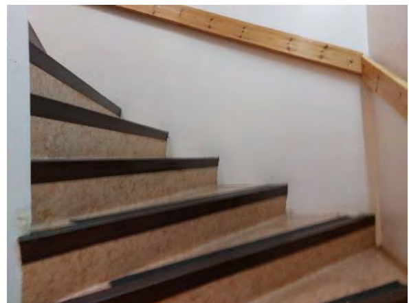
Kuva 205. Yläkertaan vievät portaat ovat puurakenteiset ja niissä on muovimattopinta.
