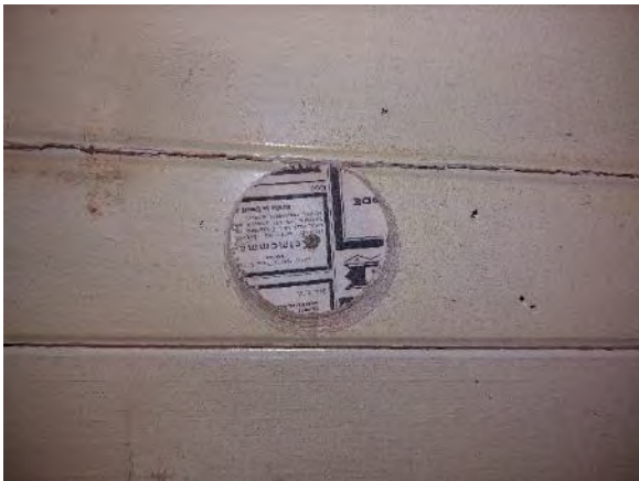
Kuva 337. Maalattun kattolaudan takana on kerros paperia.
