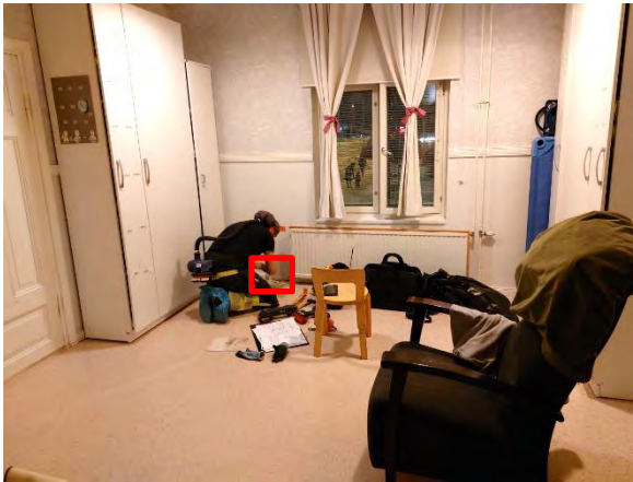
Kuva 36. Rakenneavaus AP 6 tehtiin päiväkotiryhmän Kissantassut lepohuoneeseen, kuvaan merkitylle alueelle.
