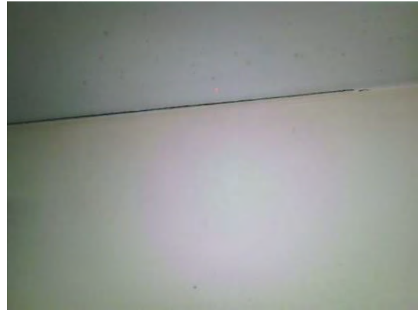
Kuva 232. Valokuva väliseinän ja -pohjan liitoksesta.
