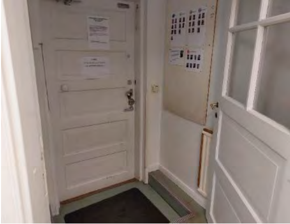
Kuva 162. Rakennuksen 2 ulko-ovet ovat umpiovia.
