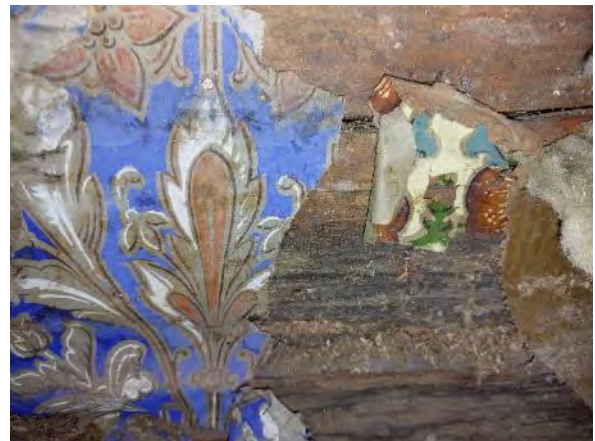
Kuva 171. Rakenneavaus US9. Hirren sisäpinnalla havaittiin tapettijäämiä.
