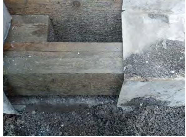
Kuva 120. Ulkoseinän alaosassa on pellitys, jossa on puurakenteinen tukirakenne.
