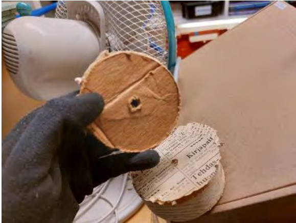
Kuva 339. Rakenneavaus YP4. puukuitulevyn toinen puoli on pinnoitettu.
