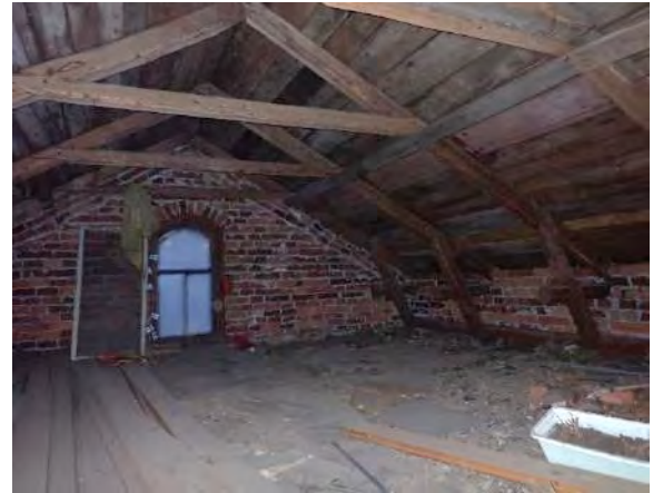
Kuva 191. Päädyt ovat tiilirakenteisia.
