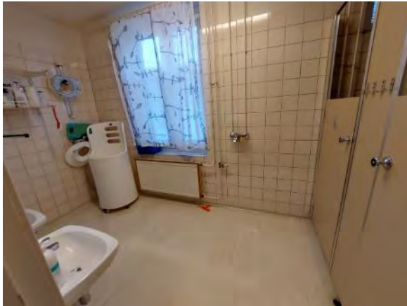
Kuva 69. Rakenneavaus AP9: WC:n vedeneristeen tarkastus suoritettiin rakennuksen 2 pesuhuoneeseen 11.
