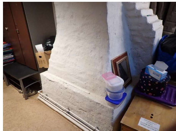
Kuva 17. Rakennuksen 1 2. kerroksen pukuhuoneen hormin rappaus ja maali eivät sisällä asbestia.
