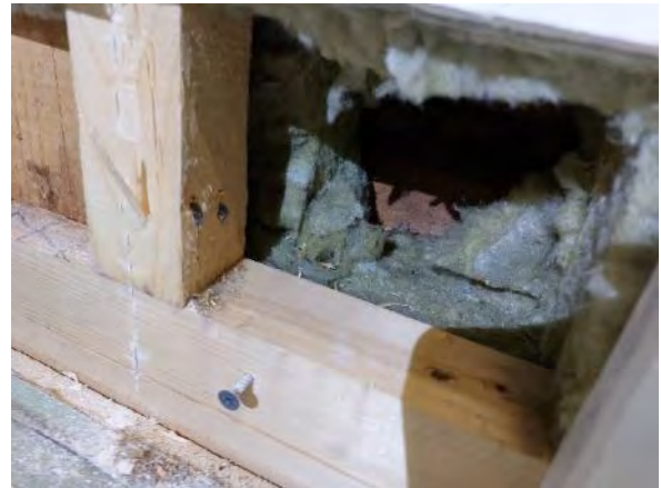
Kuva 175. Rakenneavaus US11. Yleiskuva rakenneavauksesta US11.
