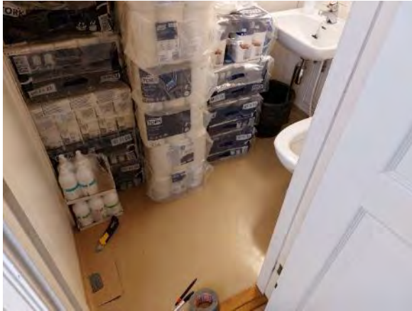
Kuva 206. Välipohjan sosiaali- ja wc-tilojen päällysteenä on muovimatto.
