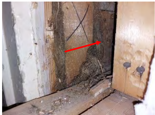
Kuva 266. Rakenneavaus VS4: Rakenneavauksesta on havaittavissa vanhaa puurakenteista seinää.
