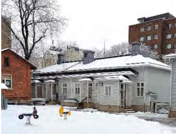
Kuva 158. Rakennuksen 1 ja 2 ulkoseinät ovat puuverhoiltuja hirsirakenteisia seiniä. Kuva rakennuksesta 1.
