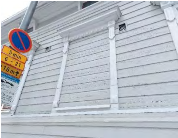
Kuva 97. Rakennuksen 1 julkisivussa on havaittavissa alkuperäisten ikkunoiden ja ovien ummistuskohtia.
