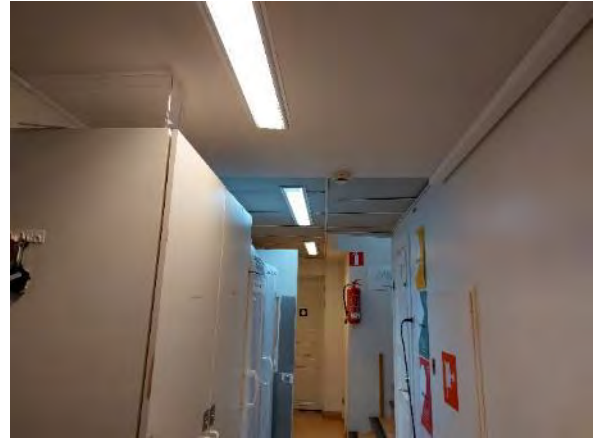
Kuva 207. Pääosin 1 kerroksen välipohjan alapinta on levytetty.
