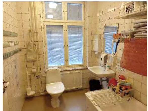
Kuva 12. Rakennuksen 1. märkätiloissa on käytetty lattiapäällysteenä muovimattoa.
