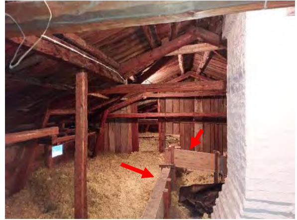
Kuva 279. Yleiskuva yläpohjasta rakennuksen lounaissiivestä. Yläpohjan lounaissiiven alueella on lisätuentoja.
