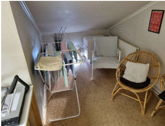
Kuva 10. Taukotilan ruskea muovimatto, liima tai tasoite eivät sisällä asbestia.
