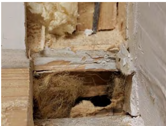
Kuva 145. Rakenneavaus IKK1: Uusitun ikkunarakenteen ja vanhan karmin välissä tilkkeenä on uretaanivaahdotus. Vanhan karmin ja ulkoseinän liitoksessa eristeenä on pellavarive.
