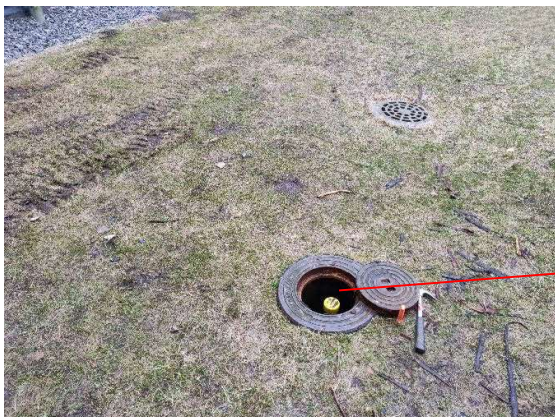
Kuva 18. Sadeveden tarkastuskaivo rakennuksen koillisen puoleisella seinustalla.
