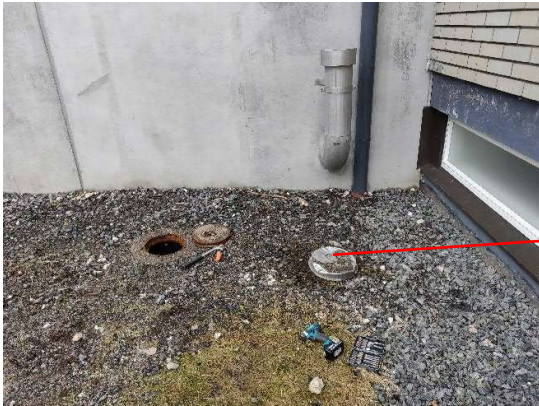
Kuva 15. Salaojakaivot laajennusosan ja alkuperäisen osan liittymäkohdassa.
