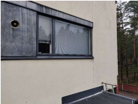
Kuva 175. Ikkunan pellitykset olivat hyväkuntoisia. Puitteista ei havaittu poikkeavaa.
