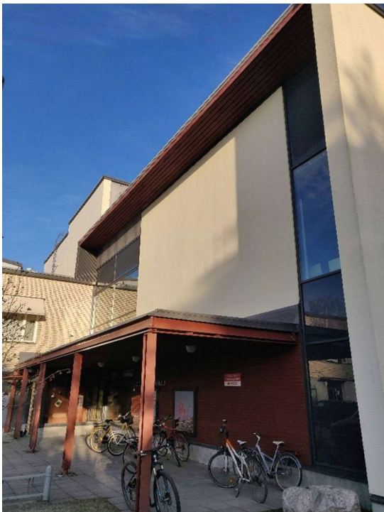
Kuva 125. Pääsisäänkäynti vanhan osan ja laajennusosan liittokohdassa rakennuksen eteläpuolella.
