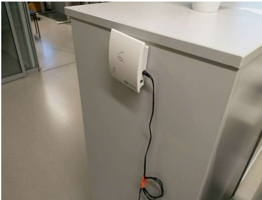
Esimerkkikuva. Sisäilman hiilidioksidipitoisuusmittaus (FCG Oy).
