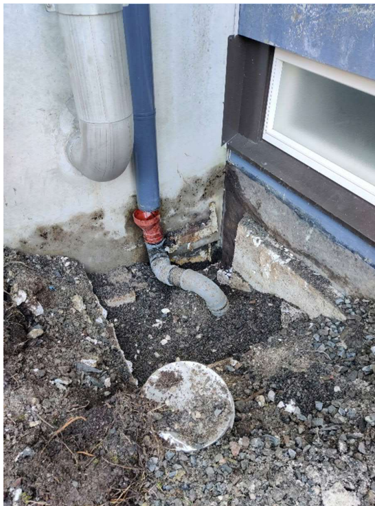
Kuva 128. Koekuoppa vanhan ja uuden puolen yhdys- kohdassa. Kuopasta havaittiin laajennusosan vierus- talla olevan suunnitelmien mukaisesti salaojasora pystysalaojakerroksessa.
