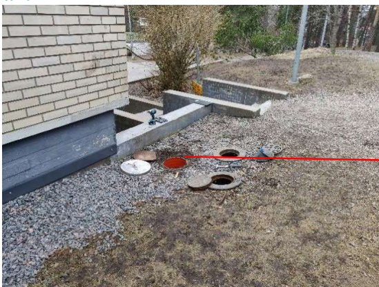
Kuva 13. Salaojan ja sadeveden tarkastuskaivot rakennuksen pohjoisnurkalla.
