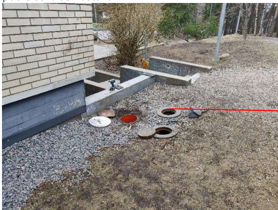
Kuva 20. Sadeveden tarkastuskaivot sekä salaojan tarkastuskaivo rakennuksen pohjoisnurkalla.
