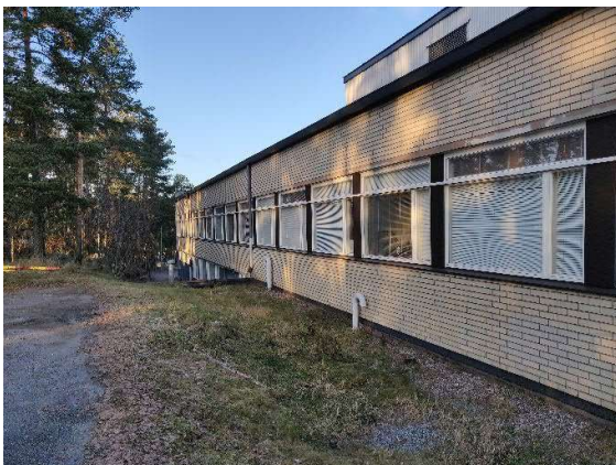
Kuva 7. C-siiven julkisivu väestönsuojan kohdalta.
