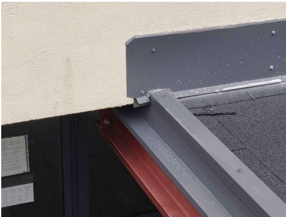
Kuva 179. Katoksen liitos ulkoseinärakenteeseen.
