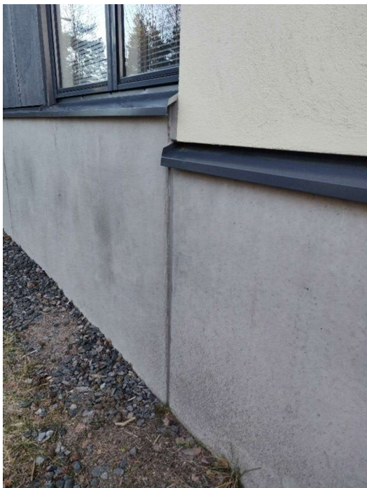
Kuva 142. Sokkelielementit olivat hyväkuntoisia. Saa- maukset olivat ehjät.
