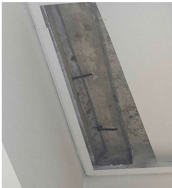
Kuva 120. Alakaton yläpuolelta havaittiin vanhoja muottilautoja sekä alkuperäisiä lastuvillasementtilevyjä.
