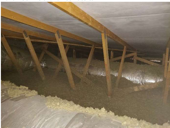
Kuva 187. Yläpohja tuulettui hyvin.
