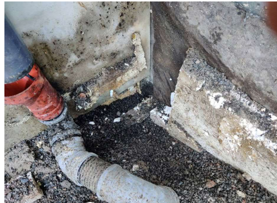
Kuva 12. Koekuoppa KK1 laajennusosan ja alkuperäisen osan liittymäkohdassa.
