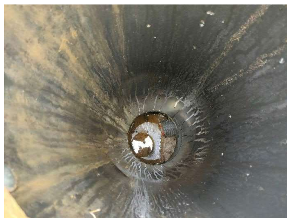
Kuva 133. Salaojan tarkastuskaivo.
