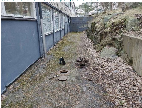
Kuva 22. Sadeveden tarkastuskaivo rakennuksen lounais-sivustalla.
