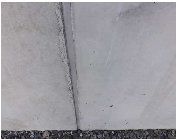
Laajennusosan sokkeliä; elastinen pystysauma on ehjä
