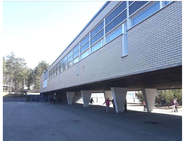
Yksi osa kiinteistöä on kannateltu betonipilareilla
