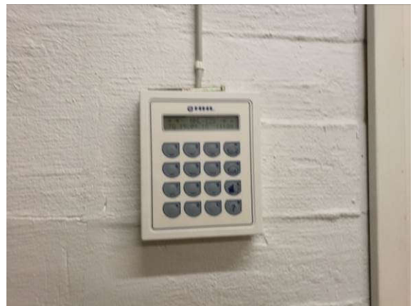
Rikosilmoitusjärjestelmä, käyttölaite
