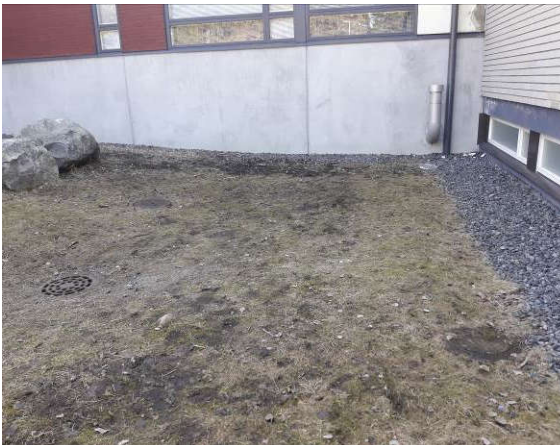
Sisänurkka, jossa pintavedet on ohjattu sadevesikaivoon; taustalla näkyy salaojan tarkastuskäivon kansi
