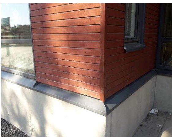
Sokkelin päällä olevaa suojapellitystä
