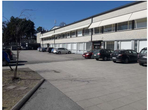
Vanhan osan julkisivua ja betonilaatoitusta
