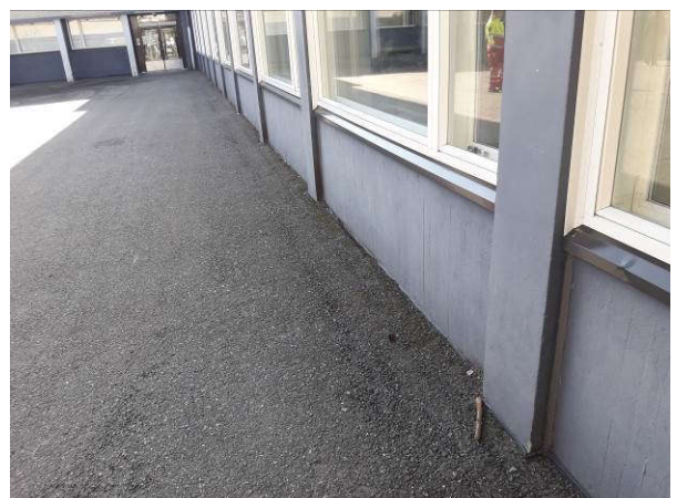
Sisäpihan sokkeliä vanhalla osalla
