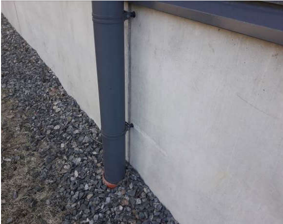
Kattovedet on ohjattu suoraan omaan poistojärjestelmään
