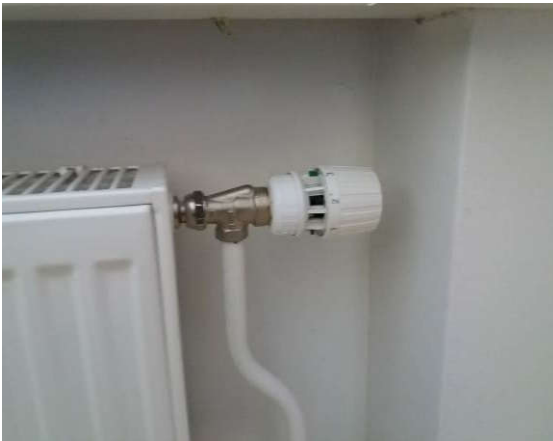
Termostaattinen patteriventtiili.
