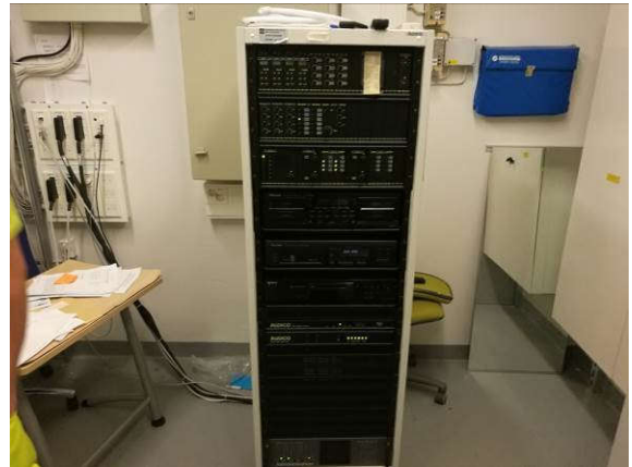
Äänentoistojärjestelmän keskus.
