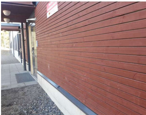
Puujulkisivua, jonka kunto on hyvä. Varauduttav huoltomaalaukseen tarkastelujakson lopussa
