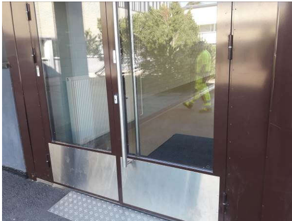
Metallirakenteinen ulko-ovi
