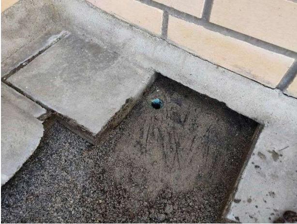
Kuva 45. Vedenpoistossa ei havaittu puutteita.
