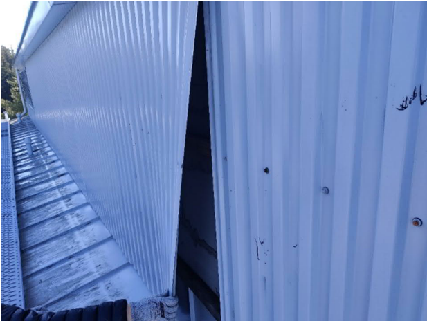
Kuva 31. IV-konehuoneen seinärakenne tarkastettiin ulkokautta.
