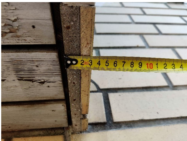
Kuva 35. Ulokerakenteessa ohut betoninen runkorakenne, johon on kiinnitetty tiililaatta.
