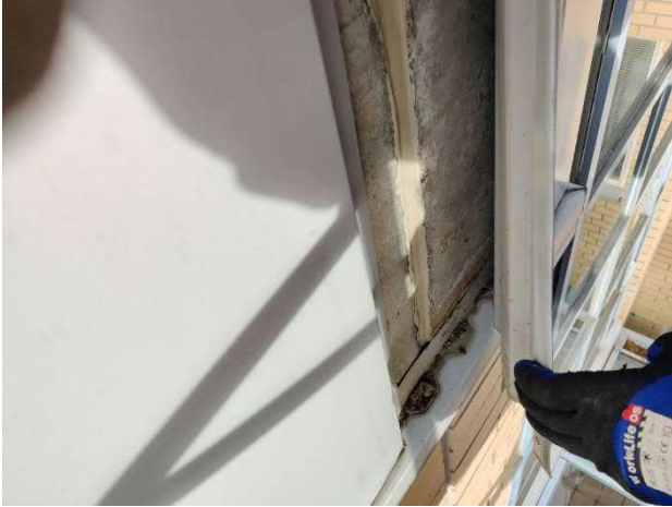
Kuva 29. Julkisivujen yläosat on pellitetty, pellitys on kiinnitetty elementtiin upotettuihin painekyllästettyihin vaakapuihin.
