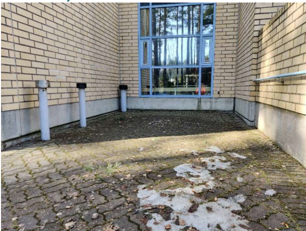
Kuva 11. Kuva kaakkoissivustalta. Sokkelirakenteet jatkuvat muutamia senttejä maanpinnan yläpuolelle.
