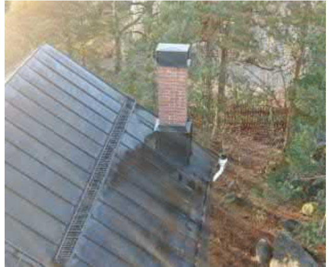
Vesikatto on hyvässä kunnossa.
