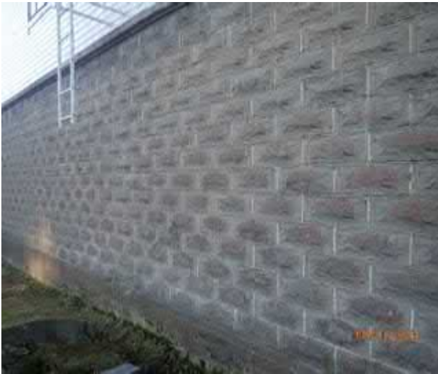
Tiilimuuraus on ulkoisesti hyvässä kunnossa.
