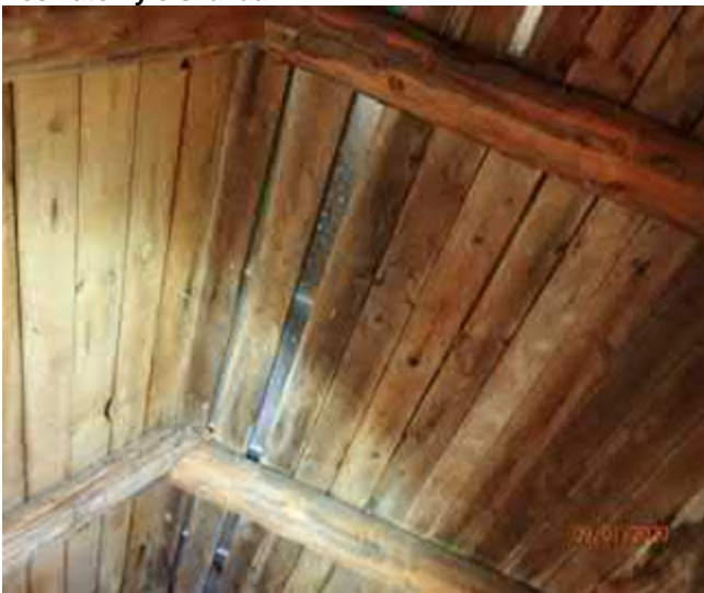
Yläpohja on tyydyttävässä kunnossa.
