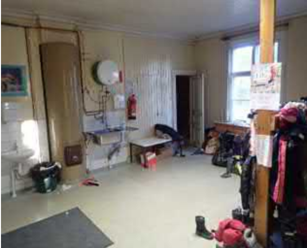
Aulatilat ovat välttävässä kunnossa.
