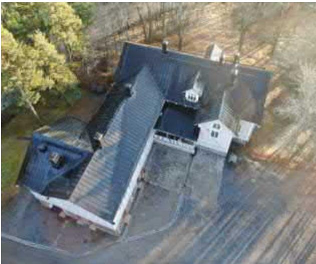
Vesikatto on hyvässä kunnossa.
