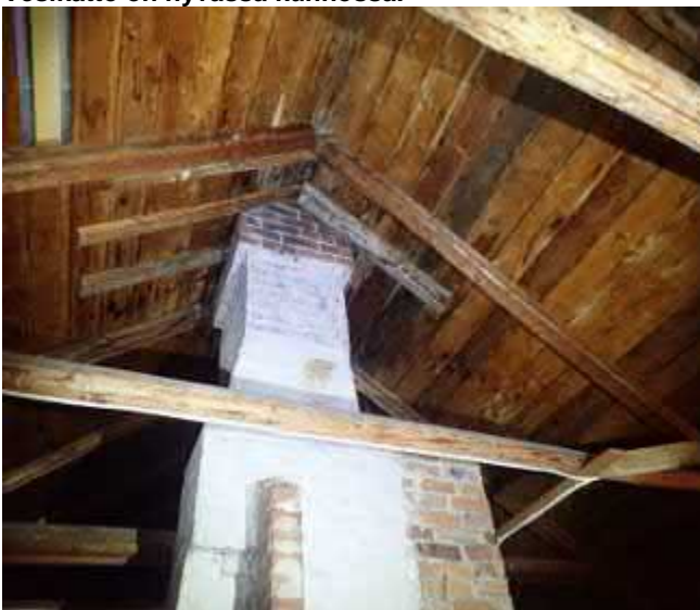
Yläpohja on tyydyttävässä kunnossa.
