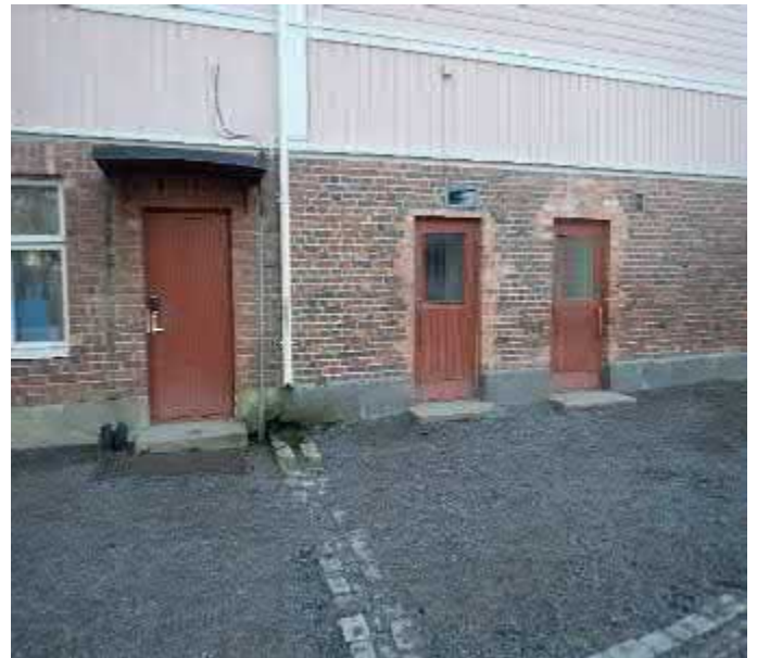
Tiilijulkisivu on ulkoisesti tyydyttävän kuntoinen.
