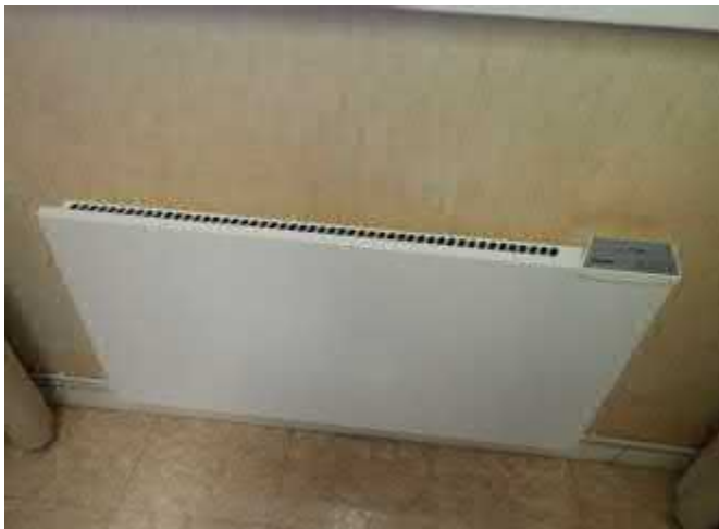
Lämmityspatterit ovat paikoin uusittu luokissa.
