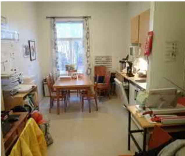
Keittiön lattia on tyydyttävässä kunnossa.
