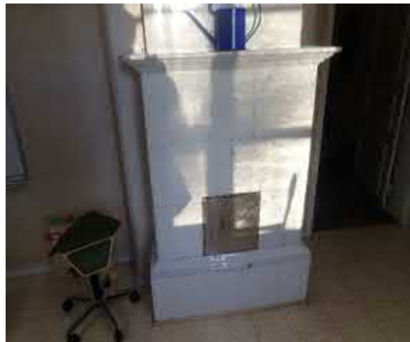
Kakluunit lämmitetään sähkövastuksin.
