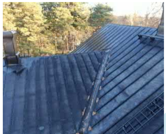
Vesikatto on hyvässä kunnossa.
