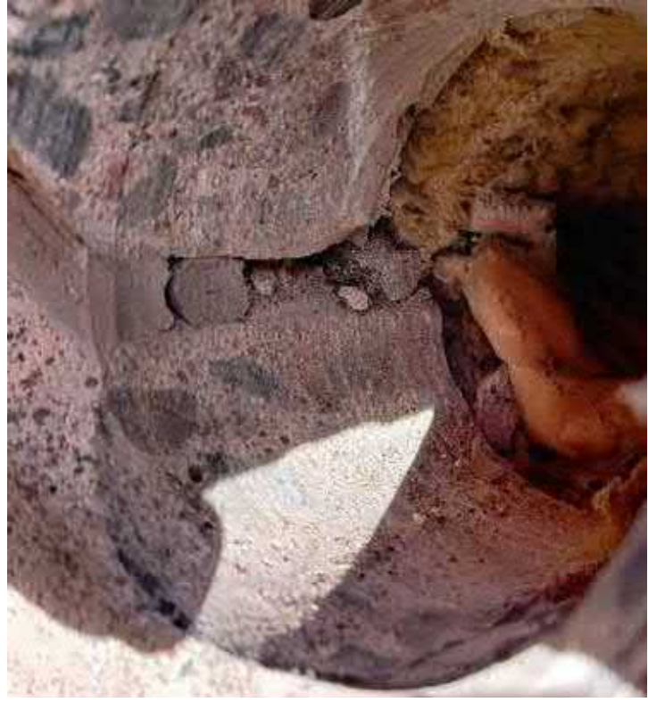
Kuva 116. Saumamassan taakse on asennettu kahteen kerrokseen solumuovikaista. Elementtien saumakohdassa on muovitettu mineraalivillaeristekaista.
