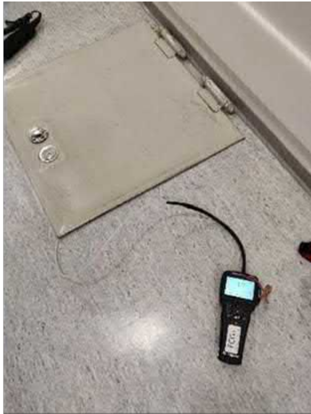
Kuva 63. Alapohjakanaali oli hieman alipaineinen sisäilmaan nähden mittaushetkellä.
