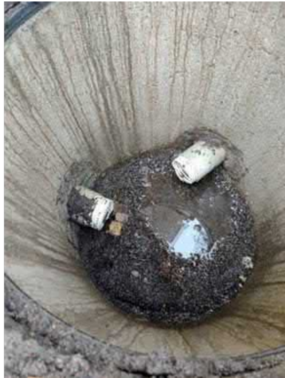
Kuva 15. Salaojan tarkastuskaivo rakennuksen itäseinus- talla.
