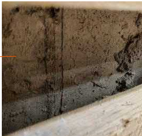
Kuva 41. Rakenne tuulettui eikä poikkeavaa havaittu avauksen kautta.
