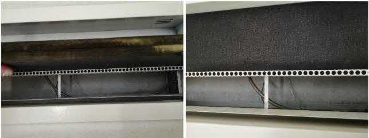
Kuva 191. Luokkatilojen päätelaitteisiin kohdistuneissa pistokokeissa päätelaitteen pinnat todettiin puhtaiksi, eikä mineraalivillakuitujen irtoaminen päätelaitteesta ole todennäköistä.
