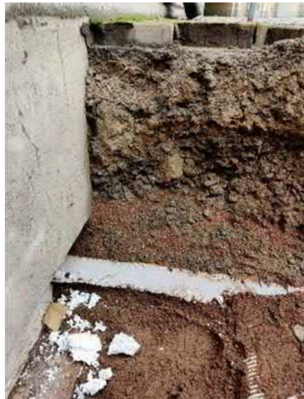
Kuva 10. Koekuoppa KK2. Vierustäytön maa-aines on hienojakoista. Routaeristys kallistaa loivasti rakennusta kohti.
