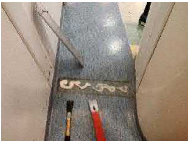
Kuva 95. Auditorion kohdalla 1. kerroksen liikuntasaumarakenne tarkastettiin.
