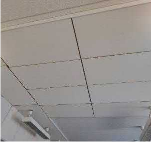
Kuva 175. Luokkatiloissa akustointiin oli käytetty liimattuja akustiikkalevyjä.
