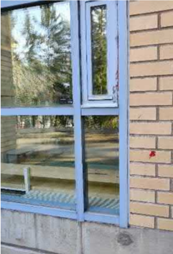
Kuva 121. Käytävien kohdalla ja ruokasalissa ikkunat olivat metallirakenteisia.
