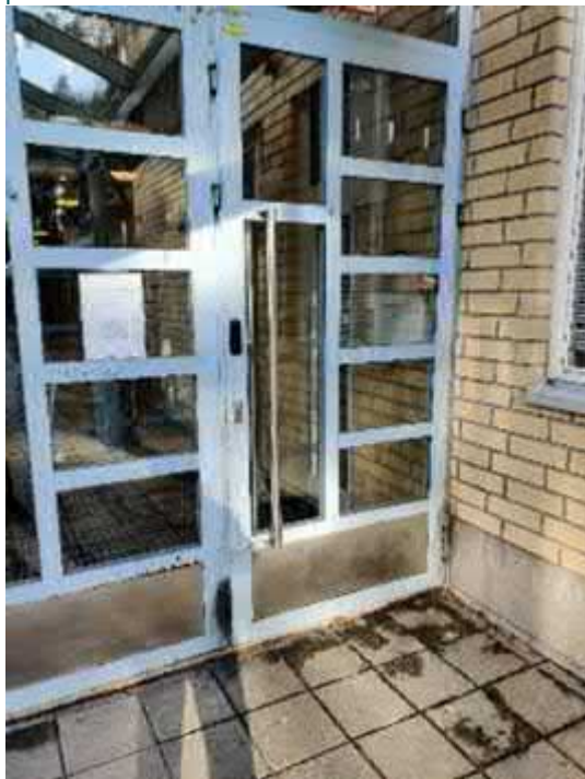
Kuva 133. Ulko-ovet ovat metallirakenteisia.
