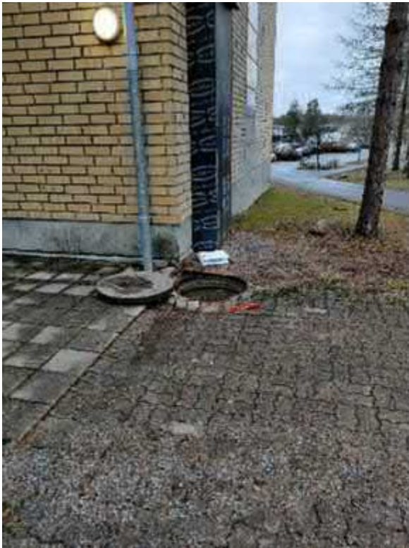
Kuva 14. Rakennuksen ulkopuolelta havaittiin yksi sala- ojan tarkastuskaivo itäseinustalta.
