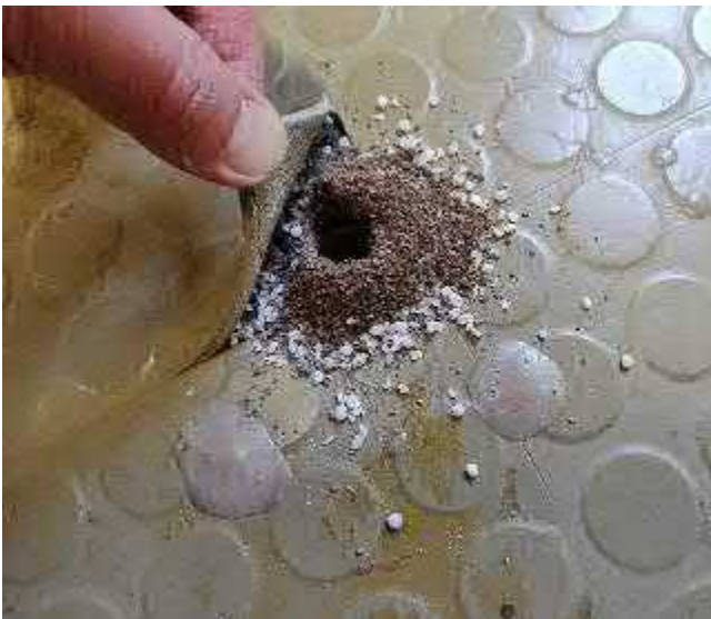
Kuva 56. Rakenteen tarkastus teknisen työn tiloissa. Rakenteen pohjatäyttö on hienojakoista hiekkaa.
