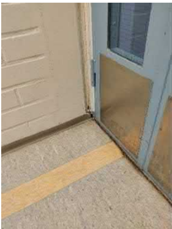
Kuva 97. Liikuntasauva 3. kerroksen välioven vieressä.
