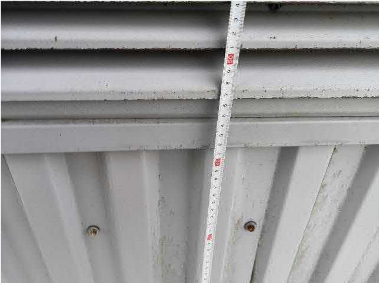
Kuva 186 Ulkoilmasäleikön alareunan korkeus kaikissa kyseisen konehuoneen ulkoilmasäleiköissä on kattopinnasta noin 48 senttimetriä.
