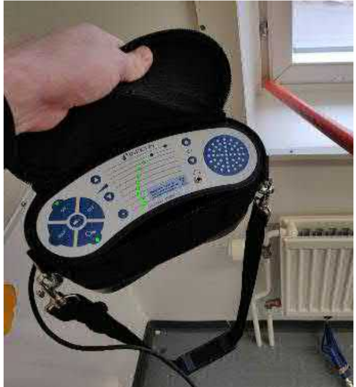
Kuva 132. Ulkoseinä rakenteisiin suoritettujen merkkiainekeiden yhteydessä havaittiin ilmapuotoa ikkunaliittymien kautta.
