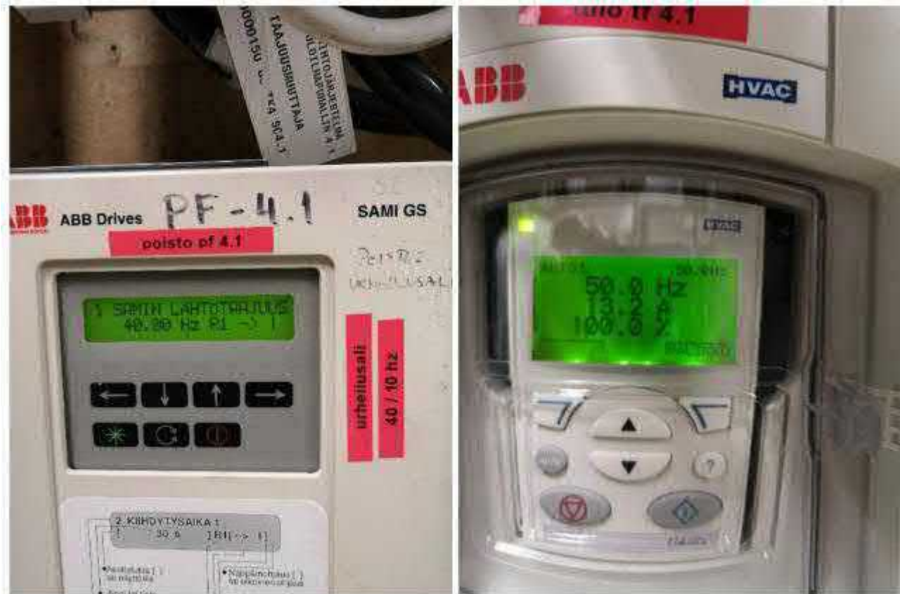
Kuva 187 TK4:n taajuusmuuttaja maksimitehoilla.
