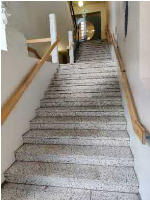
Kuva 89. Yleiskuva rakennuksen itäpäädyssä sijaitsevasta portaikosta.
