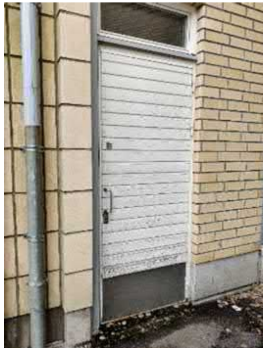
Kuva 134. Osa metallirakenteisista ovista oli paneloitu.
