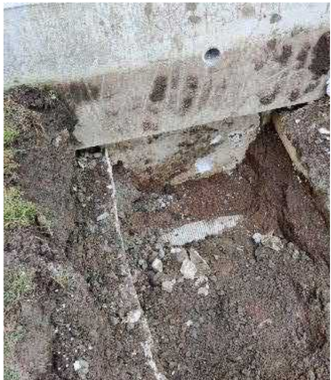
Kuva 17. Koekuoppa KK3 rakennuksen lounaissivustalla. Sala- ojaputki on asennettu hienojakoisen maa-aineksen joukkoon ja sen korkeusasema on anturapinnan yläpuo- lella.
