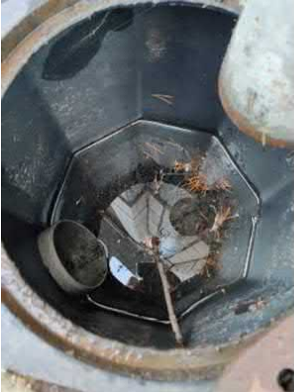
Kuva 18. Sadevesijärjestelmän tarkastuskaivot olivat pääosin siistit.
