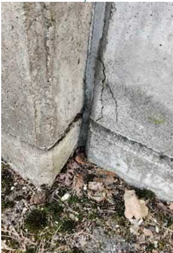
Kuva 113. Halkeama teknisen työn tilojen kohdalla ulkoseinäelementin alaosassa.
