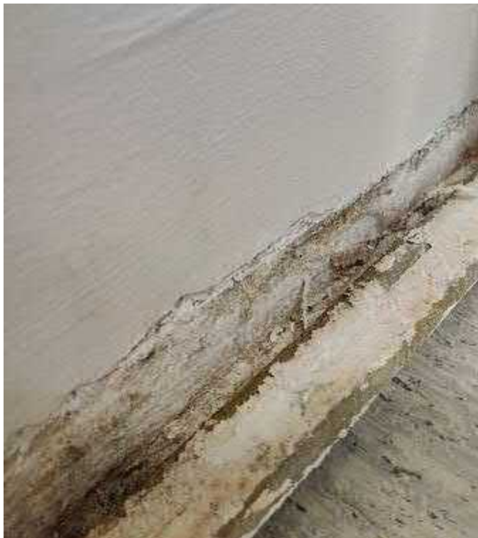
Kuva 70. Kuva 1. kerroksen käytävältä kantavan väliseinän ala-osa.
