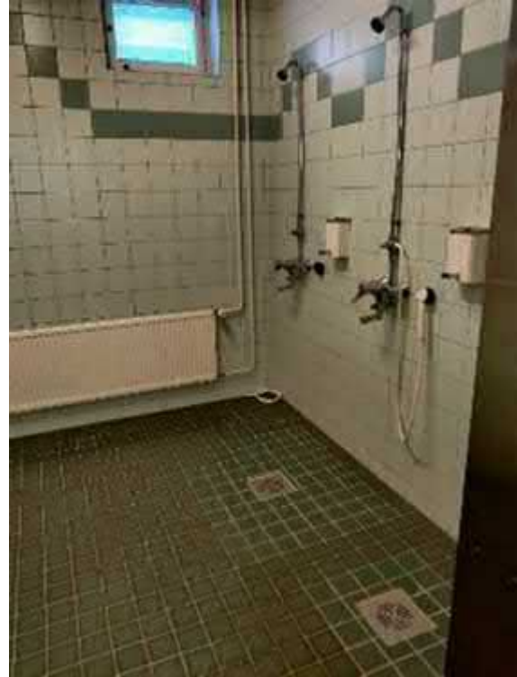
Kuva 181. Liikuntasalin pukuhuoneiden suihkutila.
