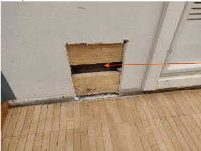
Kuva 40. Auditorion maanvastaisen seinän alaosan rakenteen tarkastus.
