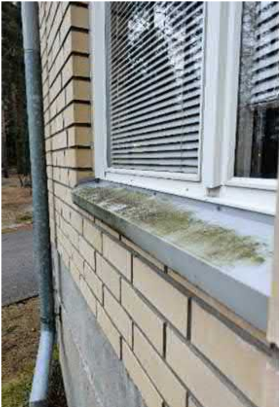
Kuva 123. Suurin osa ikkunoista on kaksipuitteisia ja kaksilasisia puu-alumiini-ikkunoita. Ikkunapellin kalustukset olivat riittävät.
