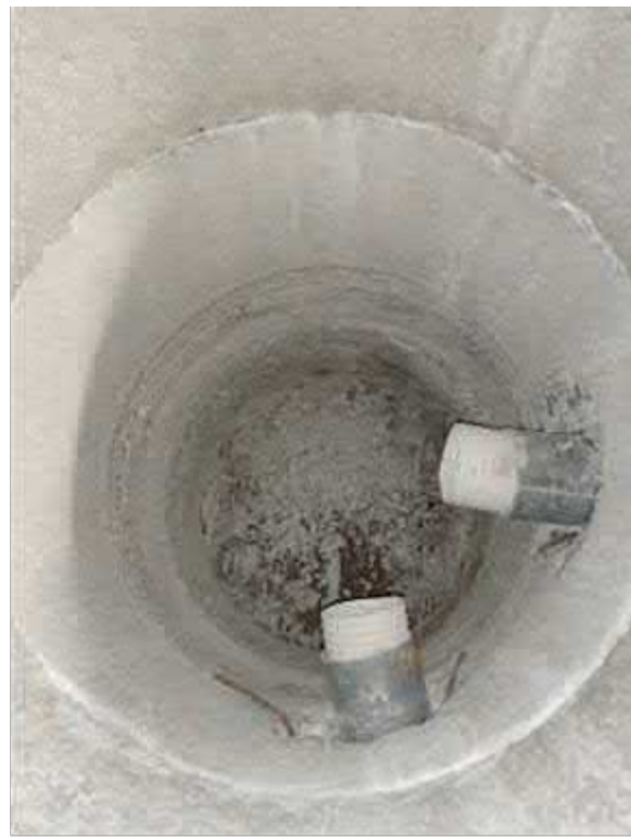
Kuva 13. Sisäpuolinen salaojien tarkastuskaivo rakennuksen pääsisäänkäynnin edustalla rappusten alapuolella.
