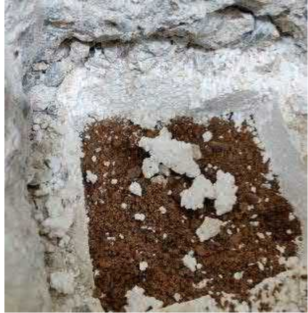
Kuva 55. Avauskohdissa täyttöaines oli soran sijasta hiekkaa. Hiekka oli mittausten perusteella märkää tai kosteaa.
