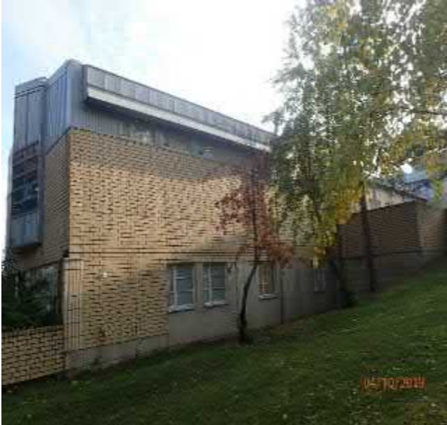
Koulurakennuksen julkisivu on ulkoisesti hyvässä kunnossa.
