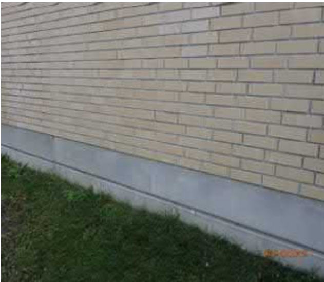
Rakennuksen betonisokkelit ovat hyvässä kunnossa.
