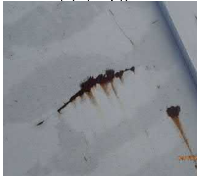
Pistesyöpyä kattopellissä.
