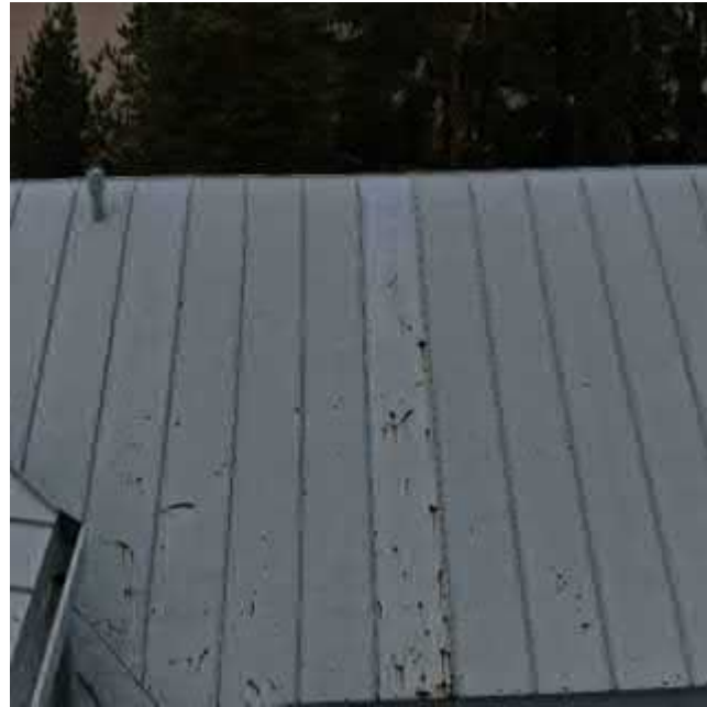
Peltikatolla on paljon pistesyöpyä.
