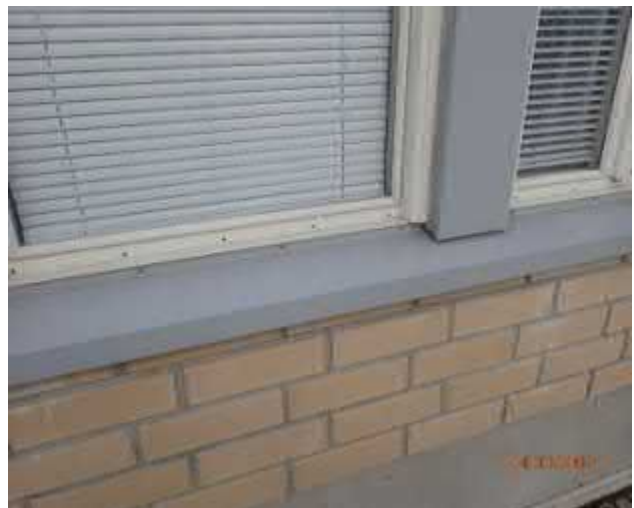
Ikkunat ovat ulkoisesti tyydyttävässä kunnossa.
