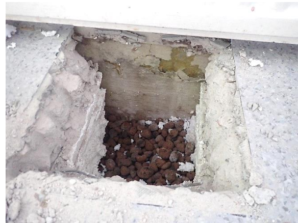
Kuva 45. Rakenneavauksessa ei havaittu välipohjan osalta herkästi vaurioituvia materiaaleja.
