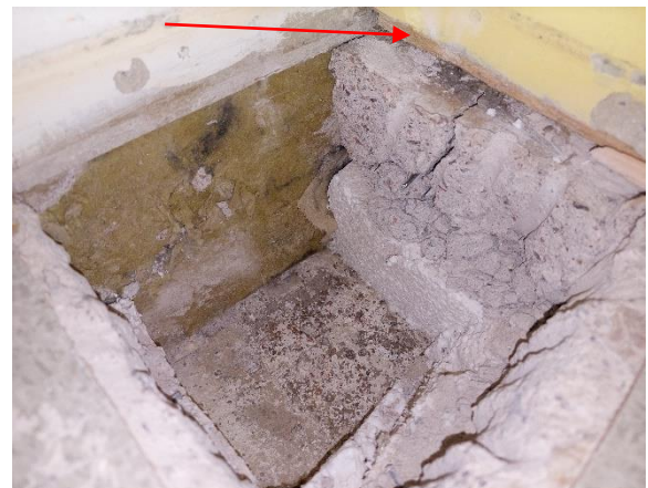
Kuva 105. Rakenneavauksesta AP 3 tehtyjen havaintojen perusteella väliseinäpinnat on perustettu pintalaatan pinnalle.
