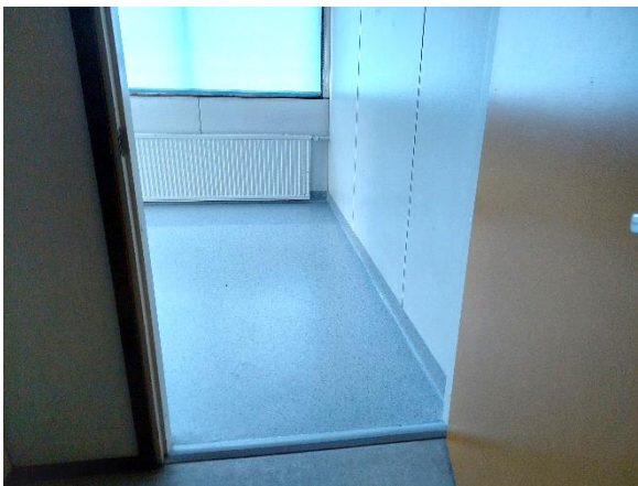
Kuva 42. Välipohjarakenteen päällyste on ryhmähuoneen osalta uusittu. Käytävässä on alkuperäinen juuttipohjainen muovimatto.
