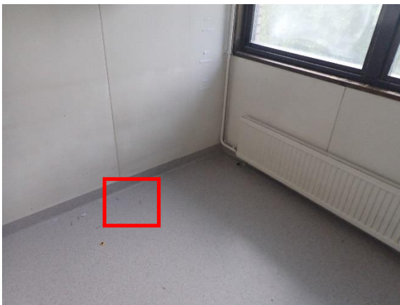
Kuva 27. Rakenneavaus AP 5 A-osaan ulkoilmaan rajautuvaan alapohjarakenteeseen Tiitiäisten lepohuoneeseen.
