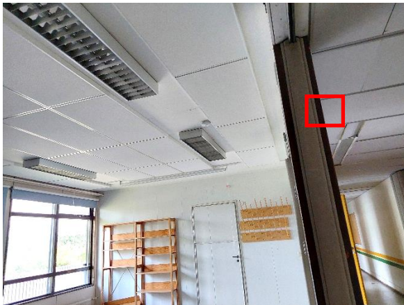
Kuva 122. Rakenneavaus YP 1 tehtiin käytävään laulusalin edustalle.
