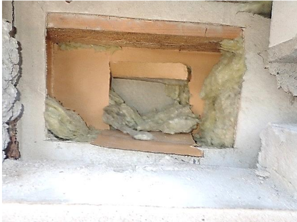
Kuva 73. Rakenneavaus US 3 vastaa toteutustavaltaan rakenneavauksesta US 1 ja US 2 havaittua rakennetta. Ikkunan alapuolelta otetun materiaalinäytteen suoraviljelyssä ei havaittu viitteitä mikrobivauriosta.
