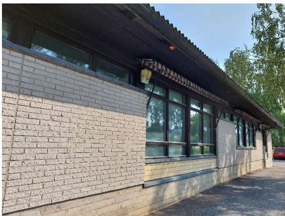
Kuva 47. Julkisivut ovat pääosin tiilimuurattuja. Ikkunoiden alapuolella on puuverhoiltuja alueita. Sokkelirakenne on betonirakenteinen.
