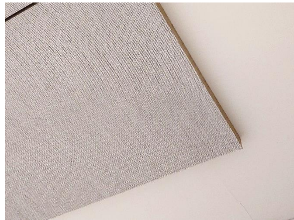
Kuva 138. Akustiikkalevyjen pinta on lasikuitukudosta ja levyjen reunat ovat pinnoittamattomia. On todennäköistä, että levytyksistä irtoaa teollisia mineraalivillakuituja sisäilmaan materiaalien ikääntymisen seurauksena.
