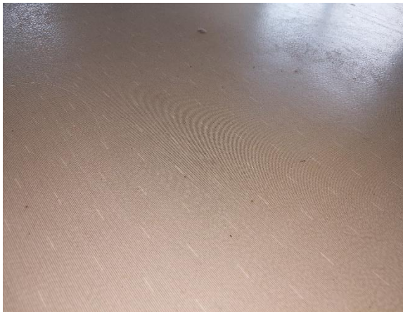
Kuva 9. Veitiköiden ryhmähuoneessa rakennuksen C-osassa lattiapäällyste on uusittu todennäköisesti aikaisemmin alueelle tehtyjen tilamuutosten yhteydessä.
