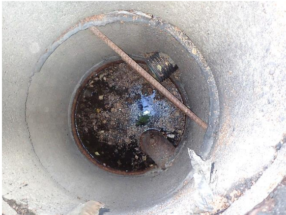
Kuva 129. Yksittäiseen perusvesikaivoon on johdettu salaoja.
