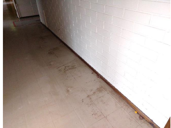
Kuva 8. Käytävötilöjen päällysteenä on monin paikoin 250 mm x 250 mm kvartsivinyyllälaatta.
