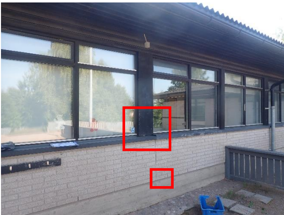
Kuva 71. Rakenneavaus US 3 tehtiin rakennuksen B-osaan Kahvihuoneen ja Uppiksien ryhmähuoneen väliseinän liitoskohtaan.
