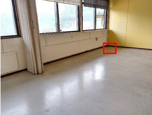
Kuva 17. Rakenneavaus AP 3 tehtiin B-osan kahvihuoneeseen.
