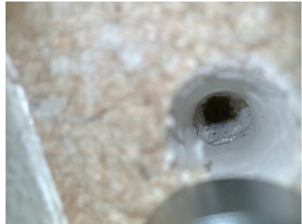
Kuva 16. Rakenneavaus AP 1: Alapohjarakenteena on kaksoisbetonilaatta, jonka lämmöneristeenä on solupolystyreeniä.
