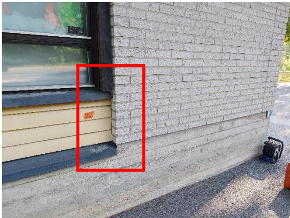
Kuva 59. Rakenneavaus US 1 tehtiin rakennuksen C-osaan Menninkäisten ryhmähuoneeseen. Rakenneavaus tehtiin ulkokautta.
