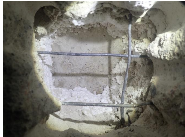
Kuva 26. Rakenneavaus AP 2: Alapohjarakenteena on kaksoisbetonilaatta, jonka lämmöneristeenä on solupolystyreenieriste.
