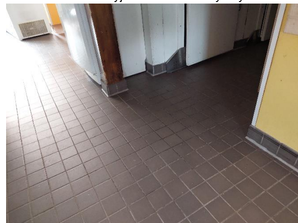
Kuva 11. Keittiön alueen lattiapäällysteenä on uusittu keraaminen laatoitus.
