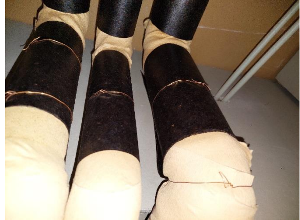
Kuva 119. Suorat putkien osat ovat mineraalivillaeristeisiä ja ne on päällystetty tervapaperilla. Tervapaperissa ei havaittu asbestia tai vaarallisen jätteen ohjeen ylittäviä pitoisuuksia PAH-yhdisteitä.
