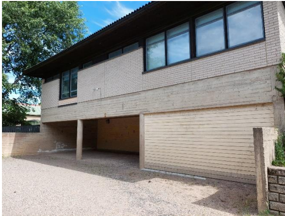
Kuva 3. Rakennuksen A-osassa on ulkoilmaan ja kylmään varastoon rajautuvaa alapohjarakennetta.
