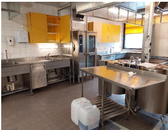
Kuva 104. Keittiön väliseinäpinnat on päällystetty keraamisilla laatoituksin.
