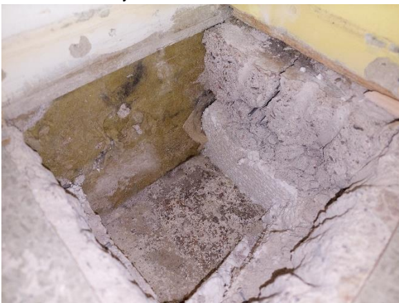
Kuva 21. Rakenneavaus AP 3. Kuvassa nähtävissä pohjalaatta, jonka pinnalla on lämmöneristekerroksena solupolystyreeni ja pintalaatta, joka on valettu ulkoseinän sisempää lämmöneristekerrosta vasten.
