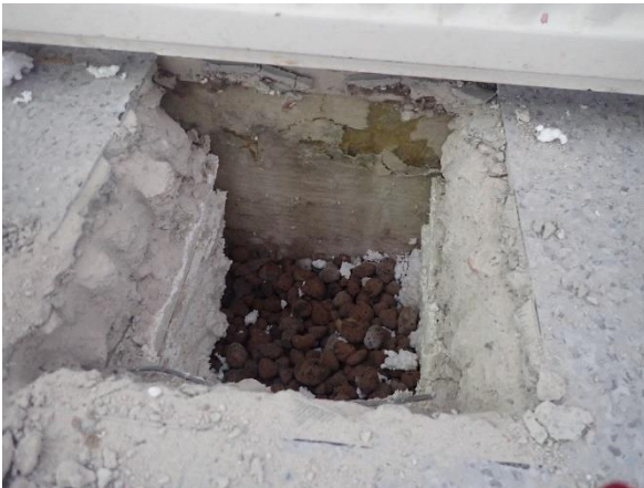
Kuva 79. Rakenneavauksessa US 4 ulkoseinärakenteen toteutustapa vastasi rakenneavausta US 3.
