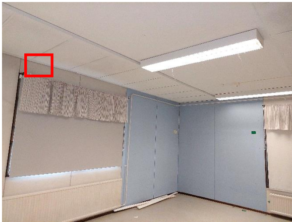
Kuva 125. Rakenneavaus YP 2 tehtiin C-osan ulkonurkassa olevaan ryhmähuoneeseen kuvaan merkittyyn kohtaan.
