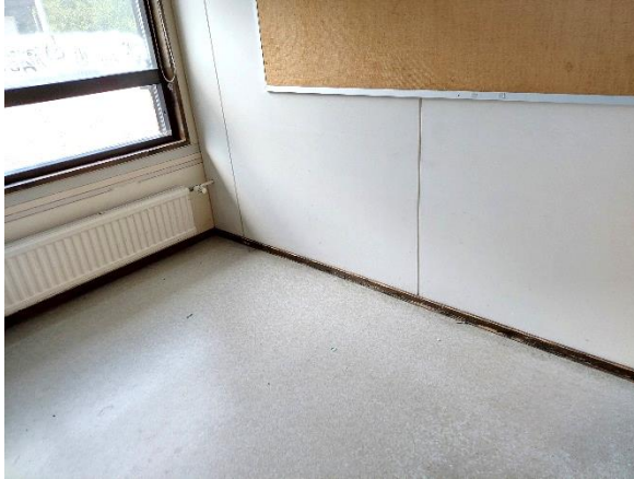
Kuva 7. Ryhmätilojen ja leikkihuoneiden lattiapäällysteenä on monin paikoin alkuperäinen, juuttipohjainen muovimatto.
