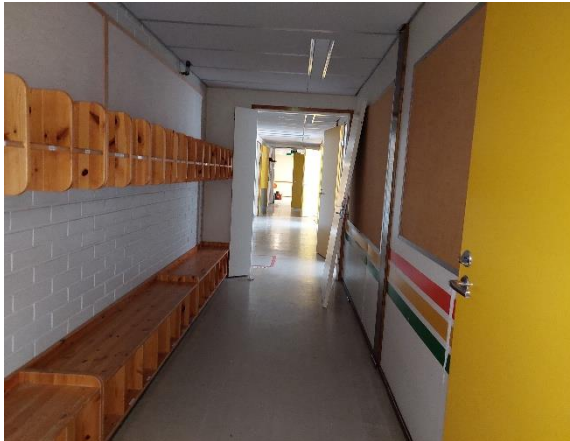
Kuva 100. Rakennuksessa on levyrakenteisten väli-seinien lisäksi tiilirakenteisia, maalattuja väliseiniä.
