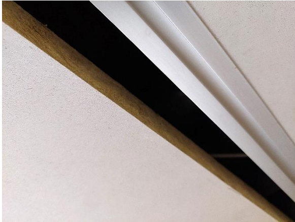
Kuva 139. Käytävien alaslaskut on toteutettu mineraalivillarakenteisin levytyksin. Alaslaskulevytyksien reunat ja yläpinnat ovat käsittelemättömiä.
