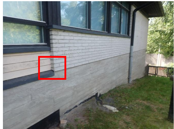
Kuva 82. Rakenneavaus US 5 tehtiin kuvaan merkittyyyn kohtaan rakennuksen A-osaan, laulusalin ulkoseinään.
