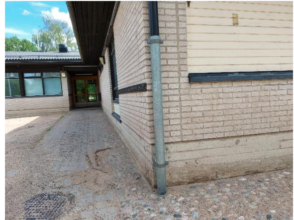
Kuva 4. Pääosin alapohjarakenne on maanvarainen.
