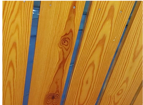
Kuva 121. Märkätilojen katot ovat puuverhoiltuja. Verhoilun yläpuolella on havaittavissa muovi.
