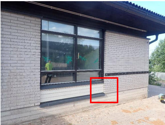
Kuva 69. Rakenneavaus US 2 Tehtiin rakennuksen C-osaan Veitikoiden ryhmähuoneeseen, kuvaan merkittyyn kohtaan.
