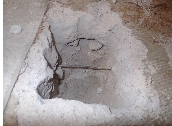
Kuva 24. Rakenneavaus AP 4 vastasi toteutustavaltaan rakennusosien B ja C alapohjarakennetta.
