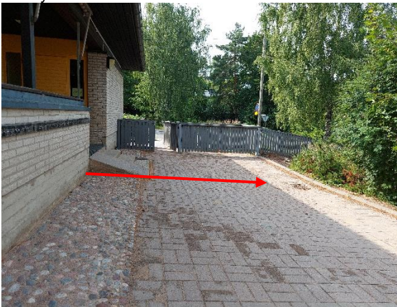
Kuva 133. Pääosin maanpinnat kallistavat rakennuksesta pois päin.
