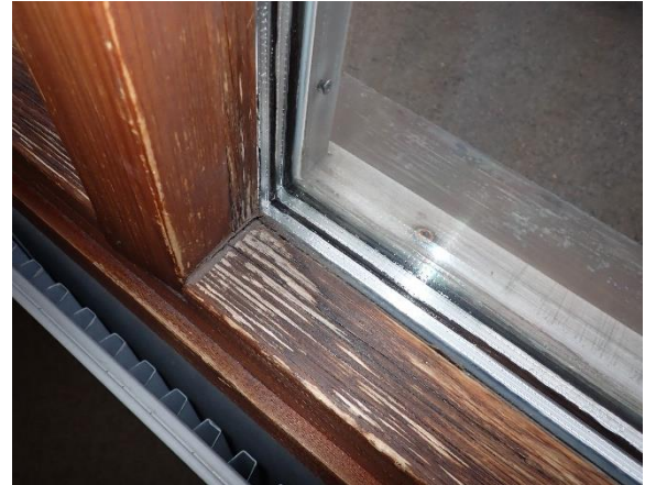
Kuva 56. Pääosin rakennuksessa on alkuperäisiä kiinteitä ikkunoita, joiden kunto on keskimäärin välttävä. Ikkunat eivät myöskään täytä uusille ikkunoille asetettuja lämpötekniisiä vaatimuksia.
