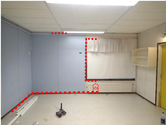
Kuva 89. Merkkiainekoe MAK 2 tehtiin ulkoseinärakenteeseen rakennuksen C-osassa Menninkäisten nurkassa olevaan ryhmähuoneeseen. Havaitut ilmavuotokohdat on merkittyä kuvaan punaisella.
