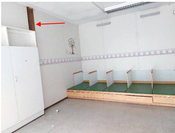
Kuva 98. Kuivien tilojen väliseinärakenteet ovat levyrakenteisia. Pääosin kuivien tilojen seinäpinnat ovat maalattuja. Rakennuksen sisällä on havaittavissa puurakenteisia kantavia pilareita (merkittynä kuvaan nuolella).
