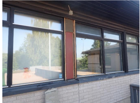
Kuva 74. Rakenneavaus US 3: Ikkunaliitoksessa havaittiin kantava teräspilari, jonka ulkopinnalla oli kuitusementtilevy, ei lämmöneristettä.
