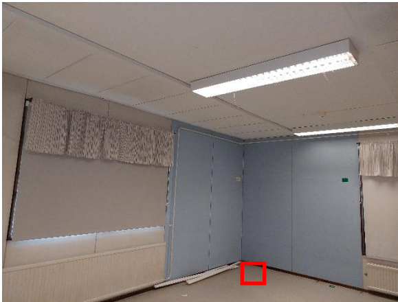
Kuva 15. Rakenneavaus AP 1 tehtiin C-osan ulkonurkassa olevaan ryhmähuoneeseen.
