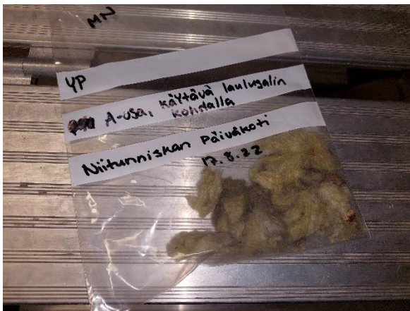
Kuva 124. Mineraalivillaeristeessä havaittiin ilmavirtausten aiheuttamia tummentumia.
