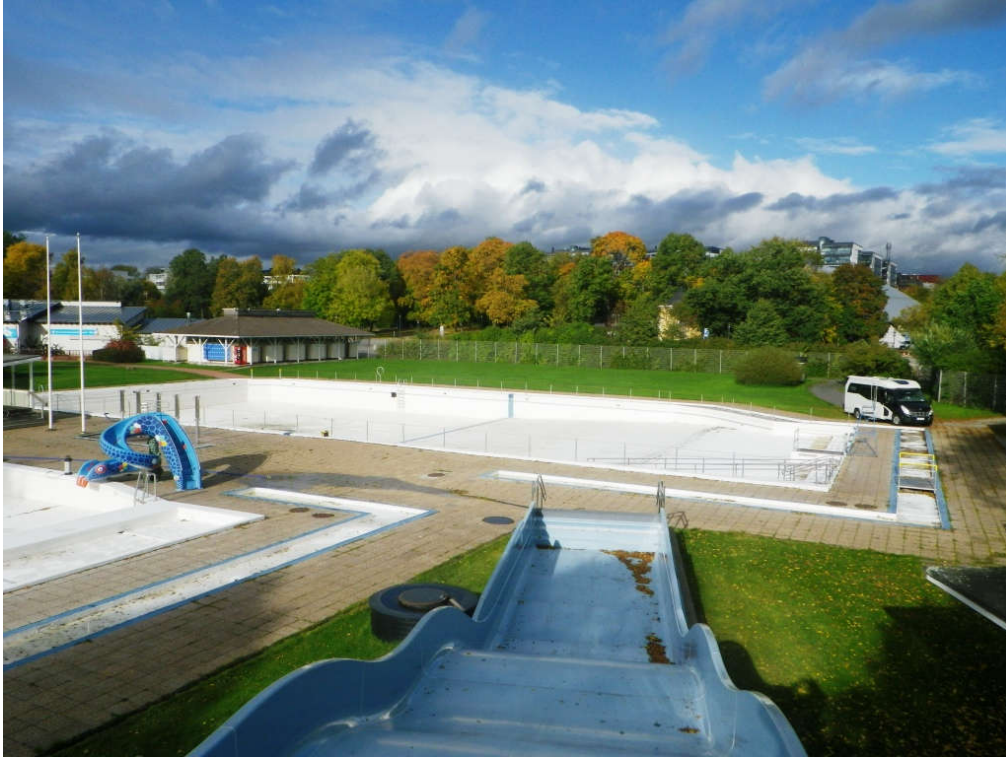
Kuva 1. Yleiskuvaa isolle altaalle ison vesiliukumäen ylätasolta
