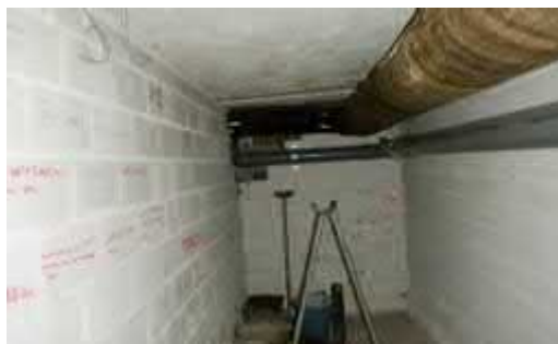
Kuva 6.6.14. Putkitunnelin pääty rakennuksen I-osan alapuolella.
