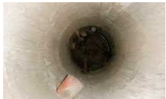
Kuva 6.1.12. Tarkastetuissa kaivoissa ei havaittu viitteitä salaojien toimimattomuudesta.
