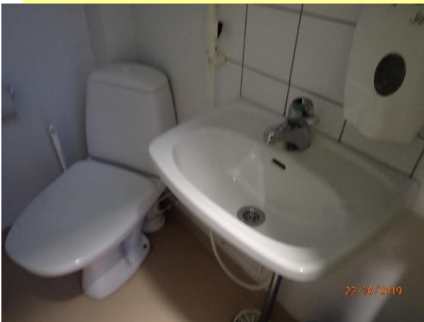
Saniteettitilat ovat tyydyttävässä kunnossa.
