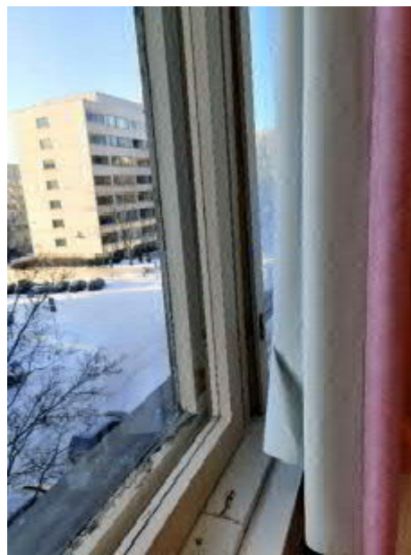
Kuva 6.2.9. Ikkunat eivät mene kunnolla kiinni. Vasemmalla ulkopuite on auki ja oikealla sisäpuite.
