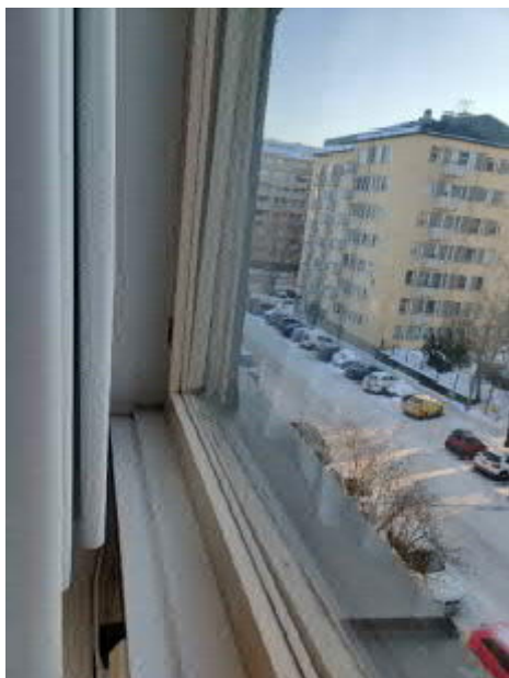
Kuva 6.2.9. Ikkunat eivät mene kunnolla kiinni. Vasemmalla ulkopuite on auki ja oikealla sisäpuite.
