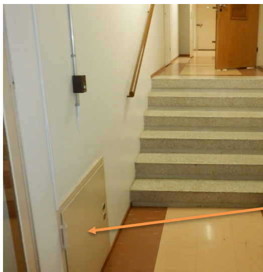
Kuvat 3.1.5 Käytävältä johtaa luukku varastotilan alapuolelle onkalotilaan.
