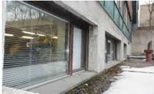
Kuva 6.1.18. Kellarikerroksen ulkoseinää itäsivun alueella.
