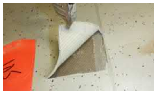
Kuva 5.2.5. Mittauspisteessä V1 maton liimakerros oli aistinvaraisesti tarkastellen vaurioitunut (tummentunut, pehmennyt, pistävä haju).
