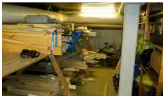
Kuva 5.1.2. Yleiskuvaa alempaan kellarikerrokseen. Kattopintana teräsprofiililevy (liittolaatta).
