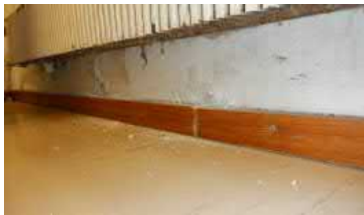
Kuva 5.3.8. Tyttöjen pukuhuoneen maanpaine-seinän sisäpinnan alaosassa vanhoja kosteusvauriojälkiä (ei pintakosteuspikkeämaa).
