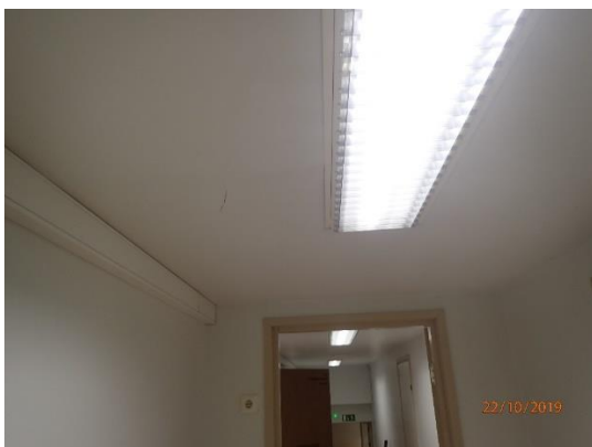
Tilojen valaistus on riittävä.
