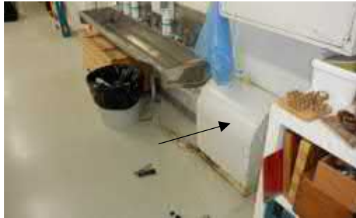
Kuva 6.6.6. Teknisen työn luokkatilassa sijaitseva putkikanaaliläpivienti pellityksen alla.
