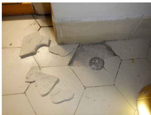
Kuva 3.2.3 1. krs. WC-tila, lattian rakenteen avaus.
