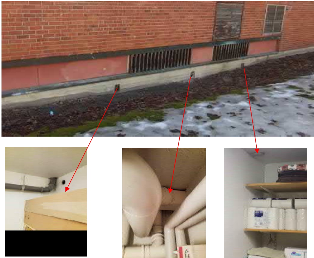
Kuva 6.1.28. Luoteispäädyn sokkelissa, maanpinnan tasolla on painovoimaisia kanavistoja, joista kulkeutuu ulkoilmaa suodattamattomana ensimmäinen kerroksen varastotiloihin.
