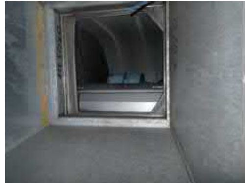
Kuva 7.1.10. Tuloilmarunkokanavistossa ei ollut merkittävästi pölyä.
