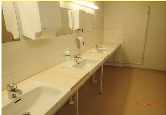
Saniteettitilat ovat tyydyttävässä kunnossa.
