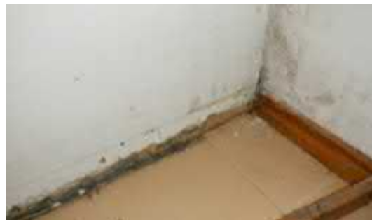
Kuva 5.3.9. Porrashuoneessa maanpaine-seinän eteen on koolattu lastulevyseinä, vanhoja kosteusvauriojälkiä seinän alaosassa (ei pintakosteuspikkeämaa).
