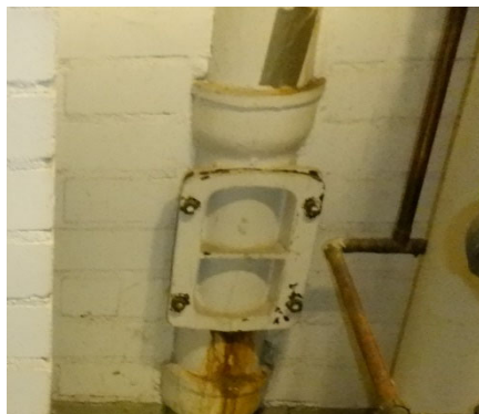
Kuva 4.1.1 Valurautaviemäreiden tiivisteissä ja muhviilitoksissa on voitu käyttää asbestinarua.
