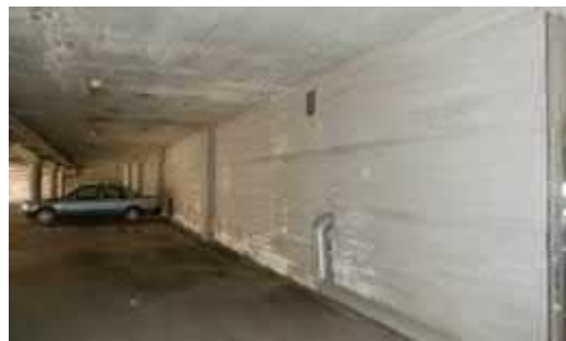
Kuva 6.6.11. Putkitunnelin sisäverhousmuuratun ulkoseinän takana on autohalli.
