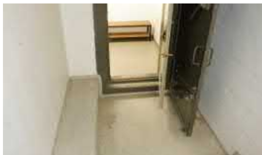
Kuva 5.2.2. Kellarin lattian ja seinien maalipinnoitteissa ei havaittu liiallisen kosteuden aiheuttamia pinnoitevaurioita.
