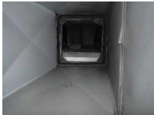
Kuva 7.1.8. Tuloilmarunkokanavistossa ei ollut merkittävästi pölyä.
