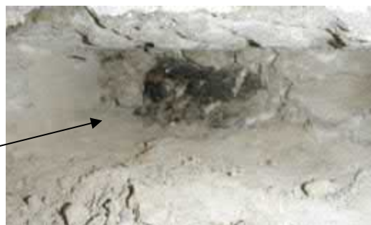
Kuva 6.1.23. Avaus ulotettiin perusmuuriin sisäpinnan betonirakenteeseen.
