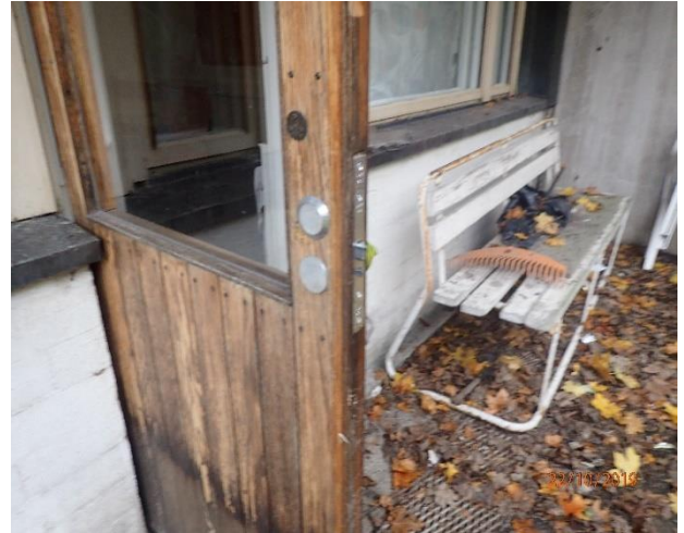
Vähemmällä käytöllä olevat ovet, ovat puurakenteisia.
