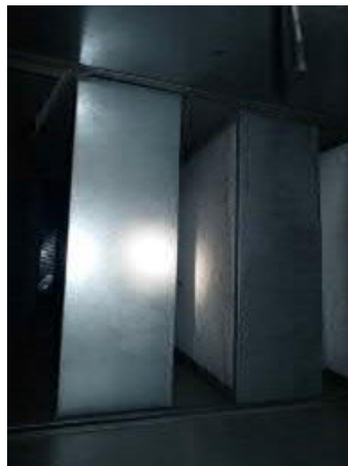
Kuva 7.1.13. Koneessa oli mineraalikuiduttomat ääniloukut, joissa oli jonkin verran likaa.
