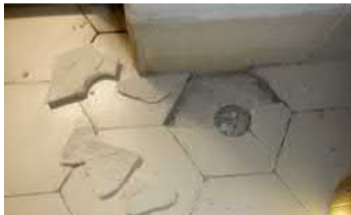
Kuva 6.1.7. AP-rakenteen tarkastus ø32 mm WC-/kylpyhuonetilassa.
