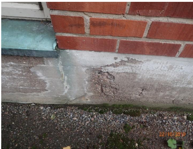
Sokkeli on osin rapautunutta ja teräksiä on esillä.
