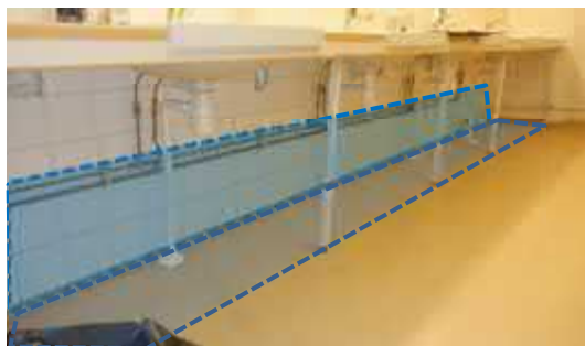
Kuva 5.3.2. Tyttöjen WC-tilassa lavuaarien alla seinän ja lattian pintakosteuspoikkeama-alue. Poikkeama-arvot 100-110, vertailuarvot 50-60.
