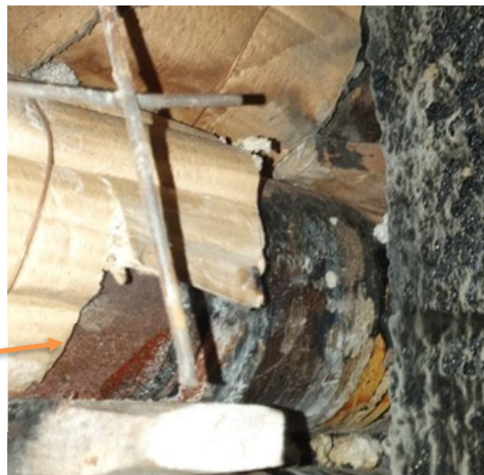
Kuvat 3.1.6 Rakenteissa kulkee aaltopahvilla päällystettyjä vesiputkia. Aaltopahvin ja vesiputken välissä on asbestia sisältävää vaaleaa eristettä.
