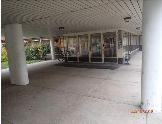
Pääsisäänkäyntien ulko-ovet ovat alkuperäiset.
