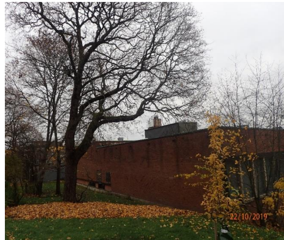
Rakennuksen pohjoispuolella puun lehtiä tippuu katolle.
