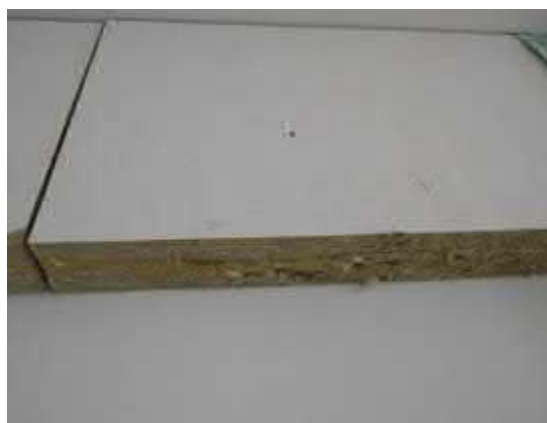
Kuva 7.5.1. Osassa tiloja on vanhoja, reunoiltaan avoimia ja/tai rikkoutuneita akustiikkalevyjä, joista voi irrota kuituja.
