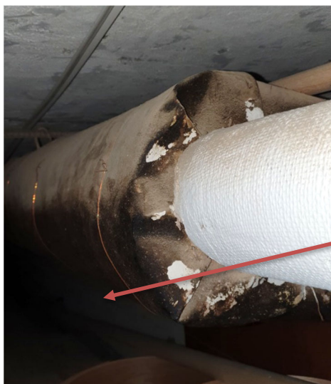
Kuvat 3.1.1 Putken massaeriste sisältää kokemuseräisen tiedon ja aistinvaraisen havainnoin perusteella vaaleaa asbestia.
