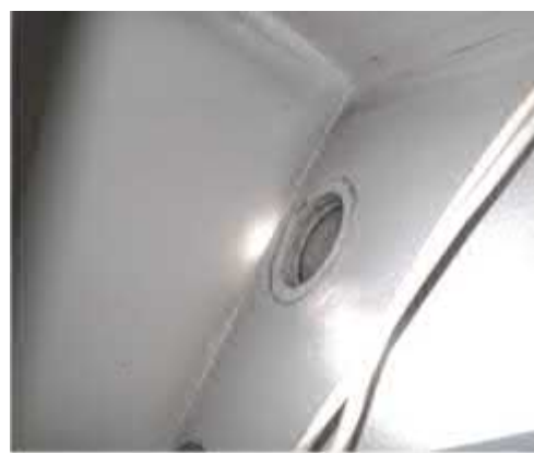
Kuva 7.2.7 Luokan 311 alakaton yläpuolisessa tilassa havaittiin vanha tulppaamaton kanavan pää, joka voi vaikuttaa tilan painesuhteisiin.
