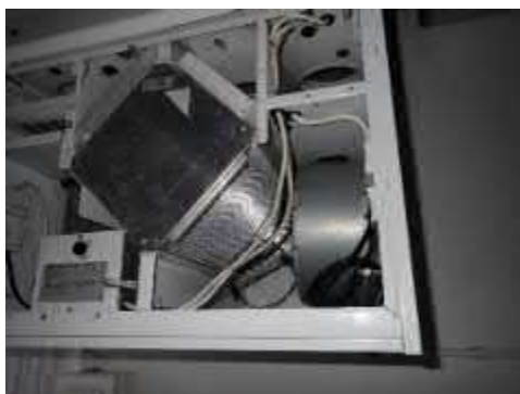
Kuva 7.1.20. Vanha talonmiehen asunnon kone oli sisältä puhdas.
