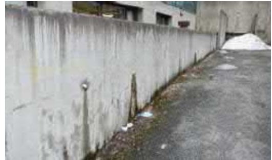
Kuva 6.1.19. Kallioleikkauksen sulkutilan ja perusmuurin välistä tukimuuria.
