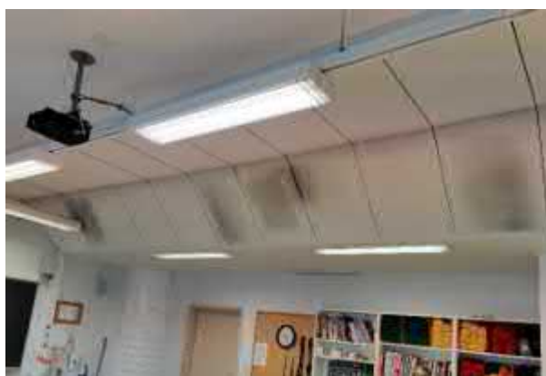
Kuva 7.2.6 Osan I luokkatilojen alakatoissa on tummia jälkiä, jotka viittaavat ilmavuotoihin luokan ja alakatto-tilan välillä.
