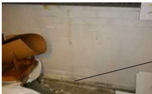
Kuva 6.1.22. Maanpaineseinän rakennetarkastus kellarin varastotilassa.
