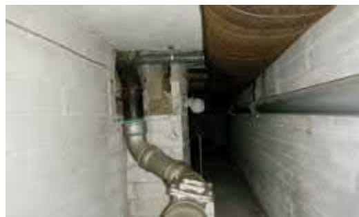
Kuva 6.6.13. Putkitunnelissa on paikoin näkyvissä ulkoseinän eristetila ja epätiivittä rakenneläpivientejä.
