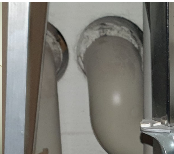
Kuvat 3.1.4 Osa asbestipitoisista putkieristeistä on poistettu. Paikoin asbestipitoisia materiaaleja todettiin myös Genopakilla päällystettyjen putkien läpivienneissä.
