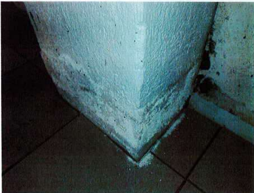
Huoneisto. Suoloja pilarin alaosassa.
