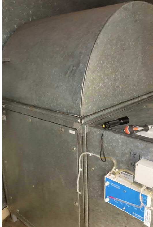
Kuva 4.5.20. Liikuntasalin tuloilmakoneelle TK-4 johdetaan palautusilmaa poistokoneelta PK-4.
