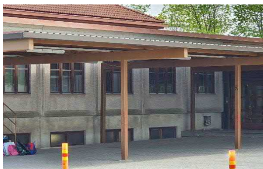
Kuva 4.3.24. Sisäpihan puolella ulkoseinät ovat osin maanvastaisia maanpaine-elementtejä.
