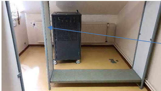
Kuva 4.3.42. Hallin P01 portaikoiden ja porrastasanteen alla olevassa ilmatilassa ei havaittu muottilautoitusta tai muuta vaurioituvaa materiaalia.
