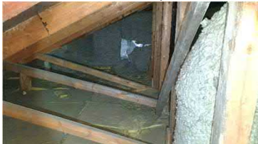
Kuva 4.3.40. Rakennuksen koillisreunalla raitisilmakanava jakaa ullakkotilan kahteen osaan.
