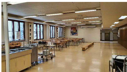
Kuva 4.4.4. Ruokasalin katossa on alkuperäiset akustiikkalevyt, jotka voivat toimia teollisten mineraalikulujen lähteinä.
