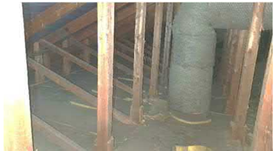
Kuvat 4.3.38-39 Ullakkotilan tuulettuvuus oli heikkoa, puurakenteet olivat kuitenkin hyväkuntoiset eikä tilassa havaittu vesivuotojälkiä.
