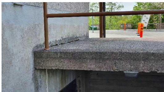
Kuva 4.1.9. Liikuntasaliin vievän portaikon katos johtaa sadevesiä kohti rakennusta.
