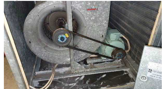
Kuva 4.5.9. Puhallinkammio on siisti ja kankaalla päällystetty, kone on ikäisekseen hyväkuntoinen.
