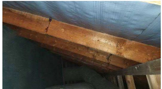
Kuva 4.3.41. Aluskate oli hyväkuntoinen ja riittävästi limitetty.
