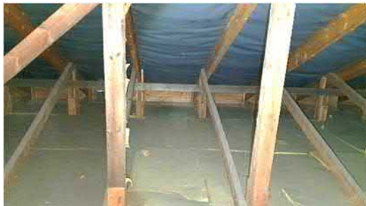
Kuvat 4.3.38-39 Ullakkotilan tuulettuvuus oli heikkoa, puurakenteet olivat kuitenkin hyväkuntoiset eikä tilassa havaittu vesivuotojälkiä.
