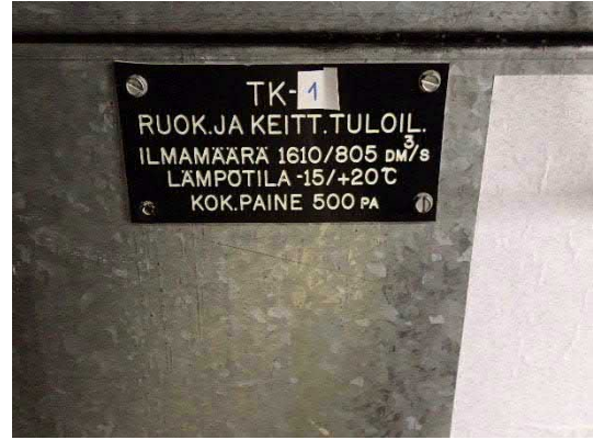
Kuva 4.5.3. Tuloilmakoneet on nimetty uudelleen (TK-2 -> TK-1 jne).
