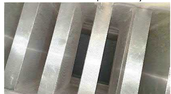
Kuva 4.5.25. Tuloilmakoneelle lähtevässä kanavassa on äänenvaimennusmateriaalia reikäpellin takana
