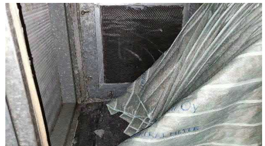
Kuva 4.5.15. Suodatinkammio on puhtaampi kuin TK-1:ssä.
