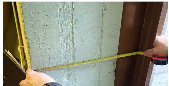
Kuva 4.3.17. Rakennevahvuudet vastasivat suunnitelmia.
