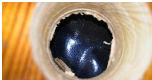
Kuva 4.3.9. Liikuntasalin alapohjassa on höyrynsulkumuovi mineraalivillalämmöneristeiden yläpuolella, avaus R07.
