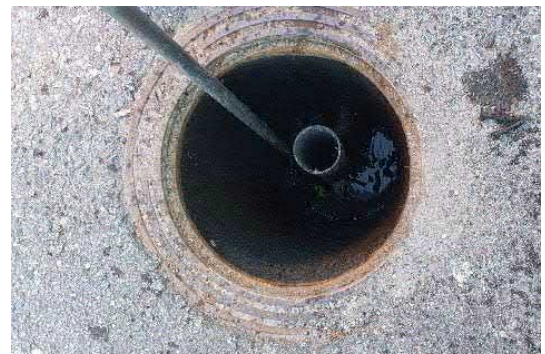
Kuvat 4.5.30 ja 4.5.31. Sadevesikaivon puhdistus oli käynnissä tutkimusten aikana.
