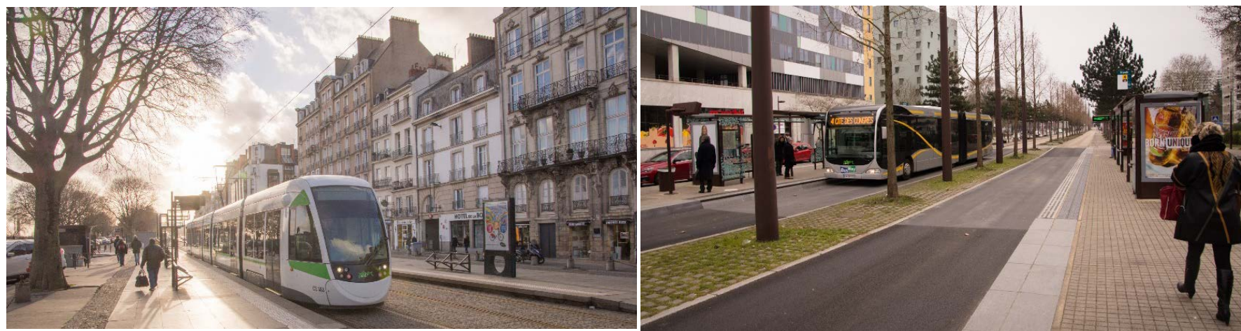
Bild 20. I Nantes finns utöver tre spårvägslinjer (vänster) dessutom en superbusslinje (höger).
