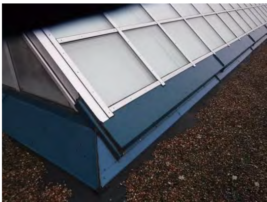
Kuvat 56 ja 57. Lounaan puoleisella vesikatolla olevan kattokuvun peltiosat ovat alkaneet ruostua.
