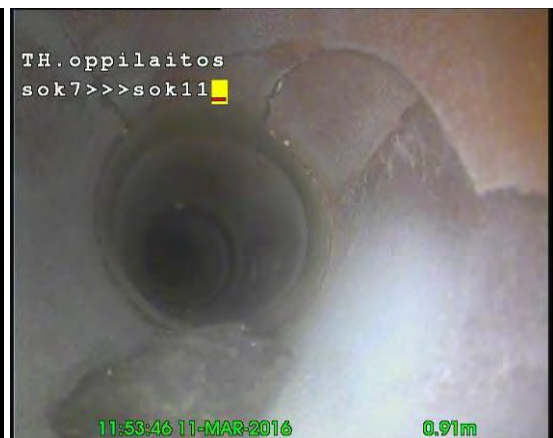
Kuvat 16 ja 17. Savitiiliputkessa siirtymää uimahalliosan kaakkoispäädyssä (kuva 16). Savitiiliputki on halki uimahalli- ja liikuntasaliosan alla (kuva 17).
