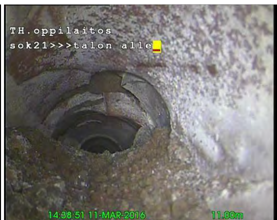
Kuvat 18 ja 19. Savitiiliputki on sortunut auditorion edustalla (kuva 18) ja porrashuoneen alla (kuva 19).
