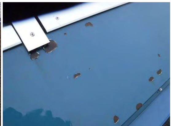
Kuvat 56 ja 57. Lounaan puoleisella vesikatolla olevan kattokuvun peltiosat ovat alkaneet ruostua.
