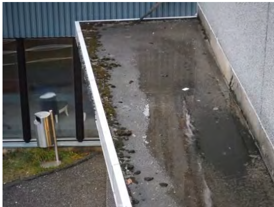
Kuvat 64 ja 65. Katoksella makaa vesi, ja ulkoseinän betoni on rapautunut katoksen ja seinän liitoskohdasta.
