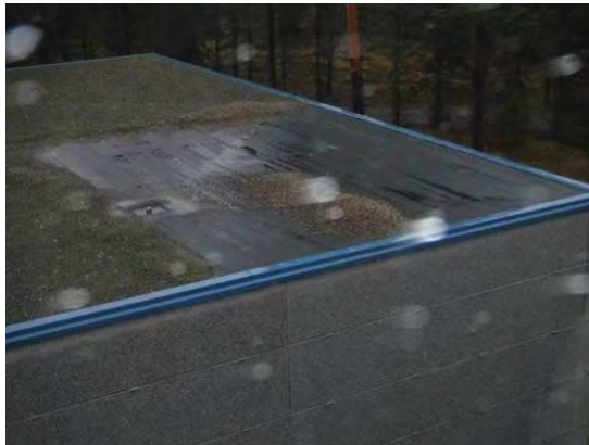
Kuva 74. Uudemman osan matalamman puolen katon nurkasta puuttuu singeliä.
