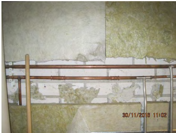
Kuva 4. Kuvassa uusittuja vesijohtoja.
