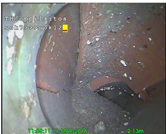
Kuvat 18 ja 19. Savitiiliputki on sortunut auditorion edustalla (kuva 18) ja porrashuoneen alla (kuva 19).
