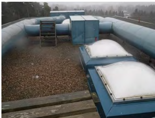
Kuvat 70 ja 71. Maalipinta hilseilee vesikatolla olevista ilmanvaihtokanavista.
