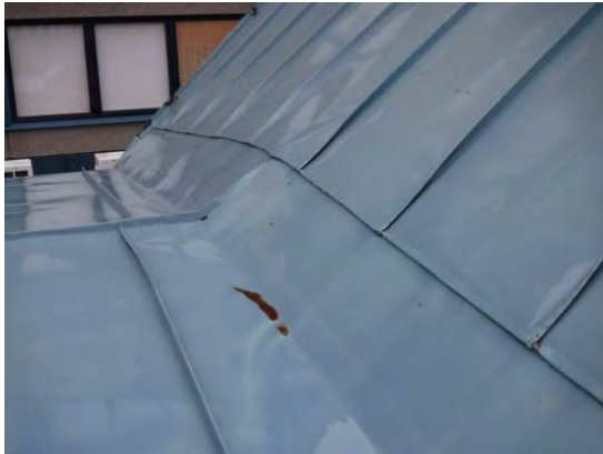
Kuvat 54 ja 55. Kirjaston vesikatolla ilmanvaihtokonehuoneen peltivuoraus on alkanut ruostua.
