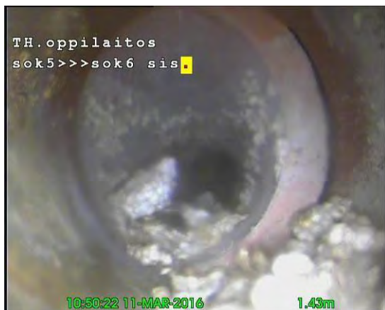
Kuvat 16 ja 17. Savitiiliputkessa siirtymää uimahalliosan kaakkoispäädyssä (kuva 16). Savitiiliputki on halki uimahalli- ja liikuntasaliosan alla (kuva 17).
