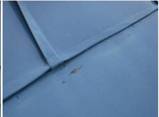
Kuvat 54 ja 55. Kirjaston vesikatolla ilmanvaihtokonehuoneen peltivuoraus on alkanut ruostua.
