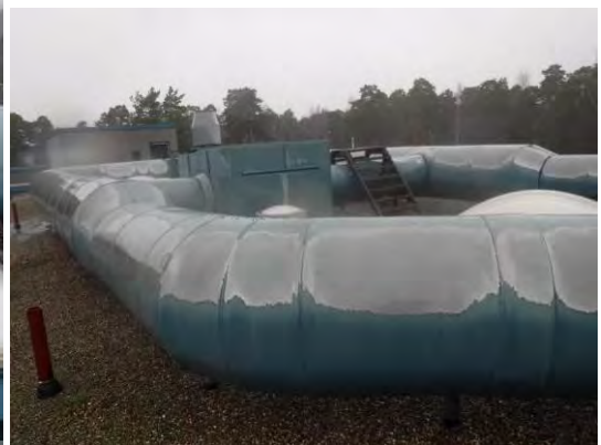
Kuvat 70 ja 71. Maalipinta hilseilee vesikatolla olevista ilmanvaihtokanavista.
