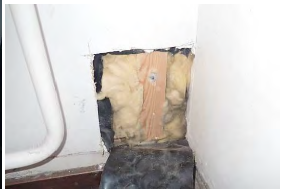
Kuva 45 ja 46. Uuden osan opetus- ja liikuntatilojen yhdyskäytävällä on valesokkelirakennetta. Seinän eristeen todettiin tummuneen ilmavuodoista (avaus R6).
