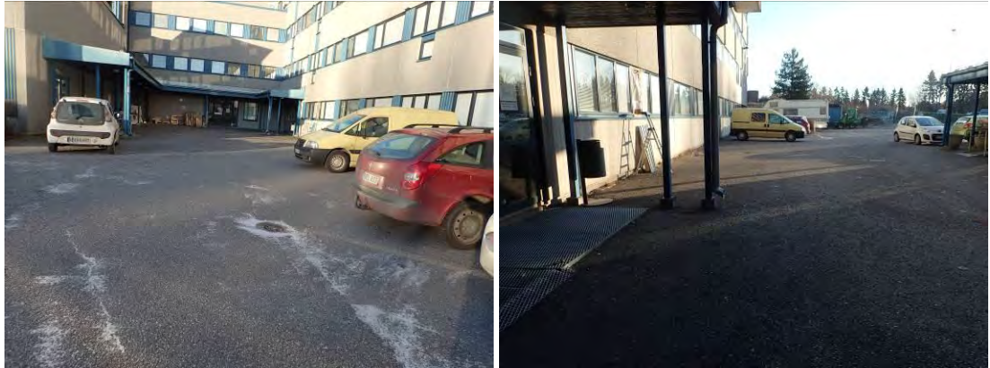
Kuvat 11 ja 12. Uuden ja vanhan puolen välinen asfaltoitu piha.
