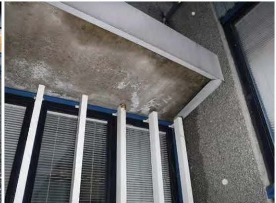
Kuvat 62 ja 63. Kuva pääsisäänkäynnin kohdalta. Katoksen alapinnassa on runsaasti kosteusjälkiä.
