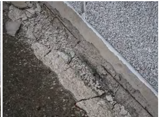
Kuvat 64 ja 65. Katoksella makaa vesi, ja ulkoseinän betoni on rapautunut katoksen ja seinän liitoskohdasta.
