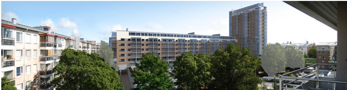
Luonnosvaiheen suunnitelmien sisäpihanäkymät. Kuvat Arkkitehtitoimisto Jarmo Saarinen Oy (Huom.: Suunnitelma on muuttunut ehdotusvaiheessa. Luonnosvaiheen kuvat ovat mukana havainnollistamassa varjostusvaikutuksia, koska vastaavia ajantasaisia kuvia ei ollut.)
