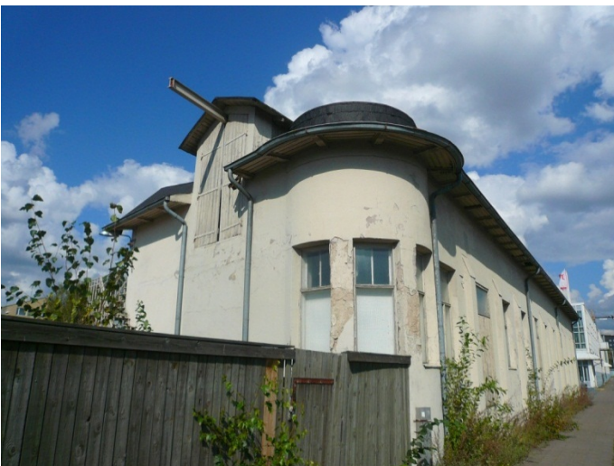
Lounaispääty, myöhemmin lisätty nosturiuloke ullakkoon.
