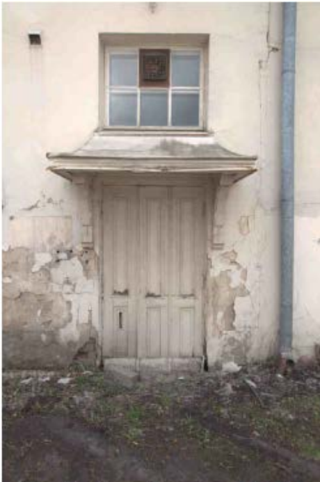
Ulko-ovi rakennuksen koillisivulla.
