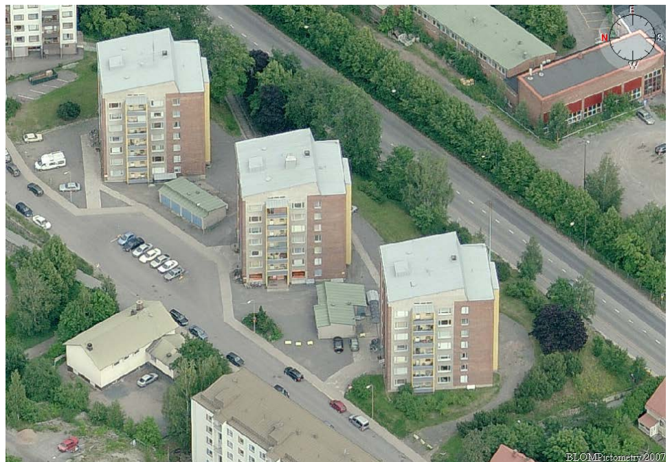
Kuva 11. Ilmavalokuva Juhannuskadun kerrostaloista (©Blom).
