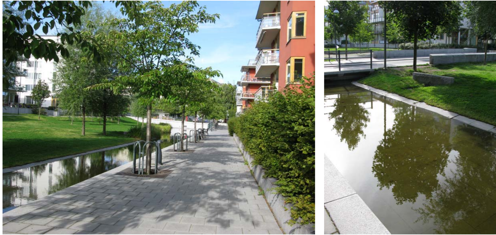
Hulevesien käsittelyä asuinalueen sisällä, esimerkkivalokuvat Hammarby Sjöstadista, Tukholmasta
