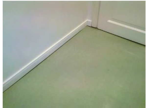
Kuva 78. Valokuva väliseinän ja alapohjan liitoksesta varastossa.
