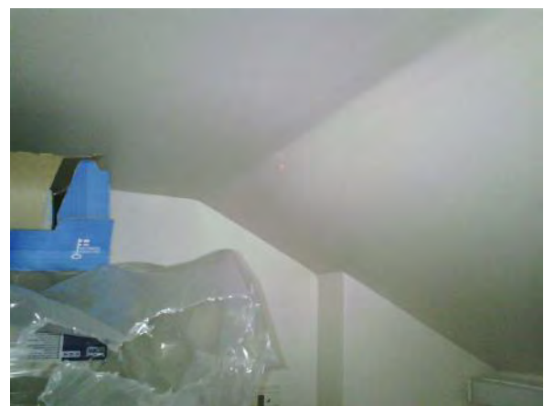
Kuva 320. Rakennuksen toisen kerroksen yläpohjan liitoksesta.
