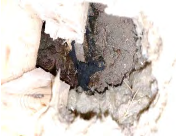
Kuva 218. Rakenneavaus VP2: Mineraalivillan alapuolella on lämmöneriste kerroksina sammalta, hiekkaa ja sammal/metsänpohjajuurakkoa.
