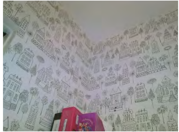
Kuva 226. Valokuva ulkoseinän ja välipohjan liitoksesta.
