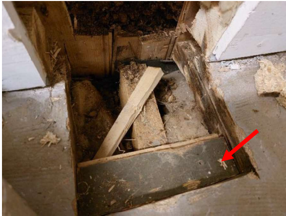
Kuva 22. Harmaa lattiamaalit ei sisällä asbestia.
