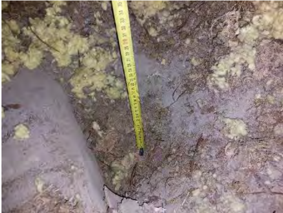
Kuva 307. Rakenneavauksen toteutustapa vastaa yläpohja-avausta YP2
