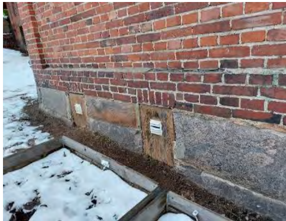
Kuva 196. Rakennuksen sokkeli on luonnonkivi-perusteinen.
