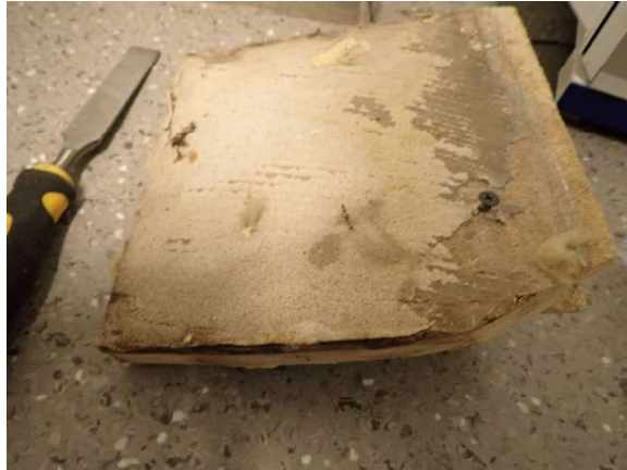
Kuva 6. Alemman lastulevyn lattiatasoite ei sisällä asbestia.
