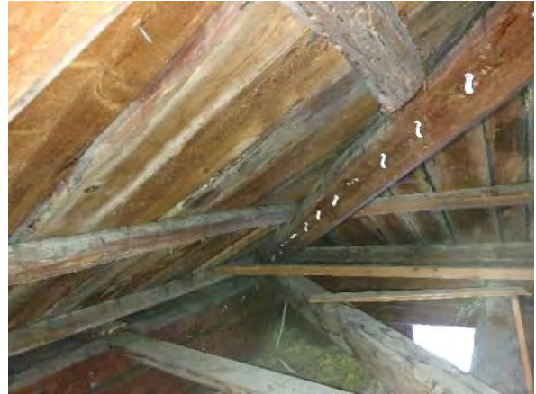
Kuva 289. Yleiskuva yläpohjasta luoteissiivestä.
