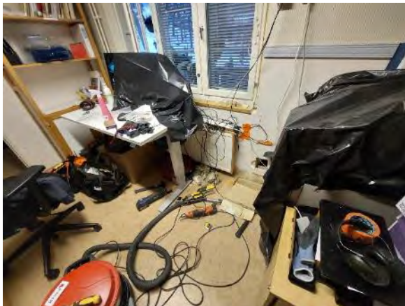
Kuva 143. Rakenneavaus IKK1. Rakennuksen ikkunat ovat uusittuja.
