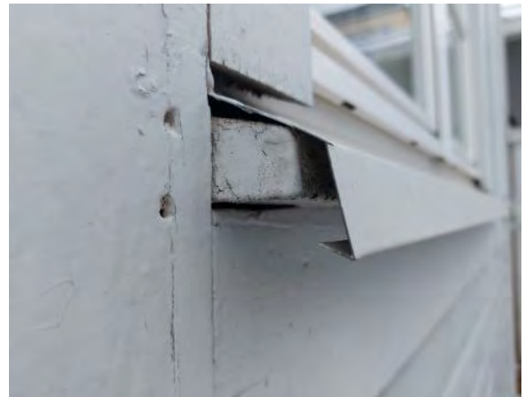
Kuva 98. Puurakenteiset ikkunalaudat on pellitetty.
