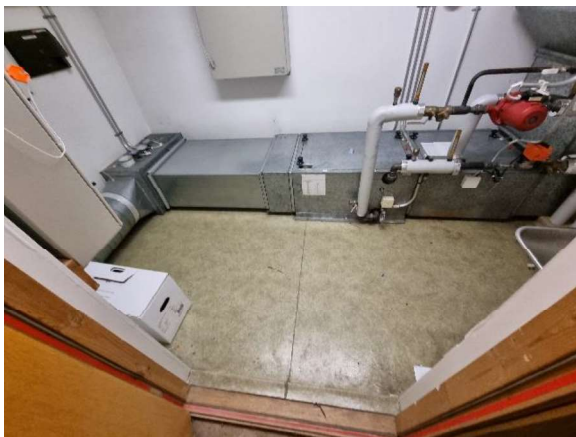
Kuva 12. IV-konehuoneen harmaa muovimatto, liima tai tasoite eivät sisällä asbestia.
