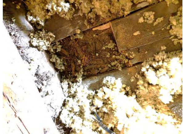
Kuva 334. Rakenneavaus YP4, laudoituksen päällä lämmöneristeenä on puhallusvilla.
