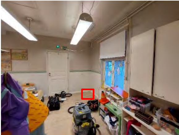
Kuva 65. Rakenneavaus AP 9 tehtiin rakennuksen 2 ryhmähuoneeseen 2, kuvaan merkitylle alueelle.
