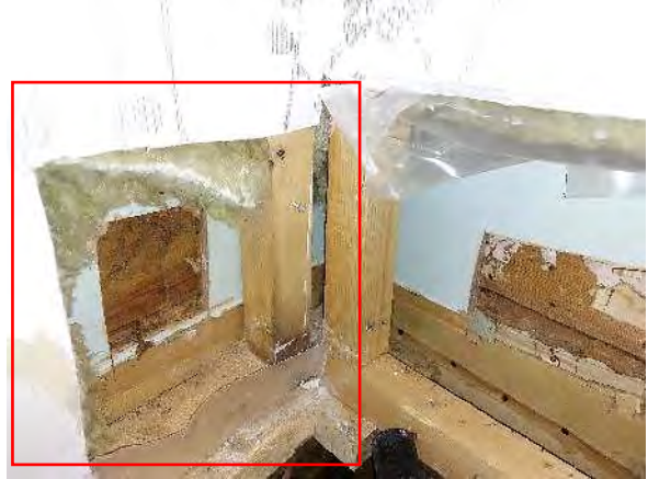
Kuva 131. Rakenneavaus US4. Sisäverhouksen takana on mineraalivillaeriste sekä vanha kovalevy ja pinokopahvit. Ulkoseinän avaus merkittynä kuvaan.
