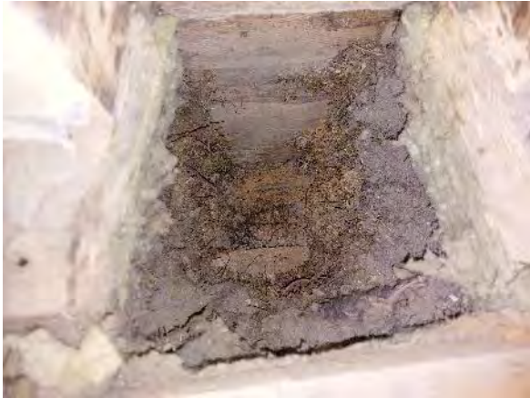
Kuva 15. Eristekerroksen alapuolella on kaksinkertainen aluslaudoitus.
