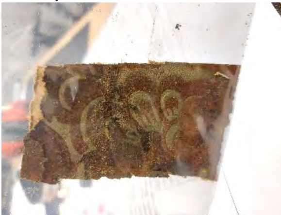
Kuva 108. Pinkopahvin pinnalla on vanhoja tapetteja.
