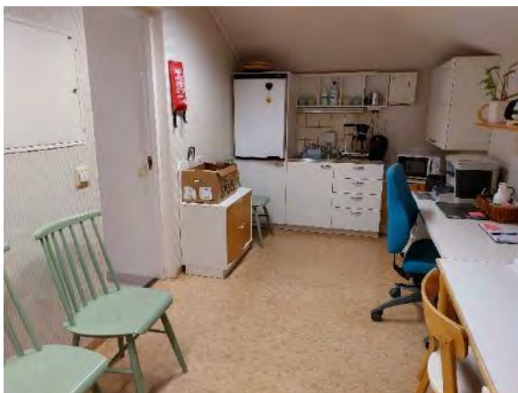
Kuva 204. Välipohjan päällysteenä on työskentelytiloissa muovimatto. Kuva rakennuksen 1 yläkerran toimistotilasta.
