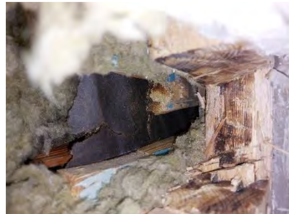
Kuva 125. Rakenneavauksen alaosassa on havaittavissa vanha sisäverhouspaneeli, jonka takana havaittiin ilmansulkukerroksena tervaperia. Sisäpuolinen lämmöneriste on vähintään paikoin kahden tiiviin rakennekerron välissä.
