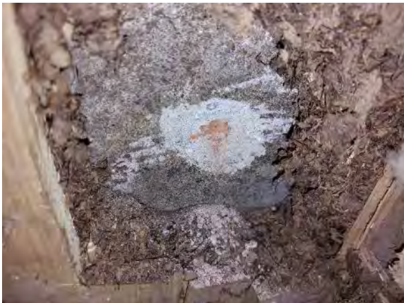
Kuva 200. Rakenneavaus US12: Ulkoseinän alkuperäisenä lämmöneristeenä on käytetty turvetta.
