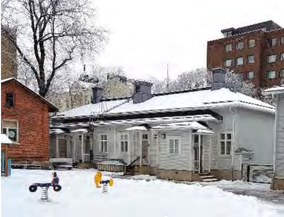
Kuva 158. Rakennuksen 1 ja 2 ulkoseinät ovat puuverhoiltuja hirsirakenteisia seiniä. Kuva rakennuksesta 1.
