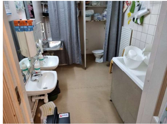
Kuva 9. WC:n harmaa muovimatto, liima tai tasoite eivät sisällä asbestia.
