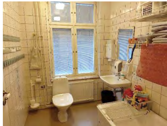
Kuva 12. Rakennuksen 1. märkätiloissa on käytetty lattiapäällysteenä muovimattoa.
