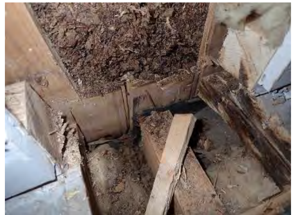
Kuva 236. Rakennusavaus VP3: Välipohjan lämmöneristeenä on käytetty turvetta sekä lisälämmöneristeenä mineraalivillaa.
