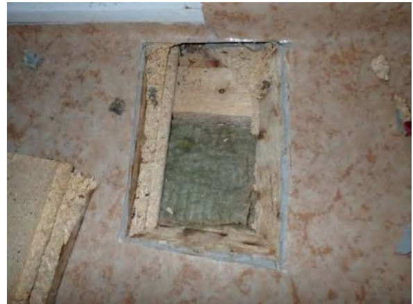
Kuva 217. Rakenneavaus VP2: Välipohjan lisälämmöneristeenä on käytetty mineraalivillaa, hiekkaa ja sammal/metsänpohjajuurakkoa.
