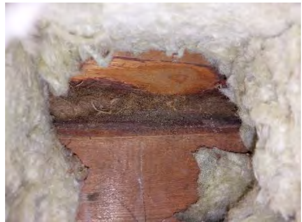
Kuva 177. Rakenneavaus US11. Hirsien tilkemateriaalina on pellavarive.
