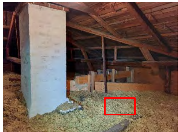
Kuva 306. Rakenneavaus YP7, rakenneavaus tehtiin kuvaan merkittyyn kohtaan johtajan huoneen yläpuolelle.
