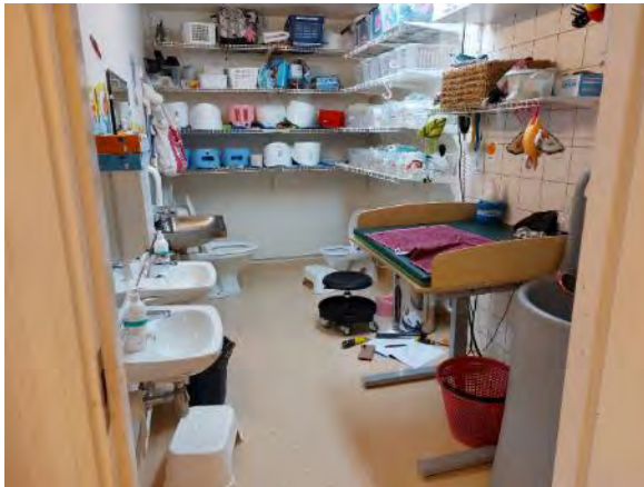
Kuva 24. WC:n vedeneristeen toteutustavan tarkastus (AP3) suoritettiin Päiväkotiryhmän Ruusunnuput wc-tilaan.
