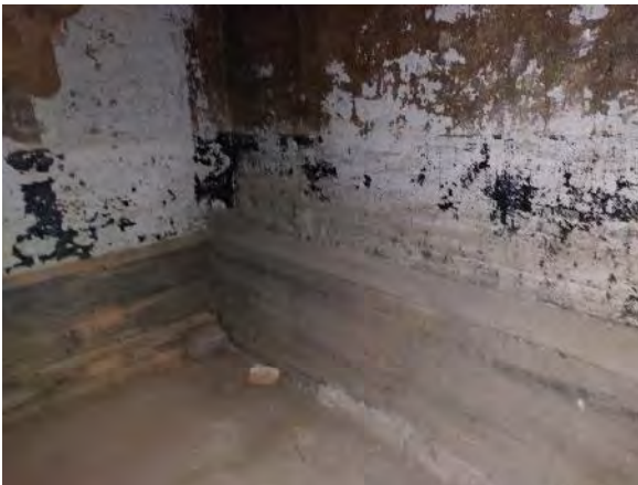
Kuva 85. Yleiskuva rakennuksen 3 kellarin alapohjasta.
