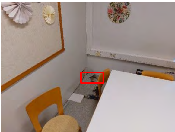
Kuva 235. Rakenneavaus VP3 tehtiin rakennuksen 3 toimistotilaan 215, kuvaan merkitylle alueelle.
