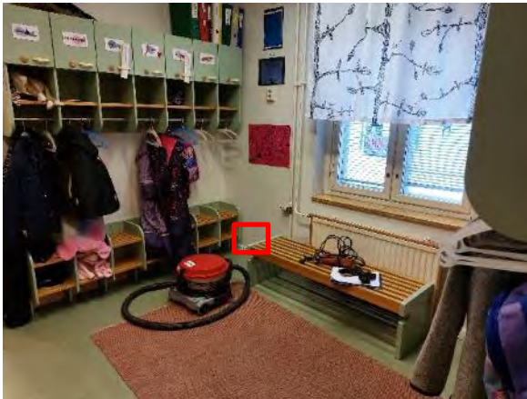
Kuva 174. Rakenneavaus US11 tehtiin rakennuksen 2 eteiseen, kuvaan merkitylle alueelle.
