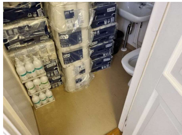
Kuva 13. WC:n ruskea muovimatto, liima tai tasoite eivät sisällä asbestia.
