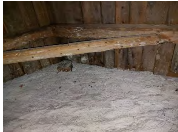
Kuva 356. Toimistotilan yläpohja on eristetty muun rakennuksen 3 yläpohjasta. Tämän tutkimuksen yhteydessä tarkastettiin ainoastaan toimiston yläpuolella oleva yläpohjatila.
