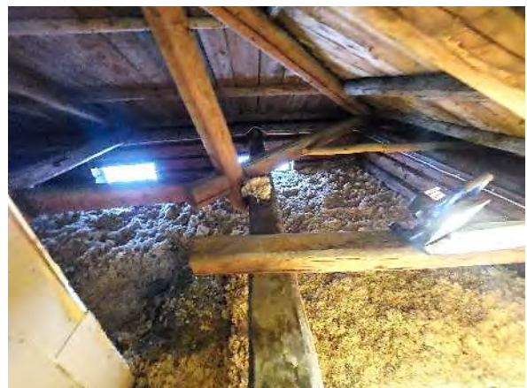
Kuva 293. Yleiskuva yläpohjasta luoteissiiven vesikattorakenteista.
