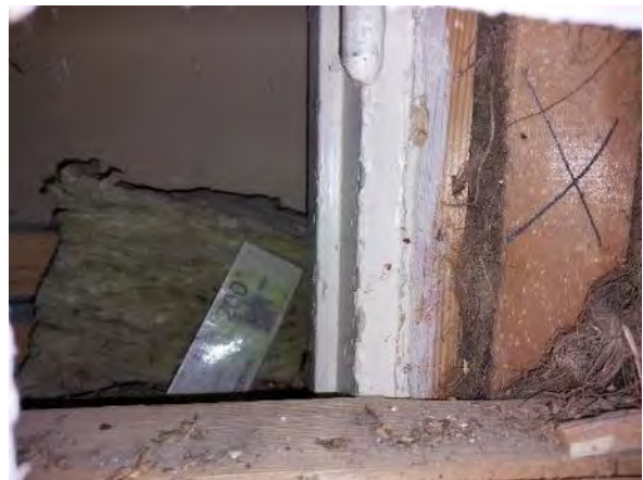
Kuva 264. Rakenneavaus VS4: Rakenneavauksesta on nähtävillä vanhan oven kohta sekä oven karmit. Karmin tilkermateriaalina on pellavarive.
