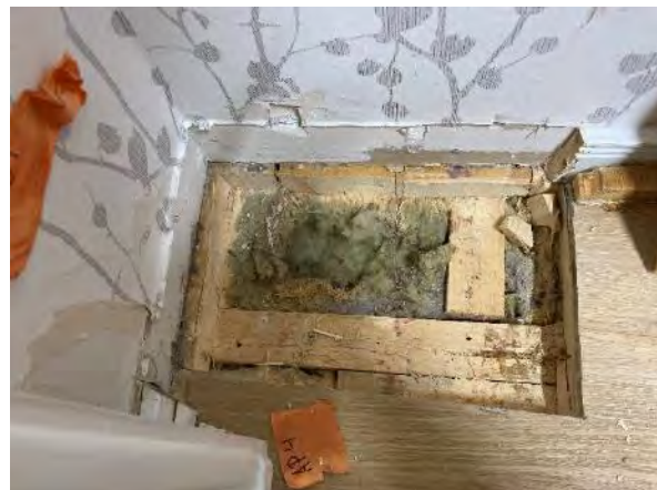
Kuva 360. Alapohjarakenteet on lisälämmöneristetty mineraalivillaeristeellä. Alapohjarakenteiden ilmatiiveys on lattialevyn tai laudoituksen varassa.
