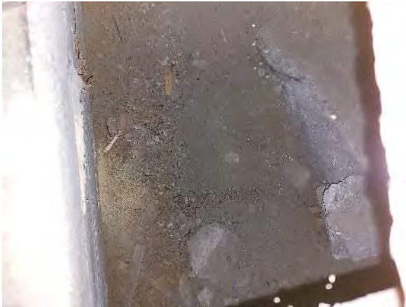
Kuva 34. Rakenneavaus AP 5: Aluslaudoituksen alapuolella havaittiin ryömintätilyä, maapohja ja betonirakenteinen sokkeli.
