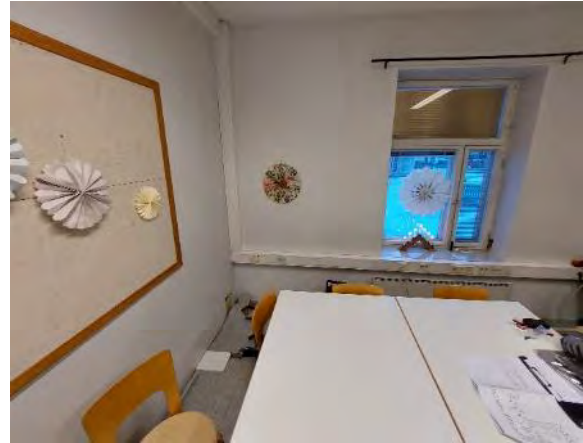
Kuva 195. Rakennuksen ulkoseinien sisäpinnat on verhoiltu kipsilevyllä.
