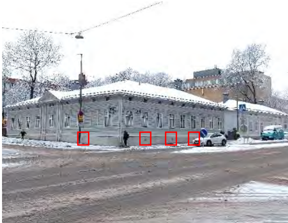
Kuva 3. Rakennuksessa 1 on alapohjan tuulettumisen mahdollistavia aukkoja kadun puolella. Kuva rakennuksesta idän suunnasta.
