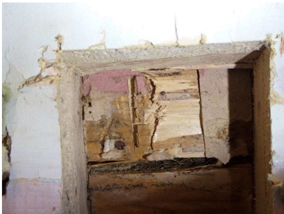
Kuva 20. Hirsiseinää vasten olevan vanhan tapetin liisteri ei sisällä asbestia.
