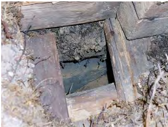
Kuva 22. Tuulettuvassa alapohjatilassa on kiviperustus. Ryömintätilan pohjalla on kiviä ja maa-ainesta.
