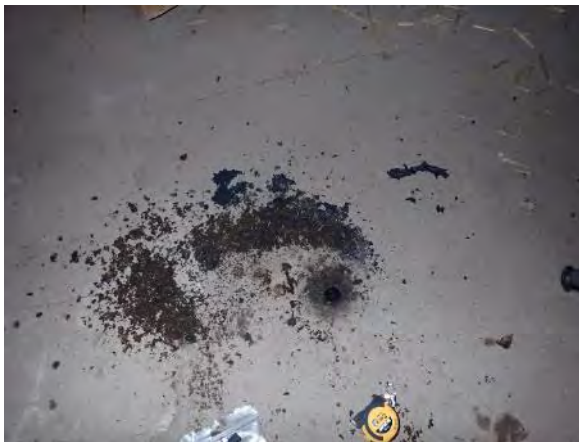
Kuva 86. Rakenneavaus AP10: Rakennuksen 3 alapohjan tarkastus tehtiin kellaritilaan.
