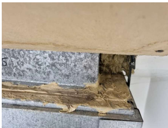
Kuva 23. IV-koneiden kellertävä saumamassa ei sisällä asbestia.
