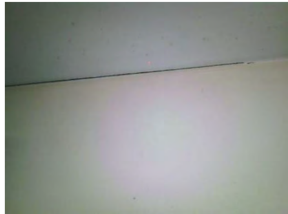
Kuva 232. Valokuva väliseinän ja -pohjan liitoksesta.
