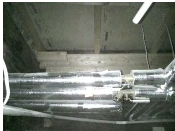
Kuva 234. Valokuva alaslaskun yläpuolisesta välipohjaliittymästä.
