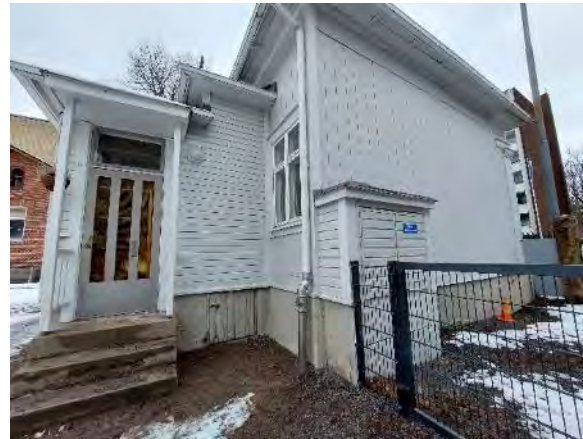
Kuva 54. Rakennuksen alapohjaan on kulkuluukku ET17 alueella.
