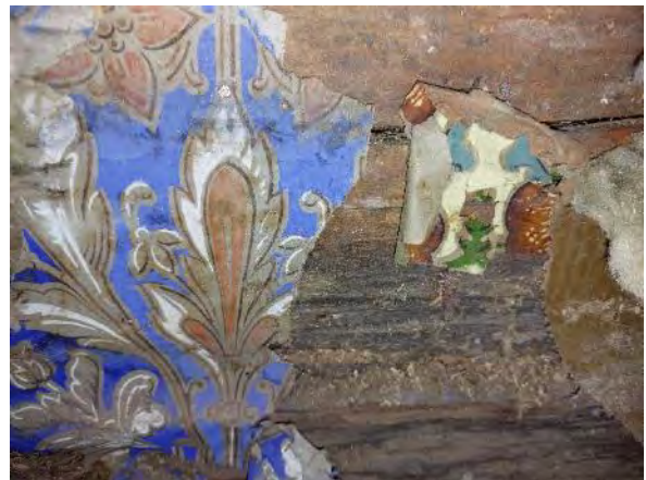
Kuva 171. Rakenneavaus US9. Hirren sisäpinnalla havaittiin tapettijäämiä.
