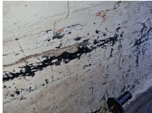
Kuva 33. Rakennuksen 3 kellarin seinien vedeneriste.
