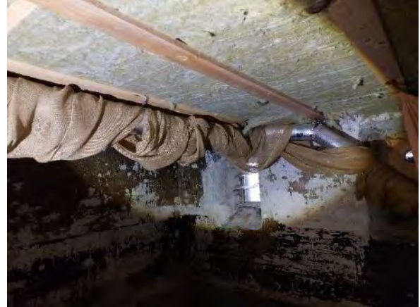
Kuva 238. Välipohjan alapinta on lämmöneristetty mineraalivillaeristein.
