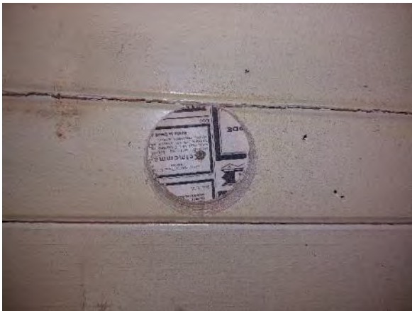
Kuva 337. Maalattun kattolaudan takana on kerros paperia.
