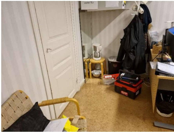
Kuva 8. Toimiston ruskea muovimatto, liima tai tasoite eivät sisällä asbestia.
