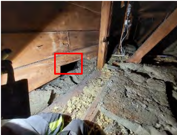
Kuva 310. Rakenneavaus YP8 tehtiin 1950-1960-luvun laajennusosaan kuvaan merkittyyn kohtaan olevan aukon kautta.
