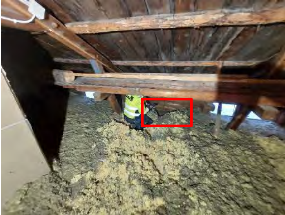
Kuva 303. Rakenneavaus YP2: tehtiin ulkoseinän vierustalle, kuvaan merkitylle alueelle.
