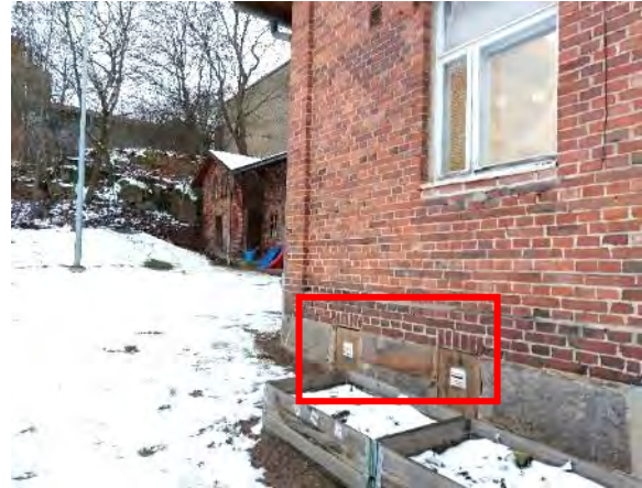
Kuva 84. Rakennuksen 3 sokkelissa on kellarin tuulettumisen mahdollistavat aukot vanhojen ikkunoiden kohdissa.
