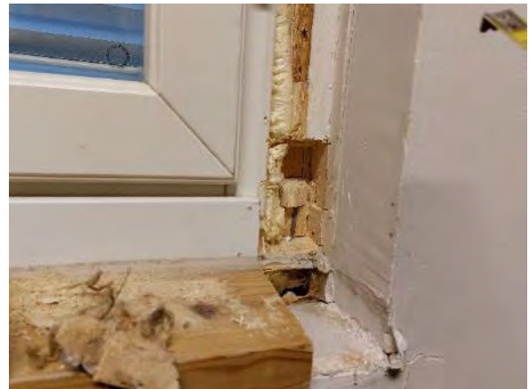
Kuva 144. Rakenneavaus IKK1: Uusittu ikkuna on asennettu vanhojen karmien päälle.
