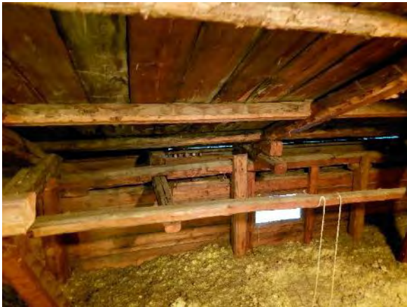
Kuva 290. Lounaissiiven alueella räystäiden ilmaroot ovat niukat.
