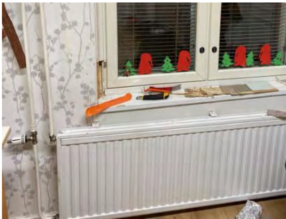
Kuva 146. Rakenneavaus IKK2. Rakennuksen ikkunat ovat uusittuja.
