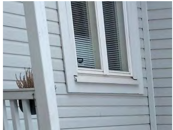
Kuva 161. Rakennuksessa 2 ikkunapellityksillä on rakennuksen 1 tapaan suojattu puurakenteinen ikkunalaista.
