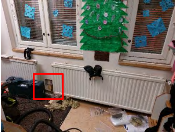
Kuva 122. Rakenneavaus US3 tehtiin päiväkotiryhmän Sinikellot eteiseen kuvaan merkitylle alueelle.
