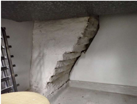
Kuva 18. Rakennuksen 1 2. kerroksen IV-konehuoneen hormin rappaus ja maali eivät sisällä asbestia.
