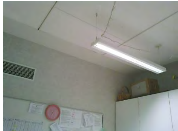
Kuva 253. Valokuva yläpohjarakenteen liitoksesta ryhmätilasta 26.2.
