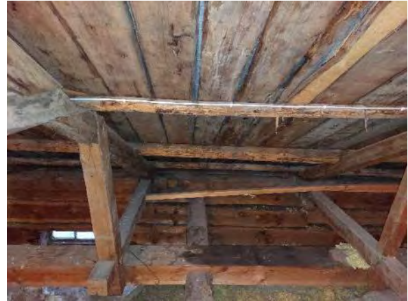
Kuva 332. Vesikattorakenteet tukeutuvat hirsikehikkoon.
