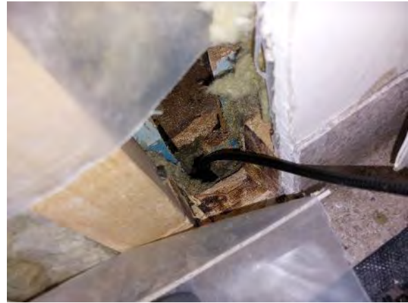
Kuva 127. Tyhjää tilaa tutkittiin endoskoopin avulla.
