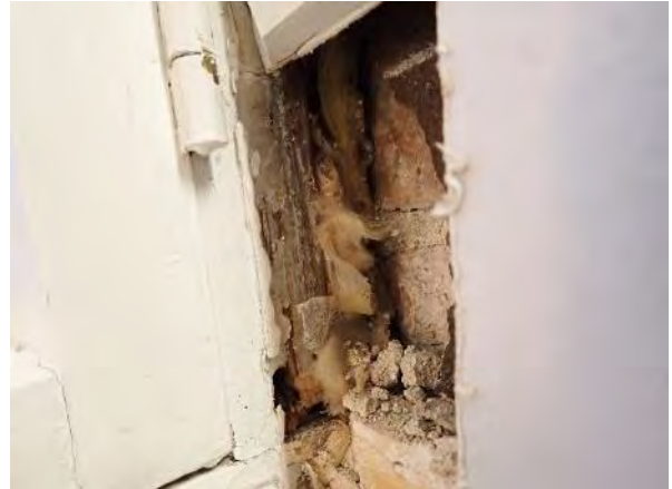
Kuva 202. Rakenneavaus IKK4: Karmin ja ulkoseinän liitoksessa on eristeenä mineraalivillaeriste.
