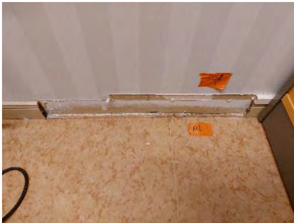
Kuva 13. Rakenneavaus AP 1: Tehtiin päiväkodin toimiston alueelle, päiväkodin johtajan huoneeseen.
