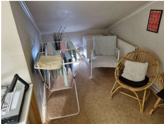
Kuva 10. Taukotilan ruskea muovimatto, liima tai tasoite eivät sisällä asbestia.
