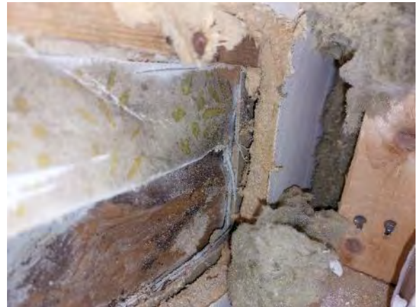
Kuva 164. Rakenneavaus US8. Ulkoseinässä on sisäpuolinen lisälämmöneriste. Puukuitulevyn takana on pinkopahvi ja tapettikerroksia
