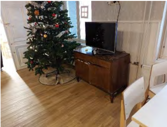
Kuva 9. Paikoin rakennuksen 1 ryhmätilojen lattiapäällysteenä on vinyylipäällyste.
