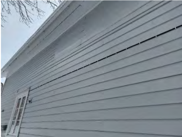
Kuva 282. Valokuva rakennuksen ulkopuolelta, lisätuen kohdalta rakennuksen lounaan puoleisella julkisivulla.
