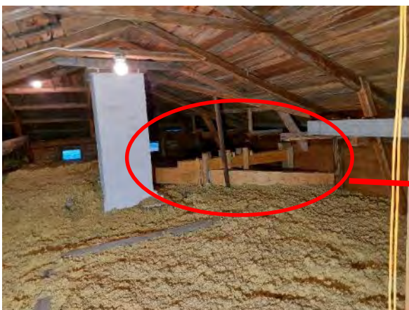
Kuva 280. Yleiskuva lounaissiiven yläpohjasta. Yläpohja on lisälämmöneristetty puhallusvillalla.
