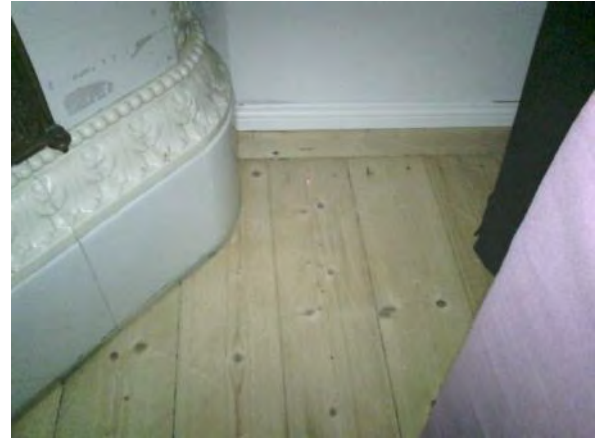
Kuva 48. Tulisijan ja alapohjan liitos.
