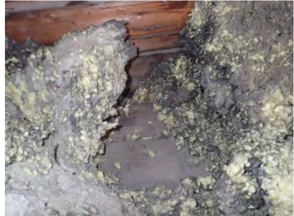
Kuva 304. Rakenneavaus YP2, lisälämmöneristeenä on puhallusvillaa sekä mineraalivillaa.
