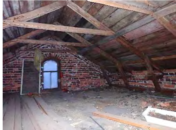
Kuva 354. Yleiskuva yläpohjasta. Vesikattorakenteet ovat puurakenteisia.
