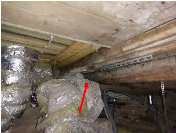
Kuva 258. Yleiskuva rakennuksen 2 alapohjasta. Kuvassa oikealla väliseinän tuentaa eteisen ja jakelukeitin väliseinän alapuolelta.
