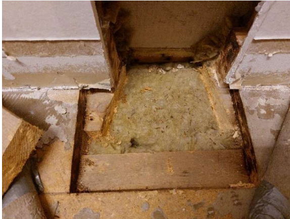
Kuva 28. Rakennuksessa 1 US1 rakenne toimistosta.
