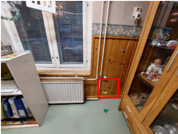
Kuva 163. Rakenneavaus US8 tehtiin rakennuksen 3 pienoiskeittiöön kuvaan merkitylle alueelle.
