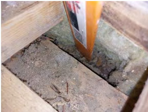
Kuva 38. Rakenneavaus AP 6: Alapohjarakenteen lisälämmöneristeenä on mineraalivillaeriste. Eristeen alapuolella on hiekkatäyttö.
