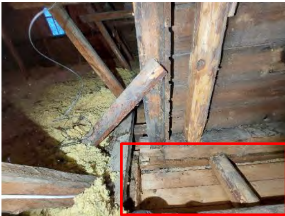
Kuva 308. Rakenneavaus YP3: Ruusunnuppujen eteistilan yläpuolelle.
