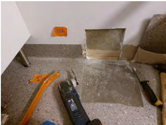
Kuva 18. Rakenneavaus AP 2: Rakenneavaus tehtiin alapohjan ja ulkoseinän liitokseen rakennuksen lounaissiipeen.
