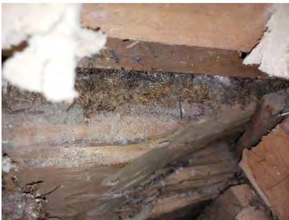
Kuva 117. Hirsien tilkkeenä on käytetty havaintojen perusteella sammalta.
