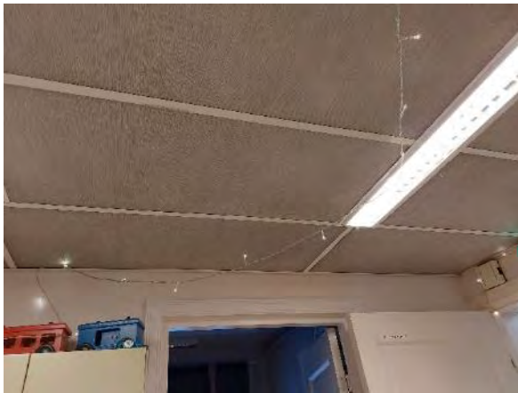
Kuva 208. Paikon välipohjan alakatto on laskettu ja sisäkaton pinta on levytetty mineraalivillaisilla alakattolevyillä.
