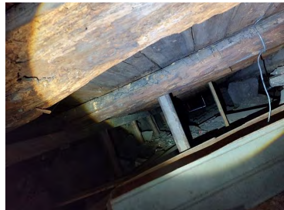
Kuva 6. Yleiskuva rakennuksen 1 ryömintätilasta. Luoteen puoleinen siipi.
