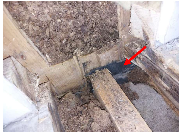
Kuva 35. Rakennuksen 3 toimiston ja kellarin välisen välipohjan tervapaperi.
