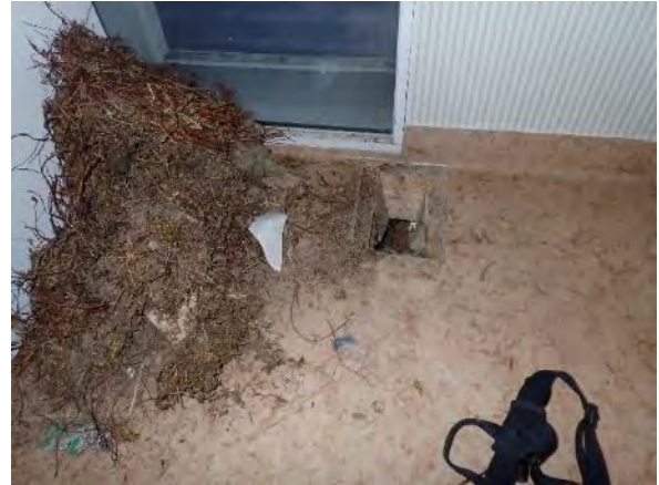
Kuva 219. Rakenneavaus VP2: Välipohjan lämmöneristeenä on käytetty mineraalivillaa hiekkaa ja sammal/metsänpohjajuurakkoa.
