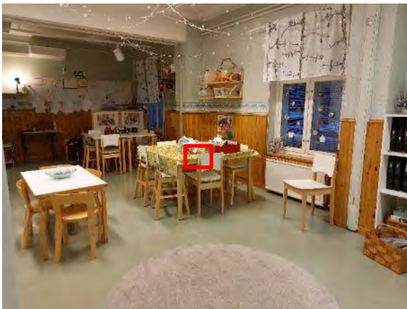
Kuva 170. Rakenneavaus US9 tehtiin rakennuksen 2 monitoimitilaan 5, kuvaan merkitylle alueelle.
