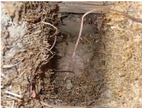
Kuva 302. Yleiskuva rakenneavaus YP1.
