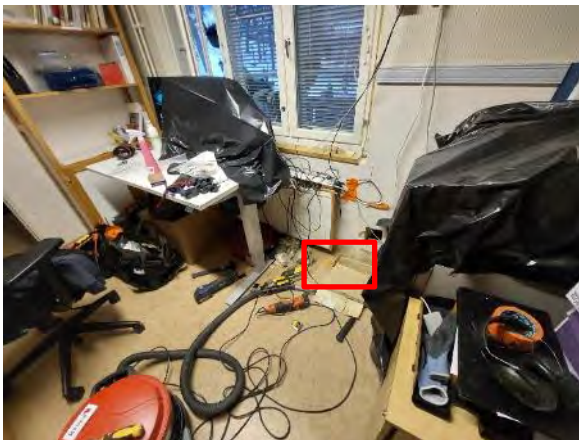
Kuva 30. Rakenneavaus AP 5 tehtiin toimistotilaan, kuistin laajennusosaan, kuvaan merkitylle alueelle.
