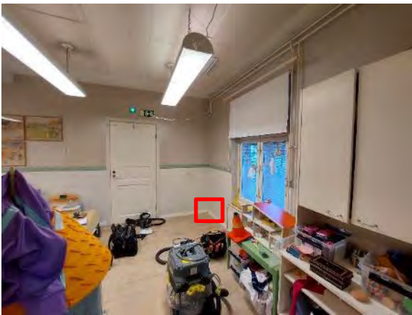
Kuva 167. Rakenneavaus US10 tehtiin rakennuksen 2 ryhmähuoneeseen 2, kuvaan merkitylle alueelle.
