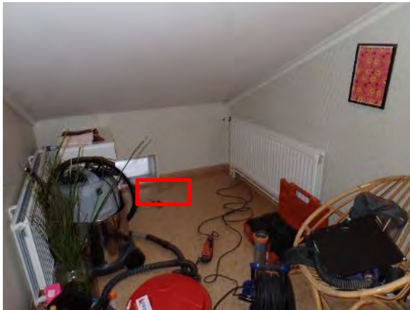
Kuva 216. Rakenneavaus VP1 tehtiin rakennuksen 1 2.kerros aulatilán syvennykseen, kuvaan merkitylle alueelle.
