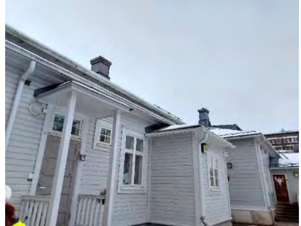
Kuva 159. Puuverhoiltujen julkisivujen maalipinnat ovat tarkastetuina osin hyväkuntoisia.
