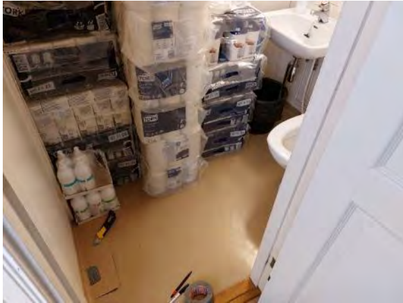
Kuva 206. Välipohjan sosiaali- ja wc-tilojen päällysteenä on muovimatto.
