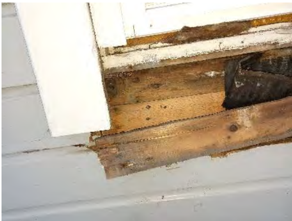
Kuva 110. US1: Rakenne tarkastettiin ikkunan alapuolelta rakennuksen ulkopuolelta.
