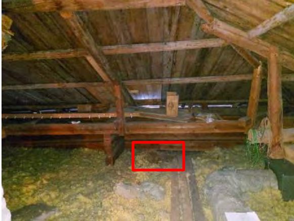
Kuva 333. Rakenneavaus YP4: tehtiin ulkoseinän vierustalle, kuvaan merkitylle alueelle.
