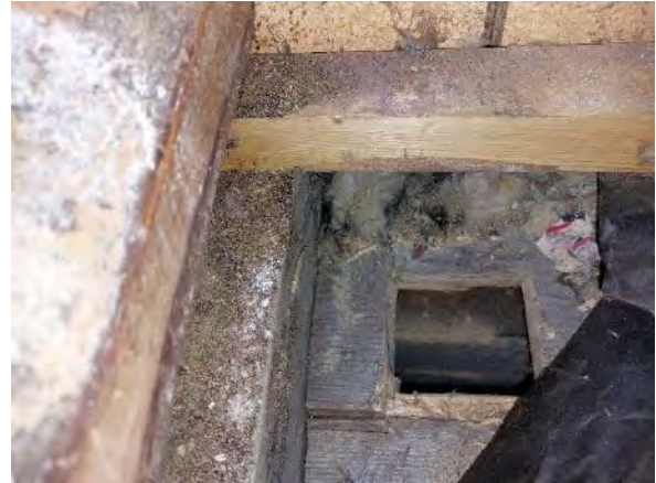
Kuva 33. Aluslaudoituksessa ei havaittu lahovauriota avauskohdassa.
