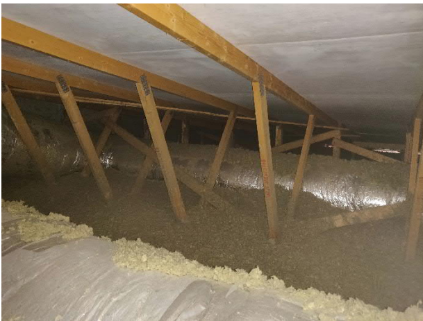
Kuva 187. Yläpohja tuulettui hyvin.
