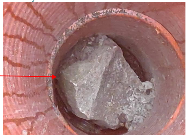
Kuva 14. Luoteisnurkan salaojakaivon pohjalta havaittiin suuri kivi.
