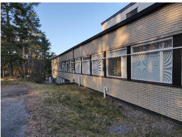
Kuva 7. C-sivun julkisivu väestönsuojan kohdalta.
