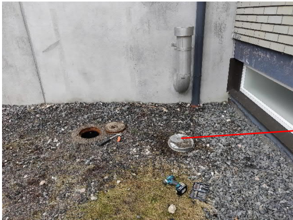
Kuva 15. Salaojakaivot laajennusosan ja alkuperäisen osan liittymäkohdassa.
