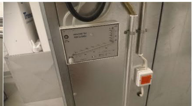
Kuva 201 TK3 on varustettu liuos-LTO:lla. TK3/pf1:n ilmavirtauksen ilmoittava manometri on rikki.
