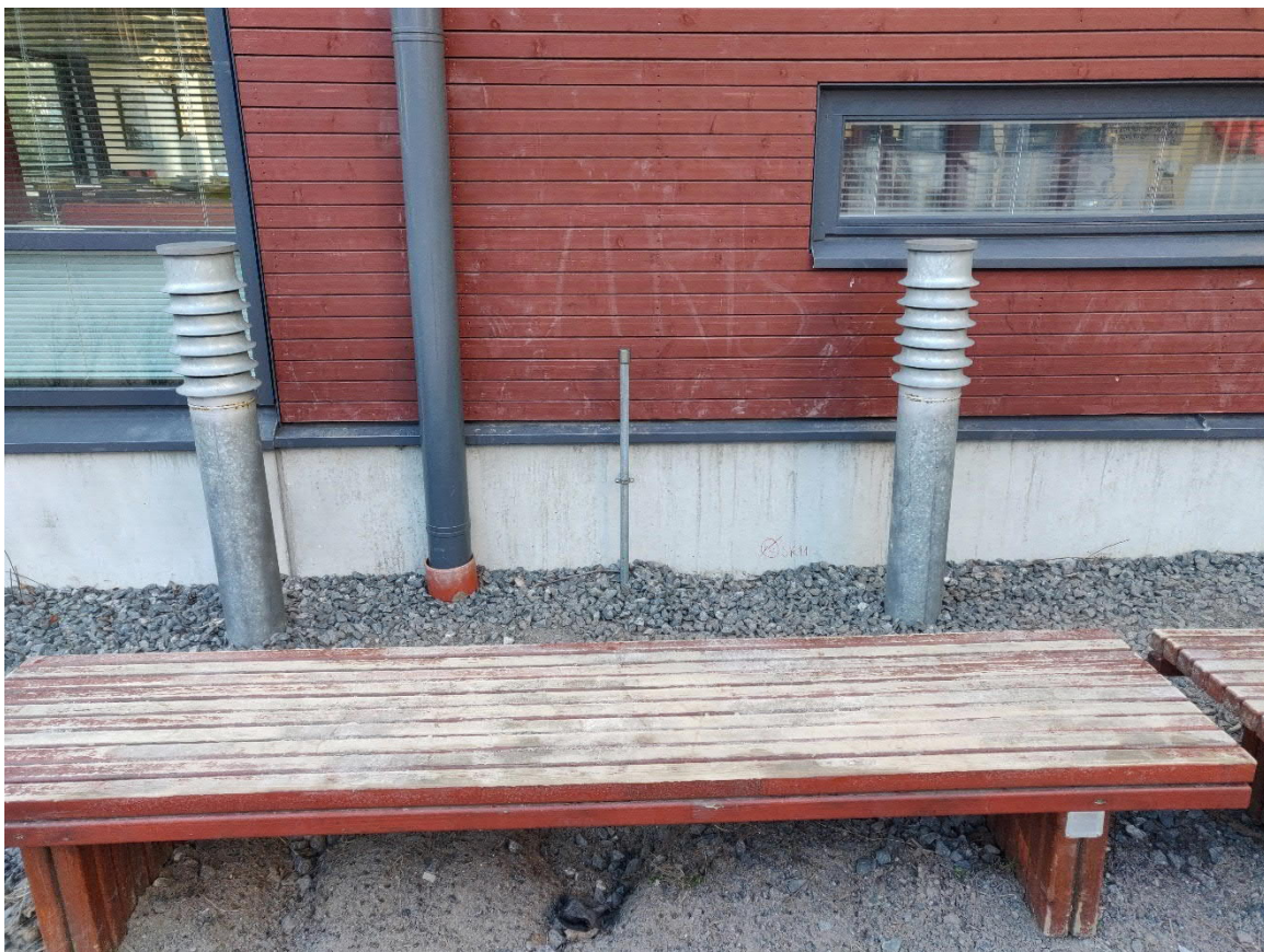
Kuva 134. Katolta tulevat sadevedet ohjataan suoraan sadevesijärjestelmään.
