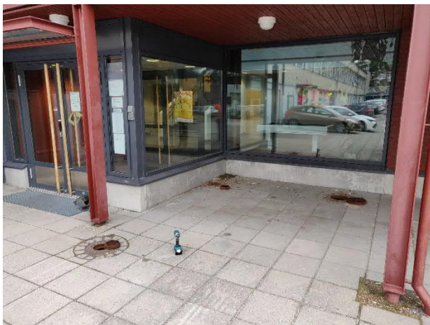
Kuva 132. Salaojan tarkastuskaivoja oli rakennuksen nurkissa.
