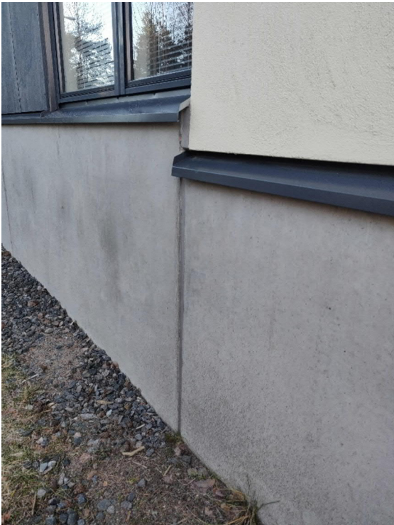
Kuva 142. Sokkelielementit olivat hyväkuntoisia. Sauraukset olivat ehjät.
