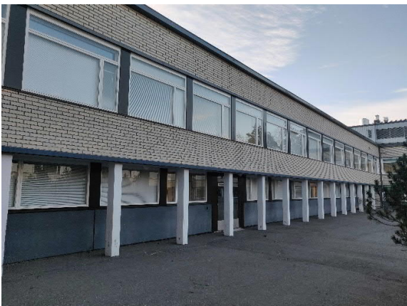
Kuva 5. Sisäpiha, B-sivun julkisivu
