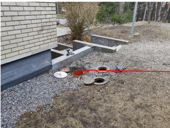
Kuva 13. Salaojan ja sadeveden tarkastuskaivot rakennuksen pohjoisnurkalla.
