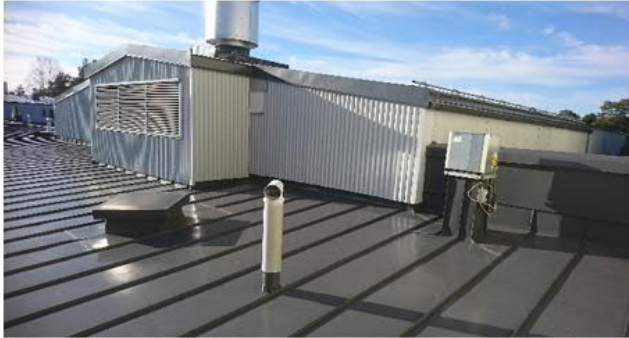
Kuva 199. TK3:n ulkoilmasäleikön korkeus katto pinnasta todettiin riittäväksi. Noin 7 metrin etäisyydellä säleiköstä havaittiin suunnitelmista poikkeavasti sijoitettu viemärintuuletusputki.
