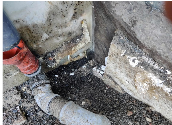
Kuva 12. Koekuoppa KK1 laajennusosan ja alkuperäisen osan liittymäkohdassa.
