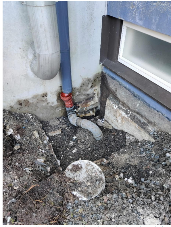
Kuva 128. Koekuoppa vanhan ja uuden puolen yhdys- kohdassa. Kuopasta havaittiin laajennusosan vierus- talla olevan suunnitelmien mukaisesti salaojasora pystysalaojakerroksessa.
