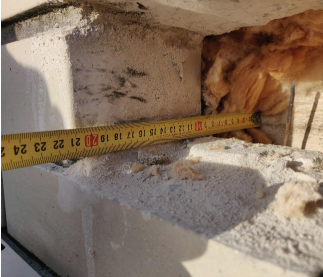
Kuva 96. Julkisivuverhouksen takana ei ole tuuletusrakoa.
