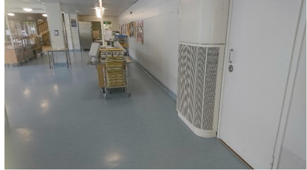
Kuva 204 Ruokasalissa ilmanjako on toteutettu syrjäyttävänä ilmanvaihtona.
