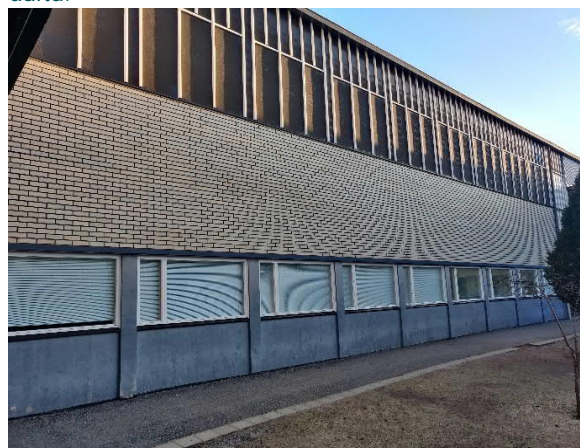
Kuva 8. A-sivun julkisivu sisäpihalla liikuntasalin kohdalta.
