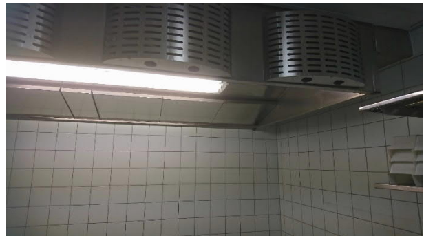
Kuva 206 Ruokalan ilmanvaihtolaite todettiin aistinvaraisesti pinnoilta puhtaiksi.
