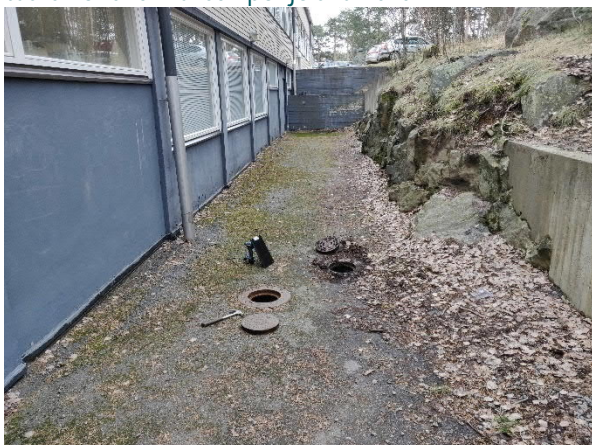
Kuva 22. Sadeveden tarkastuskaivo rakennuksen lounais-sivustalla.
