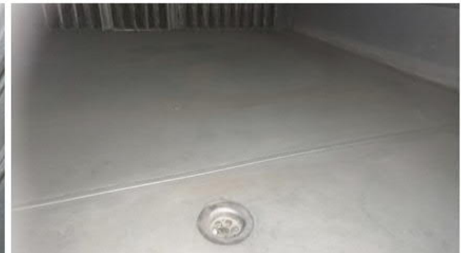
Kuva 200. Ulkoilmakammion kulmissa havaittiin orgaanisia epäpuhtauksia, mutta suunnitelmien mukaista kuivakaivoa ei kuvauksessa havaittu. Suodattimia edeltävä koneen osa oli sen sijaan viemäröity.
