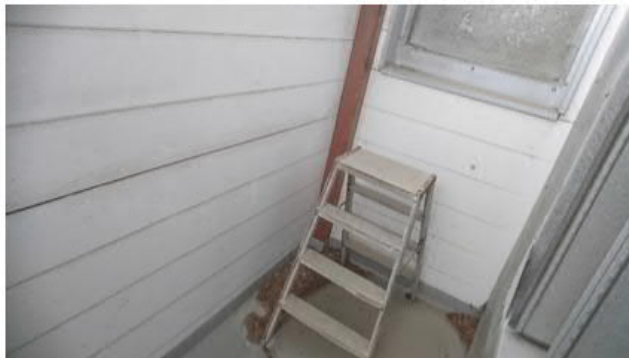
Kuva 200. Ulkoilmakammion kulmissa havaittiin orgaanisia epäpuhtauksia, mutta suunnitelmien mukaista kuivakaivoa ei kuvauksessa havaittu. Suodattimia edeltävä koneen osa oli sen sijaan viemäröity.
