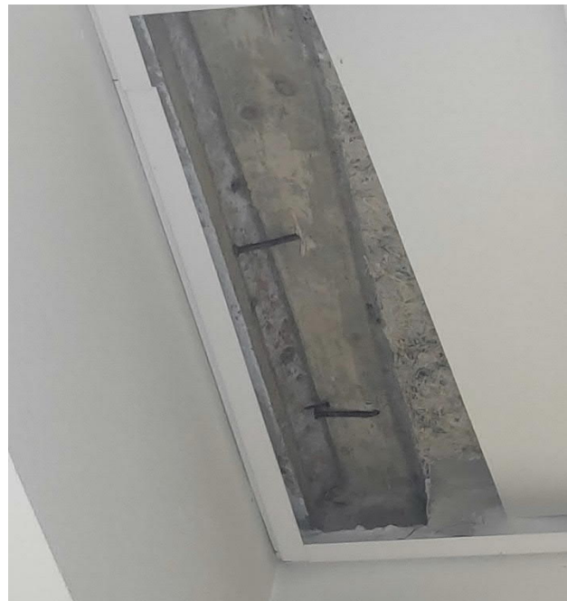
Kuva 120. Alakaton yläpuolelta havaittiin vanhoja muottilautoja sekä alkuperäisiä lastuvillasementtilevyjä.
