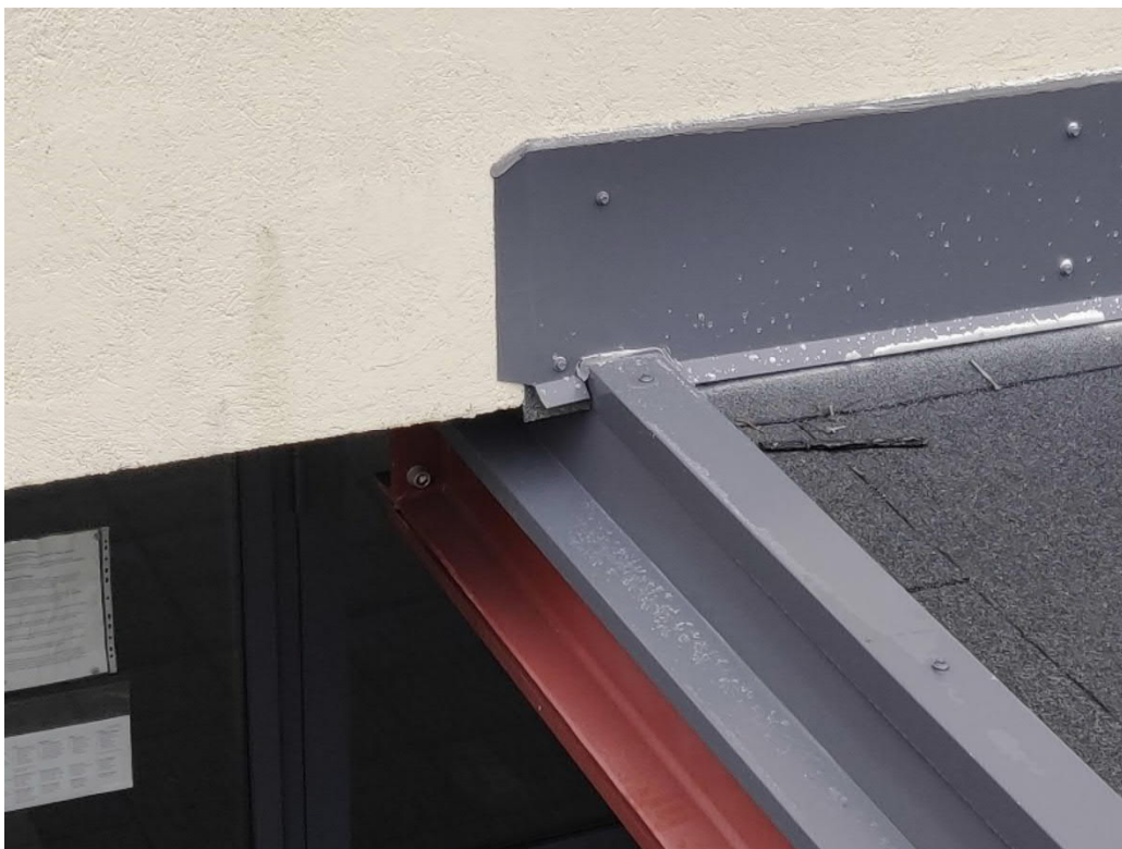
Kuva 179. Katoksen liitos ulkoseinärakenteeseen.
