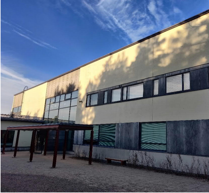
Kuva 170. Julkisivut ovat suurelta osin rapattuja. Osa pinnoista on myös levytetty.
