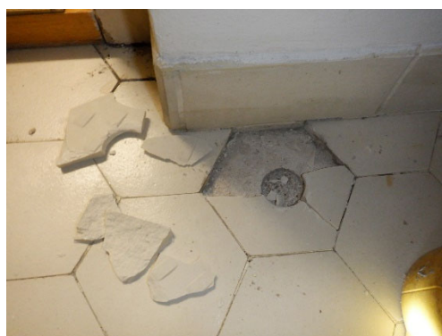
Kuva 3.2.3 1. krs. WC-tila, lattiaan rakenteen avaus.
