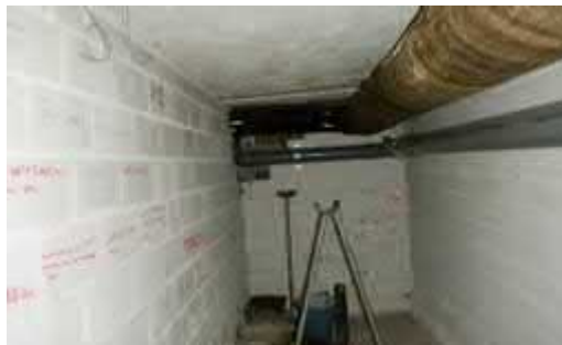
Kuva 6.6.14. Putkitunnelin pääty rakennuksen I-osan alapuolella.
