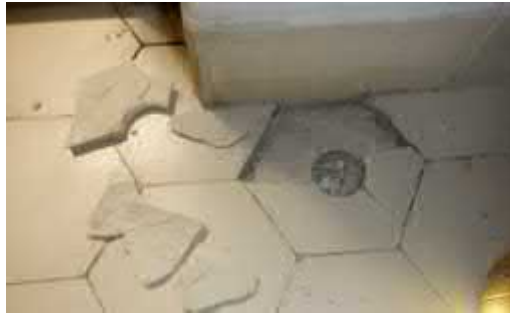
Kuva 6.1.7. AP-rakenteen tarkastus \varnothing 32 mm WC-/kylpyhuonetilassa.
