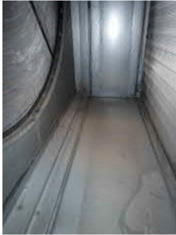
Kuva 7.1.16. Tuloilmakone TK6 oli sisältä puhdas.
