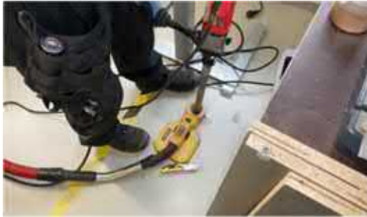
Kuva 6.1.4. AP-rakenteen tarkastusporaus \varnothing 32 mm metallityöluokassa.
