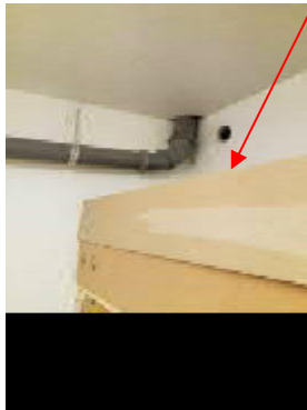
Kuva 6.1.28. Luoteispäädyn sokkelissa, maanpinnan tasolla on painovoimaisia kanavistoja, joista kulkeutuu ulkoilmaa suodattamattomana ensimmäisen kerroksen varastotiloihin.
