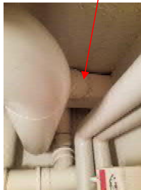
Kuva 6.1.28. Luoteispäädyn sokkelissa, maanpinnan tasolla on painovoimaisia kanavistoja, joista kulkeutuu ulkoilmaa suodattamattomana ensimmäisen kerroksen varastotiloihin.
