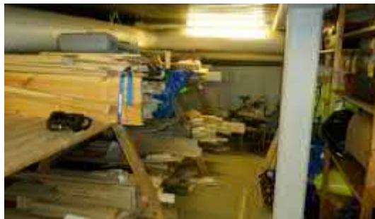
Kuva 5.1.2. Yleiskuvaa alempaan kellarikerrokseen. Kattopintana teräsprofiililevy (liittolaatta).
