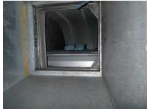
Kuva 7.1.10. Tuloilmarunkokanavistossa ei ollut merkittävästi pölyä.
