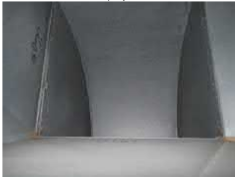
Kuva 7.1.6. Tuloilmarunkokanavistossa ei ollut merkittävästi pölyä.
