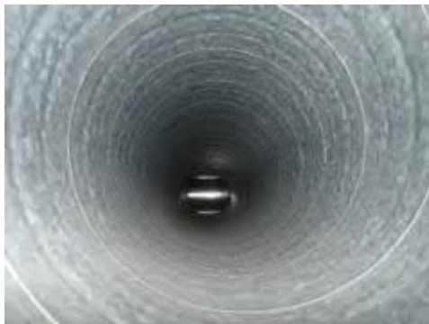
Kuva 7.1.11. Tuloilmakanavistossakaan (tila 302) ei ollut merkittävästi pölyä.
