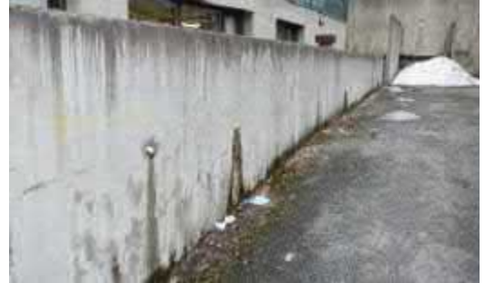
Kuva 6.1.19. Kalliroleikkauksen sulkutilan ja perusmuurin välistä tukimuuria.
