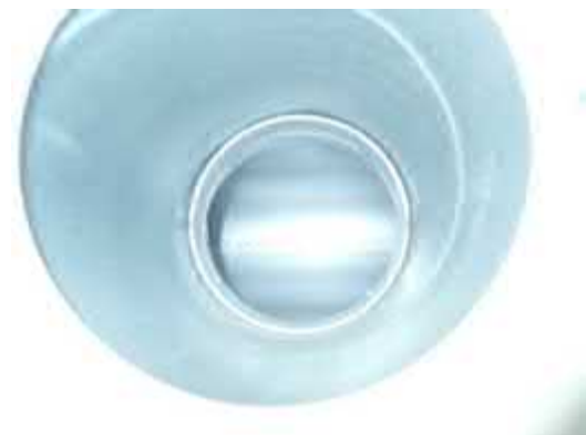
Kuva 7.1.21. Tuloilmakanavistossa (tila 141) ei ollut merkittävästi pölyä.
