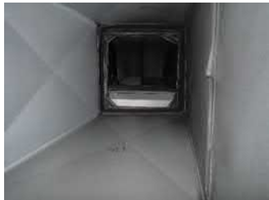
Kuva 7.1.8. Tuloilmarunkokanavistossa ei ollut merkittävästi pölyä.
