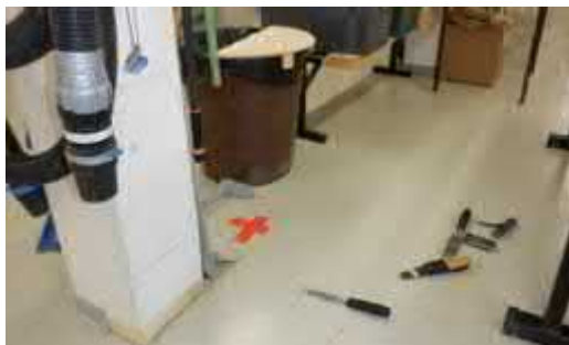
Kuva 6.1.13. Peltikoteloitu teräspilari teknisen työn luokkatilassa. Alapohjaliittymän tarkastus.
