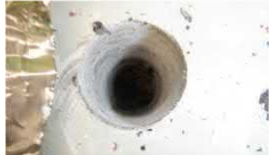
Kuva 6.1.5. AP-rakenteessa ei ollut eristetilaa, eikä orgaanista materiaalia.
