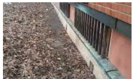
Kuva 6.1.17. Luoteispäädyn alueella maanpinta viettää rakennukseen päin. Tuuletuskanavien ritilät ovat maanpinnan tasolla.
