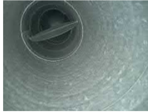
Kuva 7.1.19. Tuloilmakanavistossa (tila 319) ei ollut merkittävästi pölyä.
