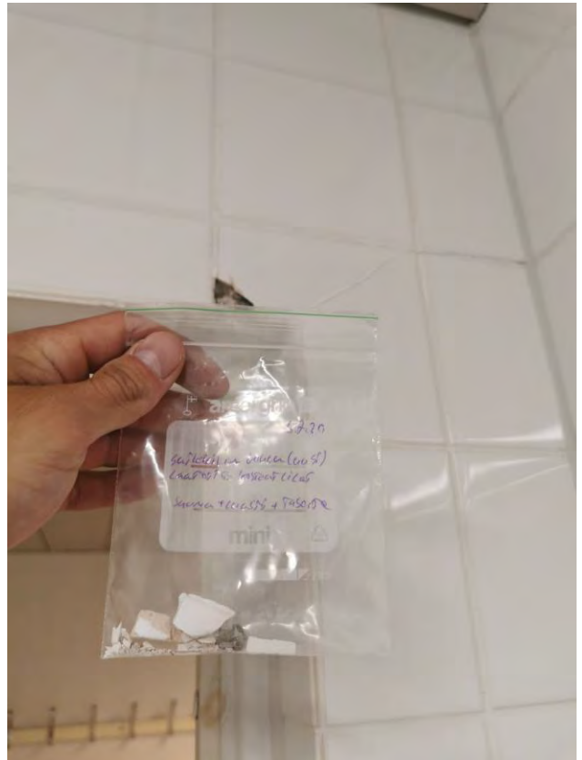
Kuva kosteantilan laatoituksen näytteen otosta.
