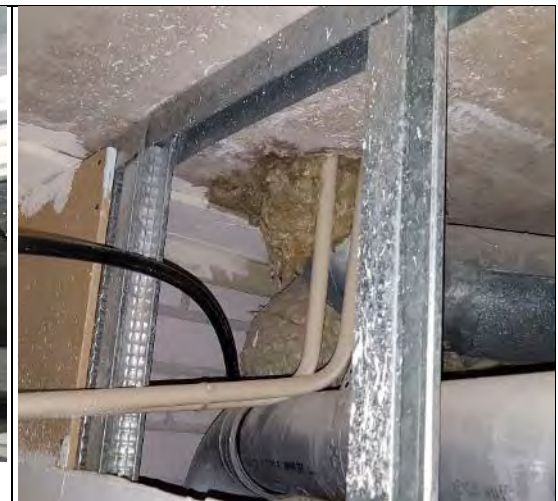
Kuva 5.73. Alakattojen päällä on erittäin runsaasti pölyä ja kuitulähteitä äänenvaimennuspusseissa.
