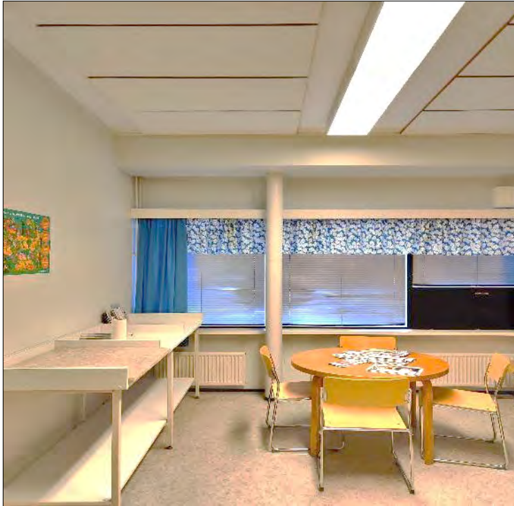
Kuva 5.75. Terveydenhoitajan tilojen katossa on reunoiltaan pinnoittamattomia akustiikkalevyjä.
