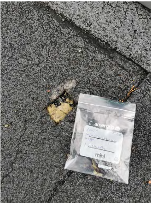
Kuva rakennuksen katon näytteen otosta.
