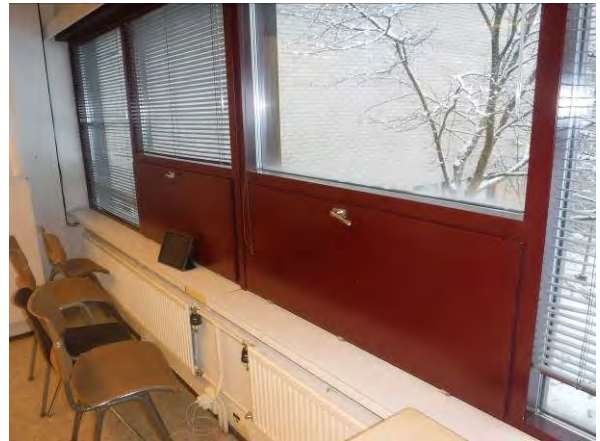
Ikkunaa, jossa on tuuletusluukut
