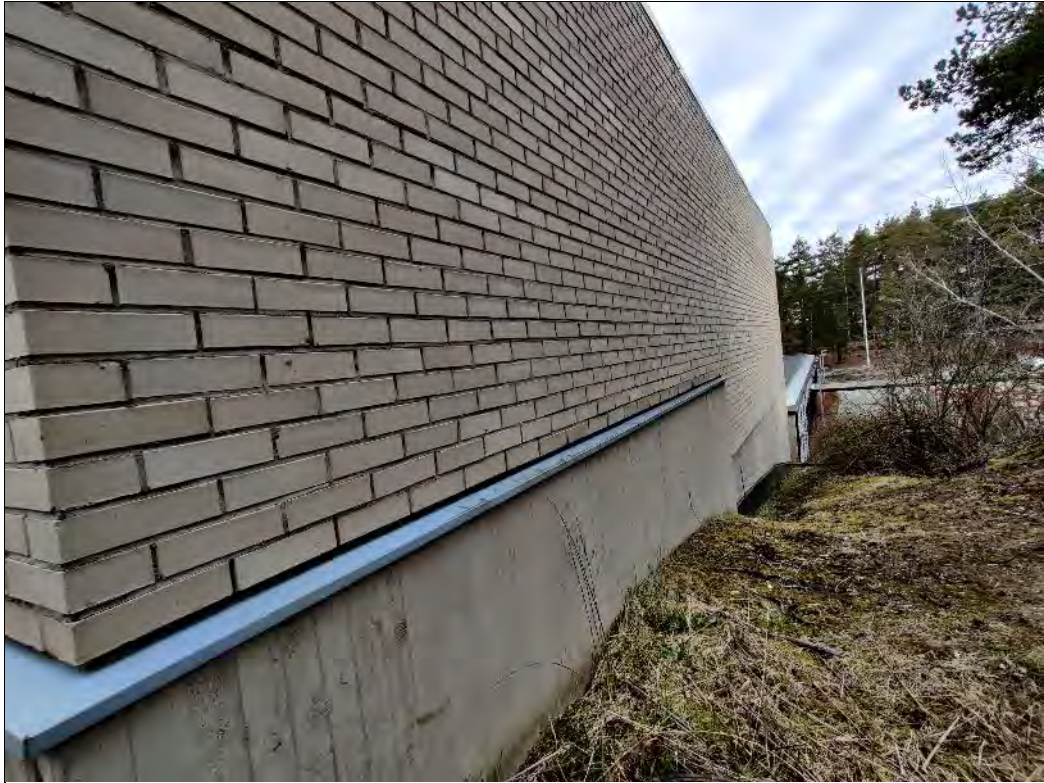
Kuva 5.2. Liikuntasalin julkisivuissa ei ole näkyviä kosteusrasituksen merkkejä (kuva liikuntasalin itäisivulta).
