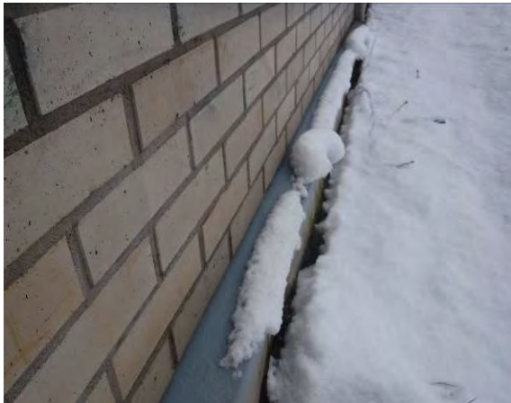
Liikuntahallin sokkeliä ylärinteen puolella; sokkelin yläpinnassa suojapelti
