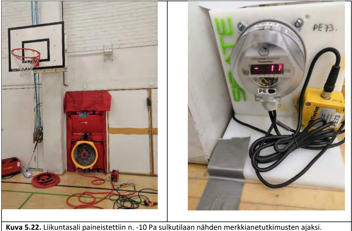
Kuva 5.22. Liikuntasali paineistettiin n. -10 Pa sulkutilaan nähden merkkianetutkimusten ajaksi.
