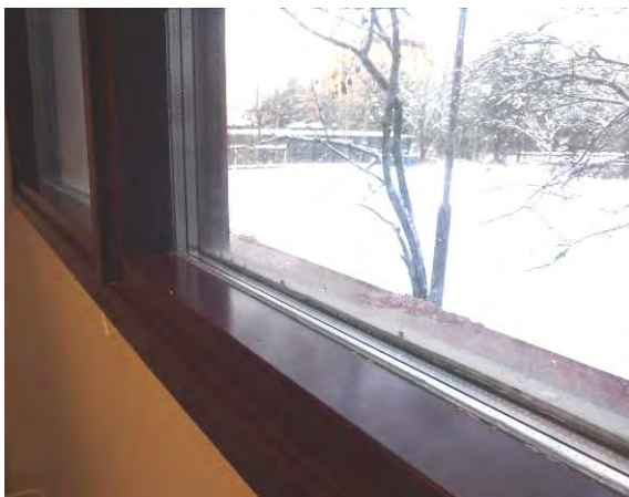
Ikkunoissa on lämpölasielementit
