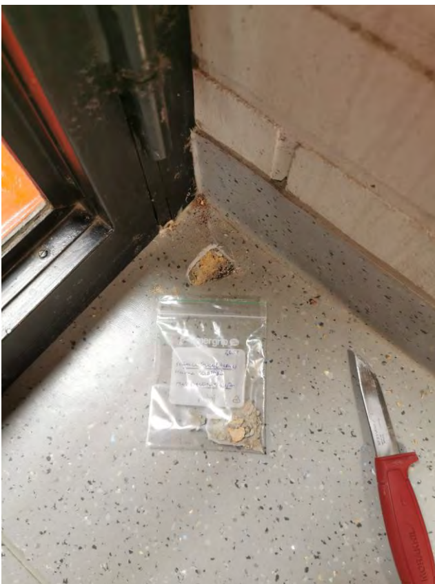
Kuva käytävän lattian näytteen otosta.
