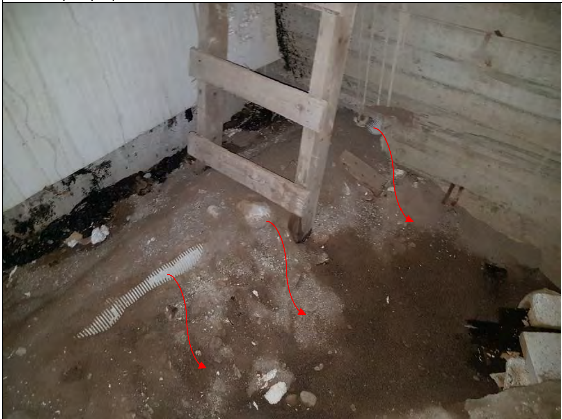
Kuva 5.23. Sulkutilasta on merkittäviä ilmavuotoja liikuntasaumoista sekä pilariliittymistä (kuva liikuntasalin itäpäädyssä).
