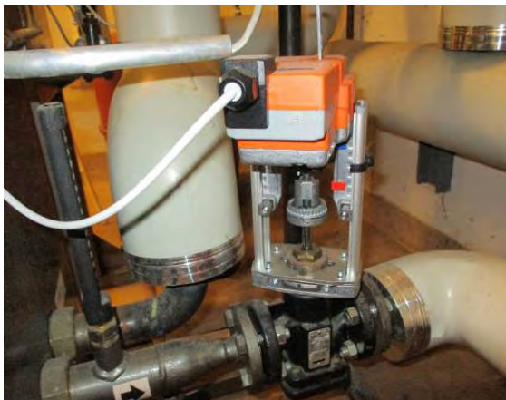
Lämmönjakokeskuksen toimilaitteita on uusittu
