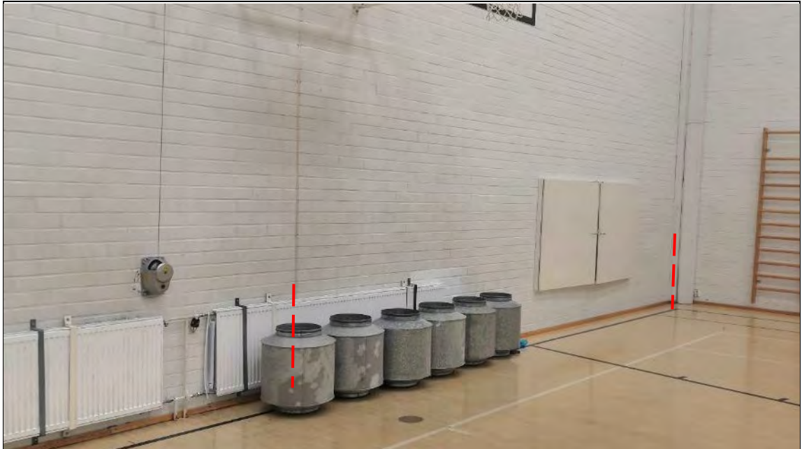
Kuva 5.23. Sulkutilasta on merkittäviä ilmavuotoja liikuntasaumoista sekä pilariliittymistä (kuva liikuntasalin itäpäädyssä).
