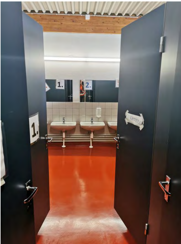
Yleiskuva kohteen alkuperäisestä wc tilasta.
