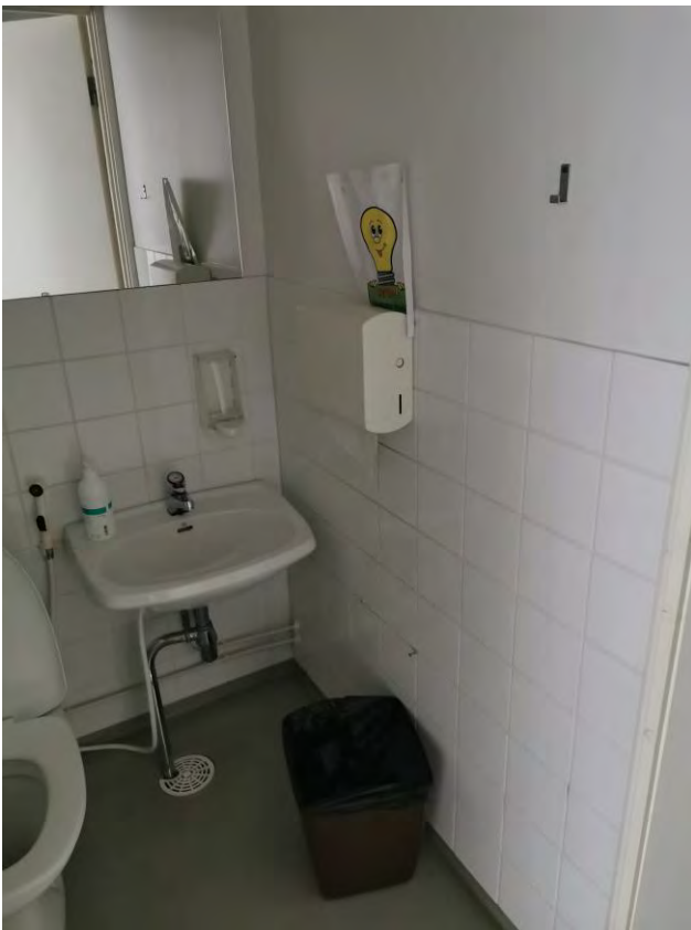
Yleiskuva kohteen wc:n laatoituksista.
