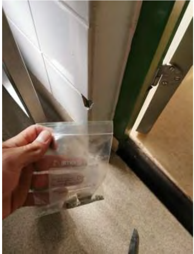
Kuva keittiön seinän näytteenotosta.
