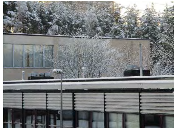
Vesikatolla on tarpeenmukaiset kohdepoistot
