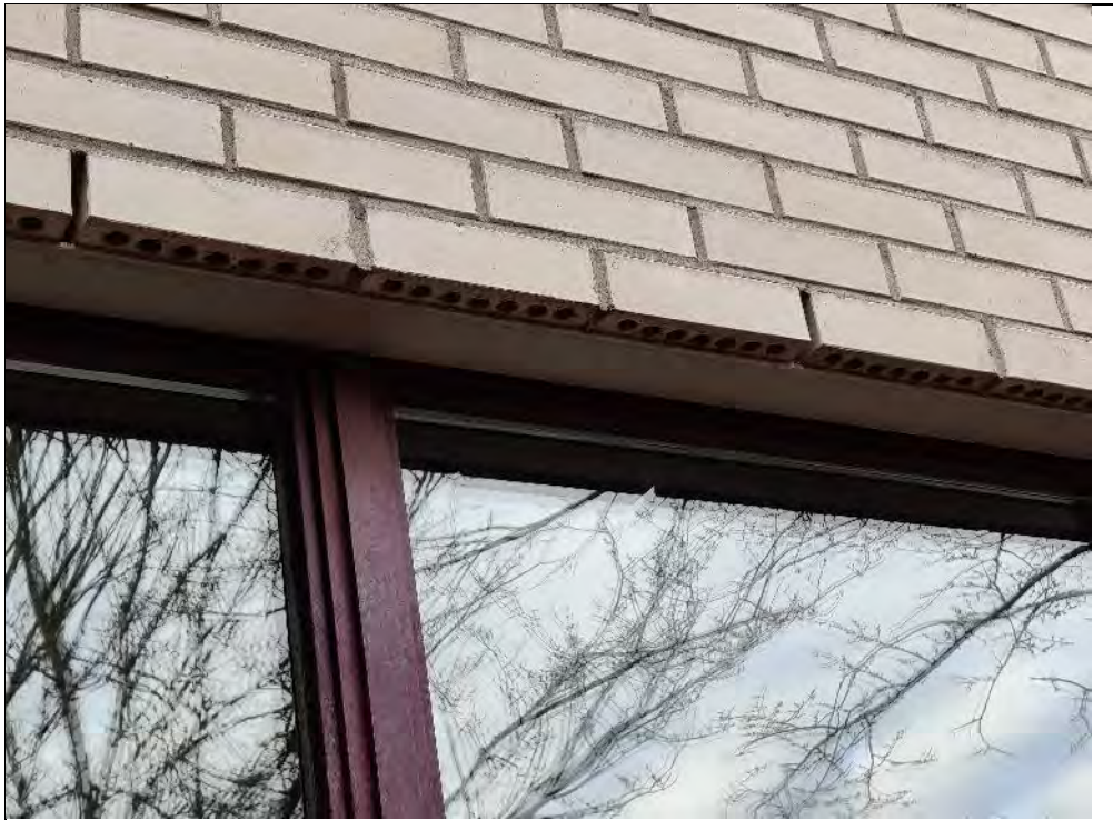
Kuva 5.1. Liikuntasalin julkisivuissa on tuuletusraot.
