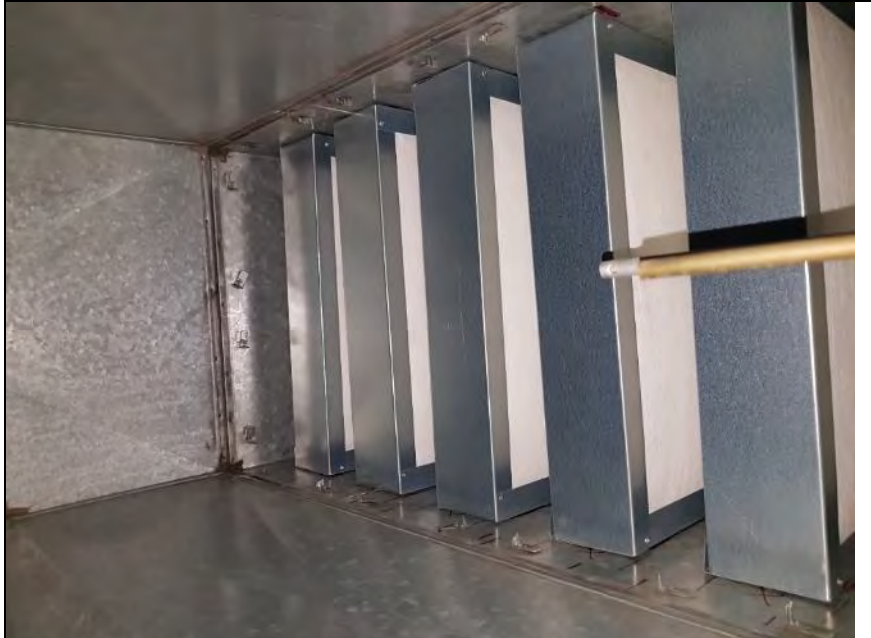
Kuva 5.76. IV-koneen TK2 ääniloukut on uusittu materiaalilla, joista ei irtoa mineraalikuituja.
