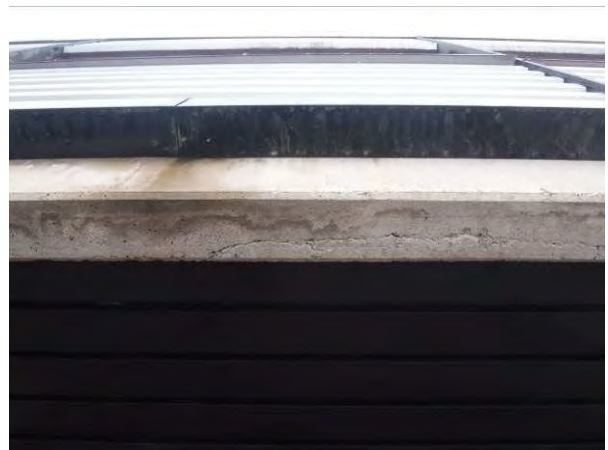
Betonipalkkia alhaalta kuvattuna
