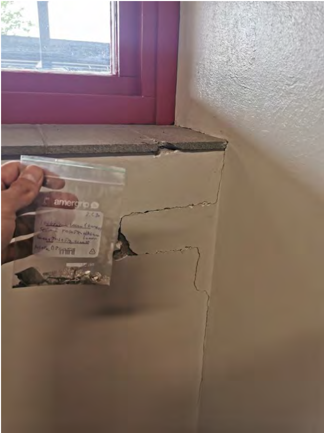
Kuva ikkunapenkin näytteen otosta.
