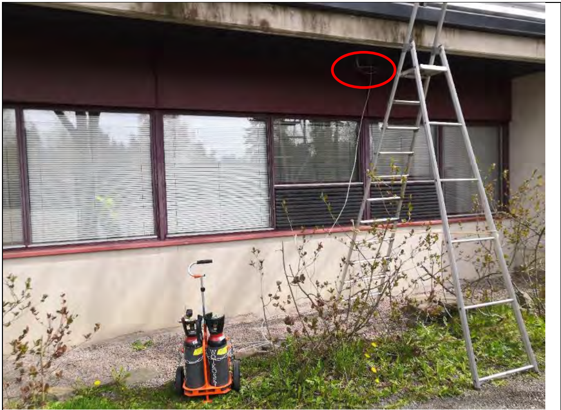
Kuva 5.51. Merkkiaine laskettiin ulkoilmaa vasten olevan välipohjan alle.
