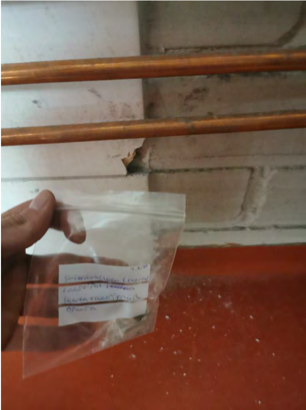
Kuva kohteen vaalean laatoituksen näytteestä.
