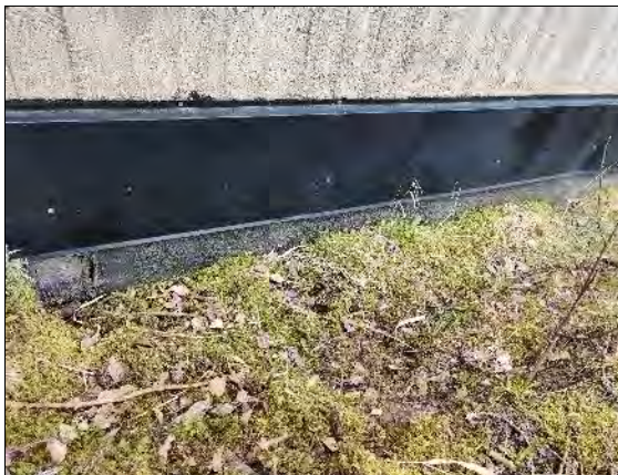
Kuva 5.3. Itäisivun sokkeliä on korjattu.
