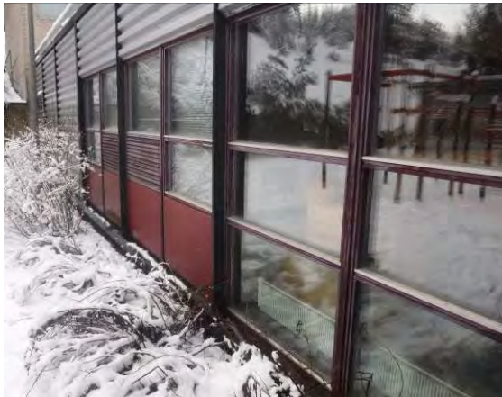
Alkuperäistä ikkunaa; osassa ikkunoita on teräspuitteet
