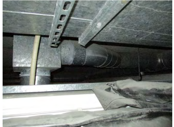
Ilmanvaihtokanavointia alas lasketun katon suojassa
