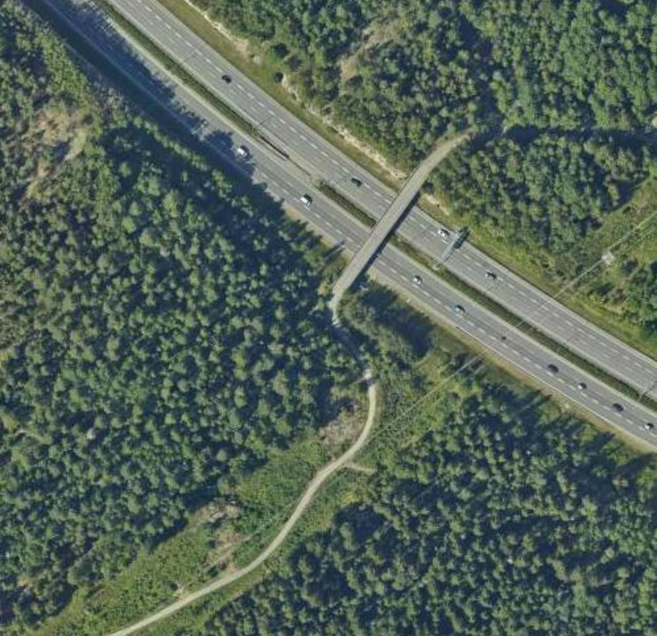
Helsingin valtatie ylittävällä sillalla on leveyttä n. 6 metriä, joten sille mahtuu hiihtolatu ja jk-pp-tie rinnakkain.
