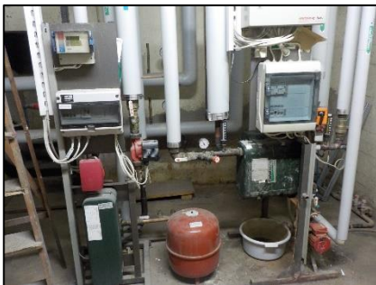
Kuva 3.13. Kaukolämpökeskukseen, sen lämmönvaihtimiin ja pumppuihin liittyviä lähestyviä korjaustarpeita ei kuntoarvion yhteydessä havaittu. Lämpöjohtoverkoston liitoksissa esiintyy paikallisesti korroosiota, mikä voi viitata lähestyvää uusimistarpeeseen.
