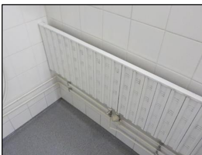
Kuva 3.14. Kuntoarvion yhteydessä ei havaittu vesikiertoisiin pattereihin tai niiden patteriventtiileihin liittyviä lähestyviä korjaustarpeita. Osa patteriventtiileistä on poistettu mitä ilmeisimmin estämään patterien tahaton/tahallinen säätäminen.
