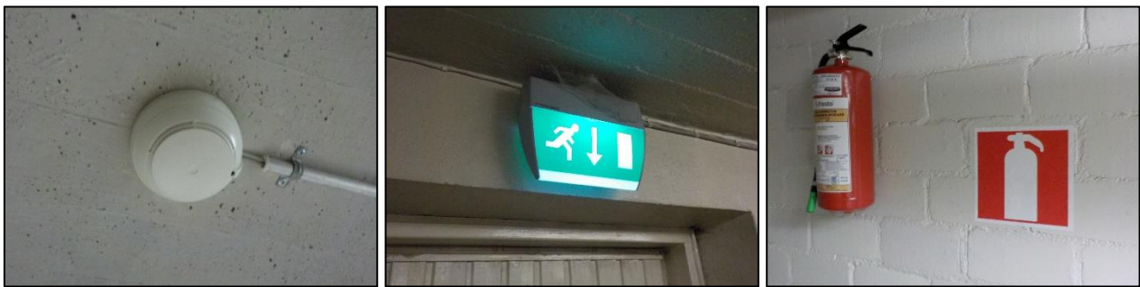
Kuva 3.21. Kuntoarvion havaintojen mukaan palontorjuntajärjestelmien määräaikaistarkastuksista on huolehdittu, eikä turvallisuusjärjestelmiin liittyviä puutteita kuntoarvion yhteydessä havaittu.
