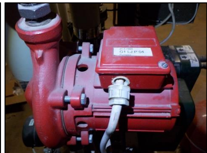
Kuva 3.13. Kaukolämpökeskukseen, sen lämmönvaihtimiin ja pumppuihin liittyviä lähestyviä korjaustarpeita ei kuntoarvion yhteydessä havaittu. Lämpöjohtoverkoston liitoksissa esiintyy paikallisesti korroosiota, mikä voi viitata lähestyvää uusimistarpeeseen.
