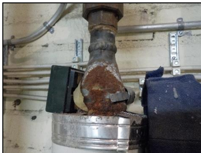
Kuva 3.13. Kaukolämpökeskukseen, sen lämmönvaihtimiin ja pumppuihin liittyviä lähestyviä korjaustarpeita ei kuntoarvion yhteydessä havaittu. Lämpöjohtoverkoston liitoksissa esiintyy paikallisesti korroosiota, mikä voi viitata lähestyvää uusimistarpeeseen.
