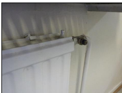
Kuva 3.14. Kuntoarvion yhteydessä ei havaittu vesikiertoisiin pattereihin tai niiden patteriventtiileihin liittyviä lähestyviä korjaustarpeita. Osa patteriventtiileistä on poistettu mitä ilmeisimmin estämään patterien tahaton/tahallinen säätäminen.
