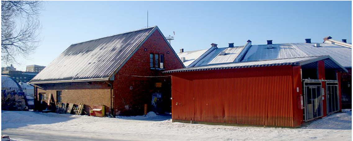
Kuva 5. Entinen tynnyrivarasto (vasemmalla). Oikealla olevan varastokatoksen paikalle on voimassa olevassa asemakaavassa osoitettu 3-kerroksisen uudisrakennuksen paikka.
