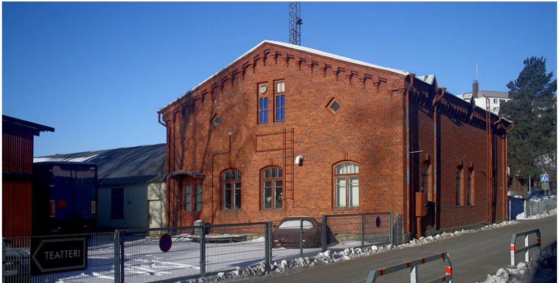
Kuva 6. Varasto (1901) ja siihen liittyvä peltihalli.
