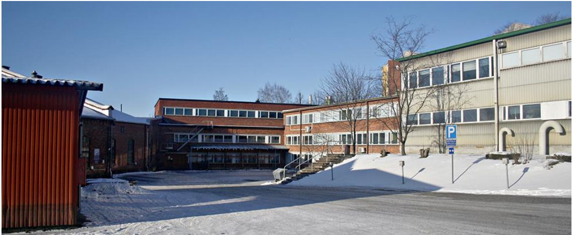
Kuva 7. Veturitalin pohjoispuolella sijaitseva toimistorakennus, jossa sijaitsee ratapihan ohjauskeskus.
