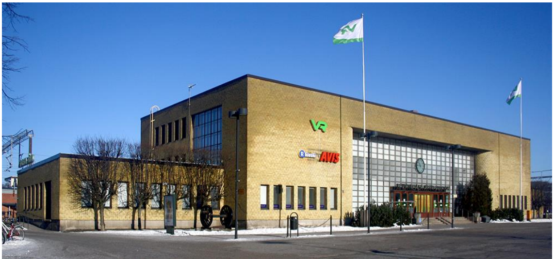
Kuva 10. Turun päärautatieaseman asemarakennus.
