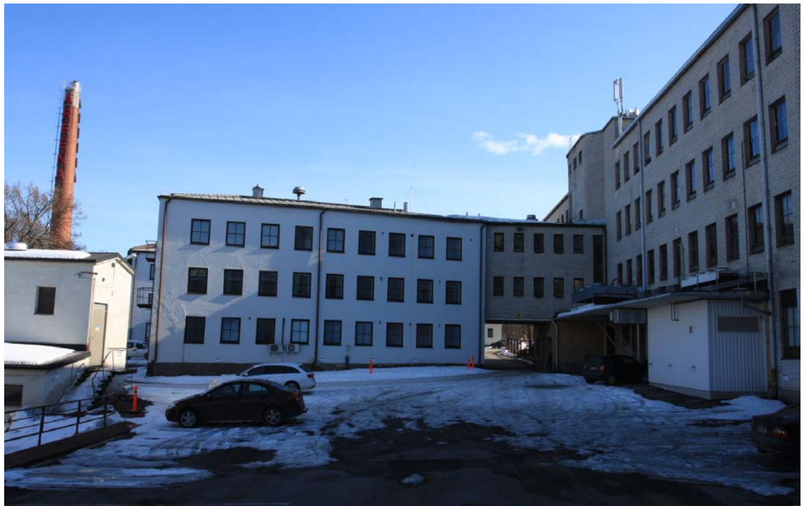
Suojeltavaksi esitetyt suklaatehdas ja konttorirakennus sekä tehtaan piippu pihalta.
