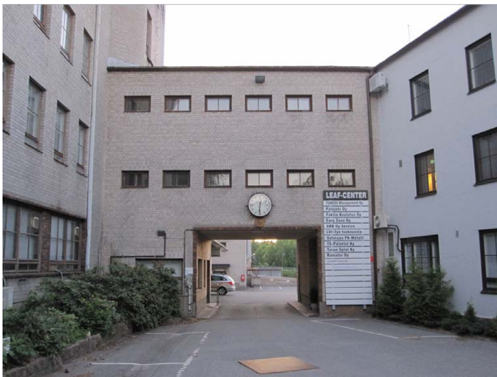
Suklaatehtaan ja konttorirakennuksen yhdyskäytävä sisäpihalla Kuva: Hannu Klemola
