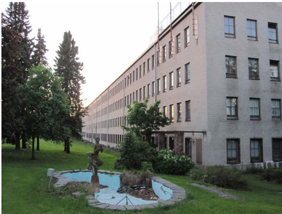
Suihkulähde suklaatehtaan tilitoimiston sisäänkäyntipergolan edessä Kuva: Hannu Klemola
