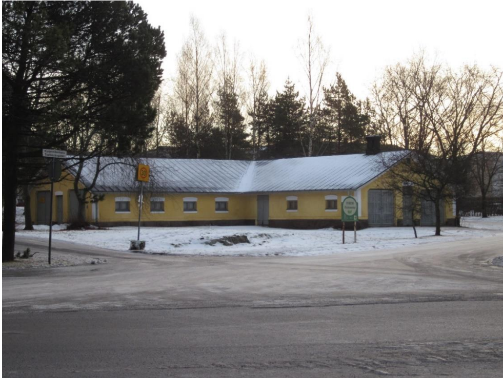
Kuva 9. Rakennuksen nro 36 länsijulkisivu.
