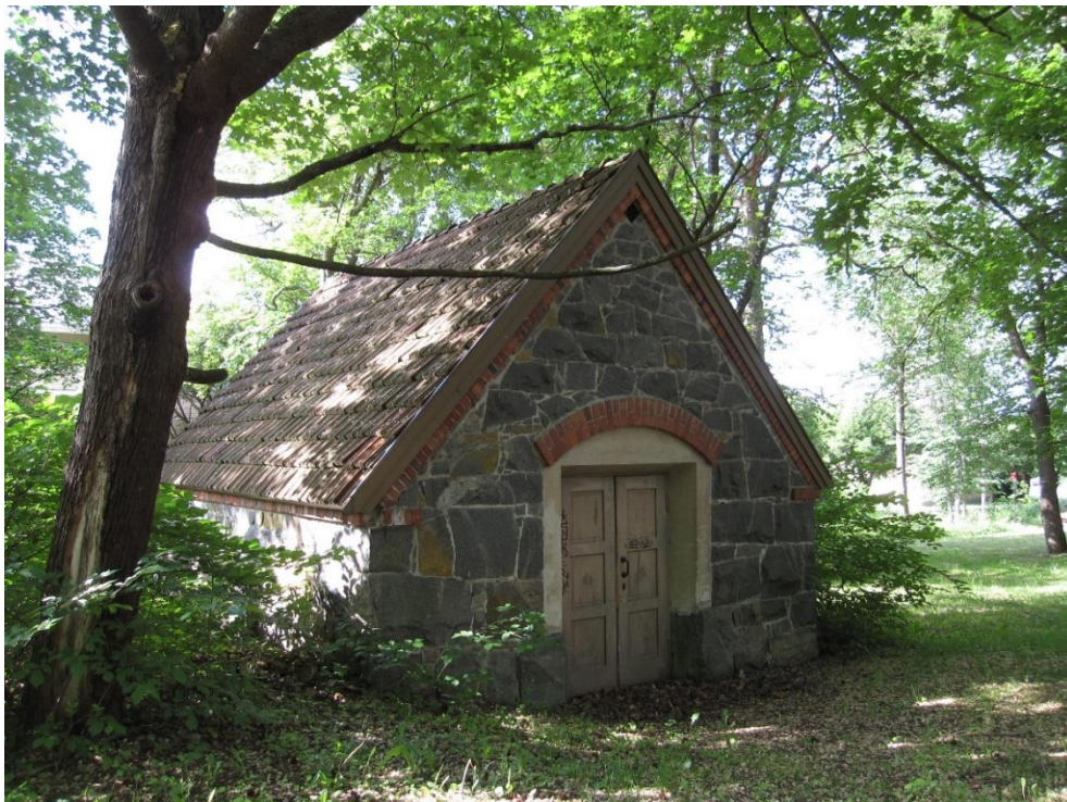
Kuva 10. Rakennuksen nro 35 julkisivu pohjoiseen.
