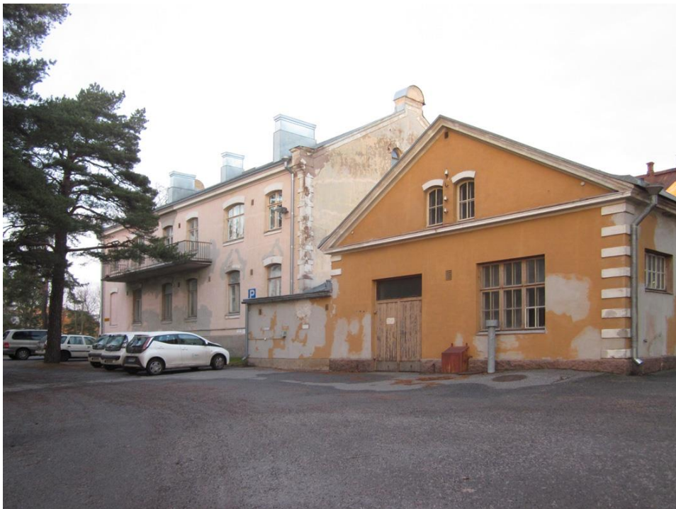
Kuva 6. Rakennuksen nro 32 länsijulkisivu.
