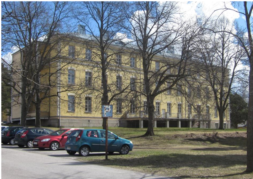
Kuva 7. Rakennuksen nro 31 länsijulkisivu.
