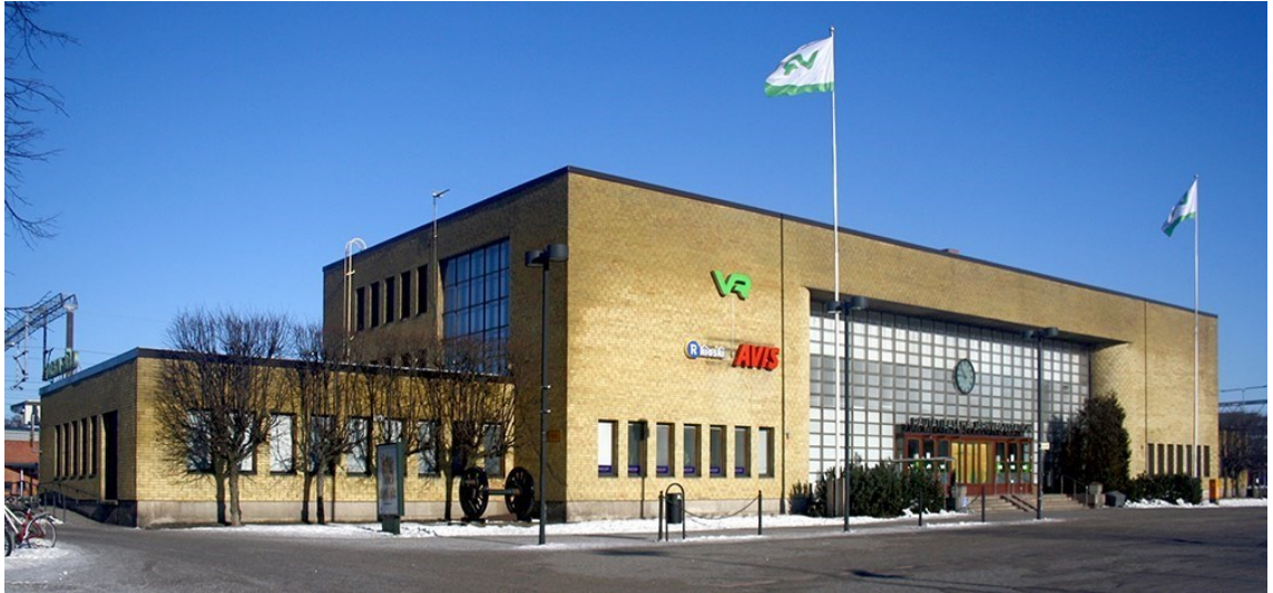
Kuva 12. Turun päärautatieaseman asemarakennus.
