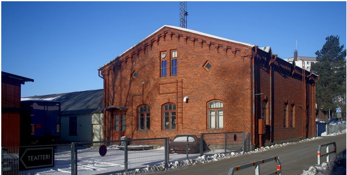
Kuva 7. Varasto (1901) ja siihen liittyvä peltihalli.
