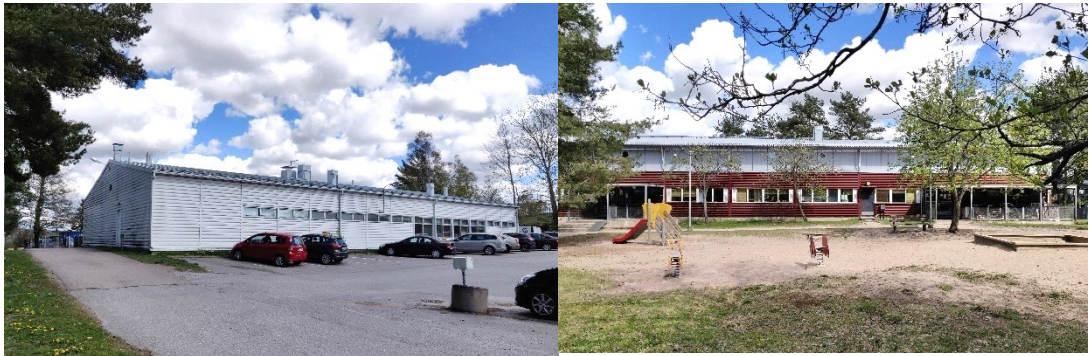
Kuva 7. Vasemmassa kuvassa huoltorakennus ja oikealla päiväkotirakennus.
