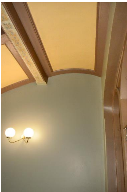
Vas.: Kerros- ja lepotasoja kannattelevat palkit ja kappaholvit. Kesk.: Huoneistojen viulutetut laakaovet ajoittuvat 1960-luvun muutoksiin. Oik.: Valurautakaide.
