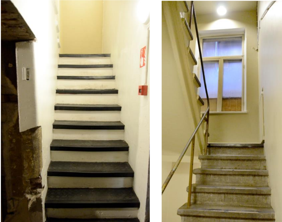
Näkymät kellarikerroksesta (vas.) ja ensimmäisestä kerroksesta (oik.) seuraaville lepotasoille.
