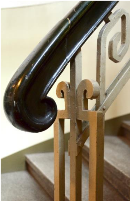
Vas.: C-portaassa on siro, vaalean harmaaksi maalattu, koristeellinen takorautakaide. Puisen käsijohteen profiili poikkeaa muiden portaiden käsijohteista. Keskellä D-portaan kuudes kerrostaso ja oikealla B-portaan ylin välitaso.
