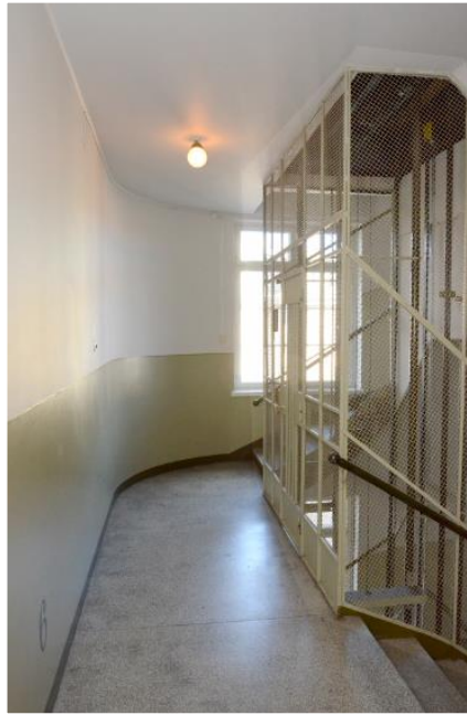
Vas.: C-portaassa on siro, vaalean harmaaksi maalattu, koristeellinen takorautakaide. Puisen käsijohteen profiili poikkeaa muiden portaiden käsijohteista. Keskellä D-portaan kuudes kerrostaso ja oikealla B-portaan ylin välitaso.
