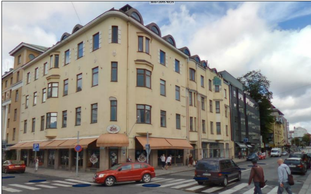
Kuva 45. Lampun talo. Katunäkymä Kauppiaskadun ja Linnankadun kulmasta.
