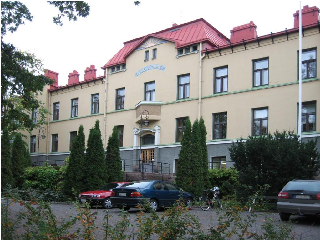
Kuva 5. Ukkokodin päärakennus ennen lasiterassin rakentamista. © Kaarin Kurri 2006.
