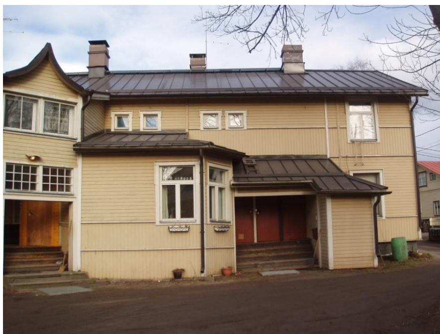
TUHOUTUNEEN RAKENNUKSEN JULKISIVU (OSA)
