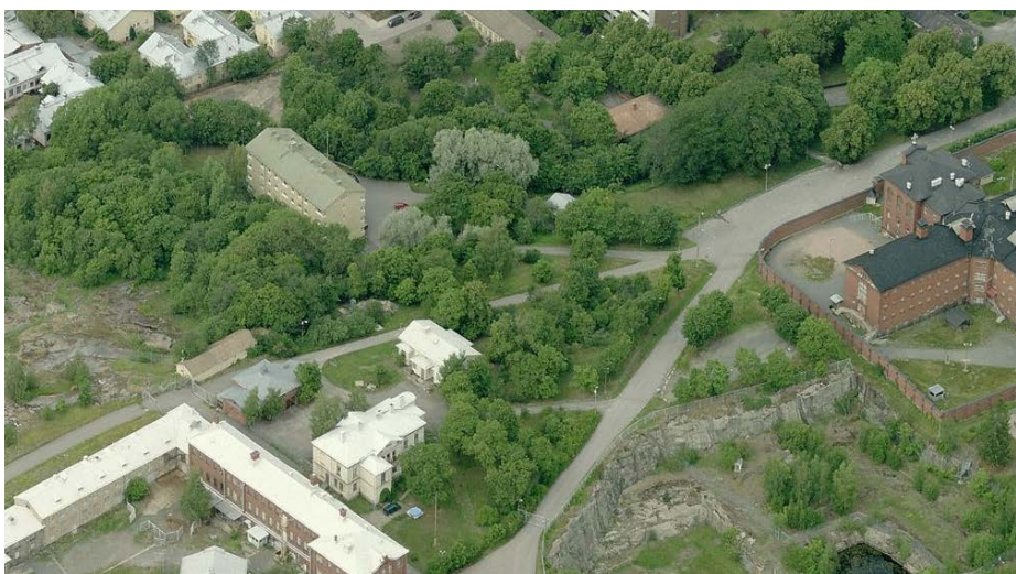
Viistoilmakuvassa keskellä ent. vankilajohtajan virka-asunto pihapiireineen
